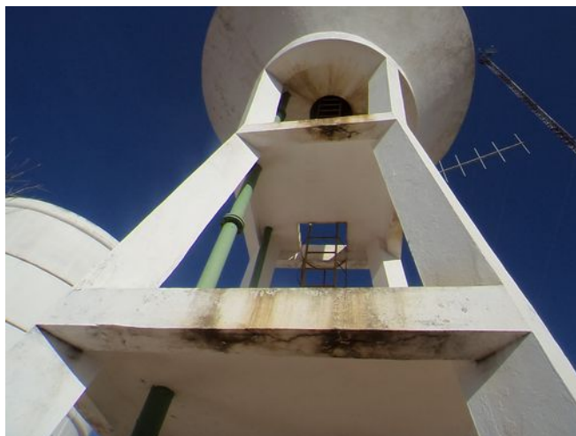
Foto 3 - REL-01: estrutura adequada após conserto da armadura que estava exposta.
