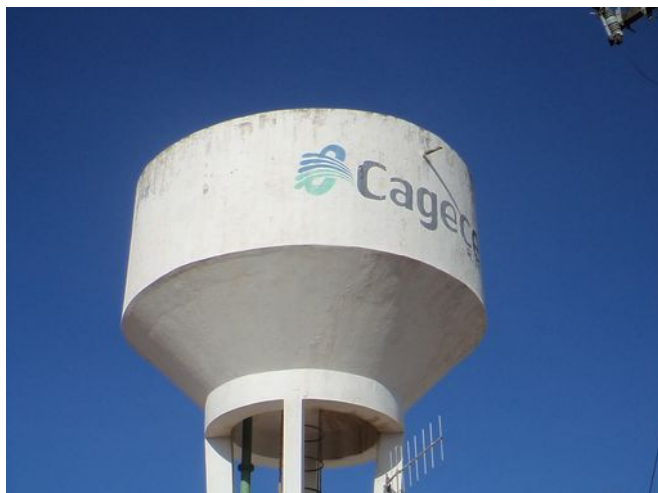
Foto 2 - REL-01: Pintura adequada.
