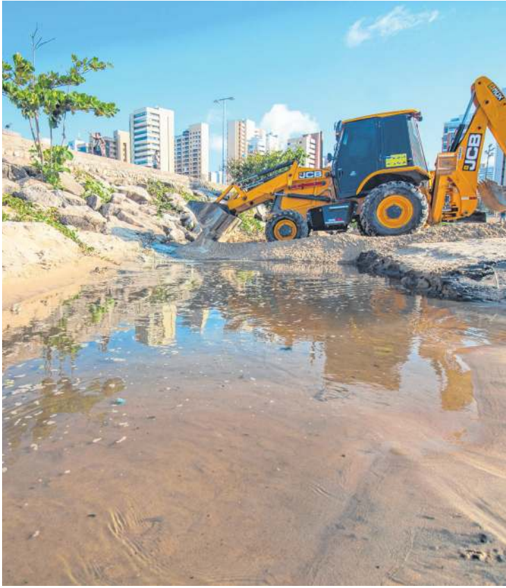
LIMPEZA no trecho da Praia dos Crush, onde houve estouro de encanamento de esgoto
