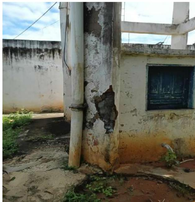
Foto 4 - Reservatório elevado (desativado) com estrutura comprometida ao lado do RAP-11
