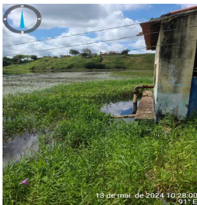
Foto 2 - EEAB - captação em local próximo à vegetação.
