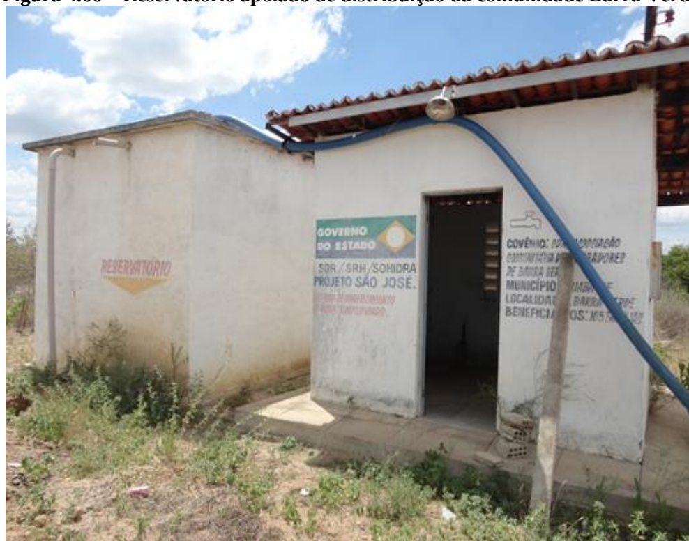
Figura 4.66 – Reservatório apoiado de distribuição da comunidade Barra Verde
