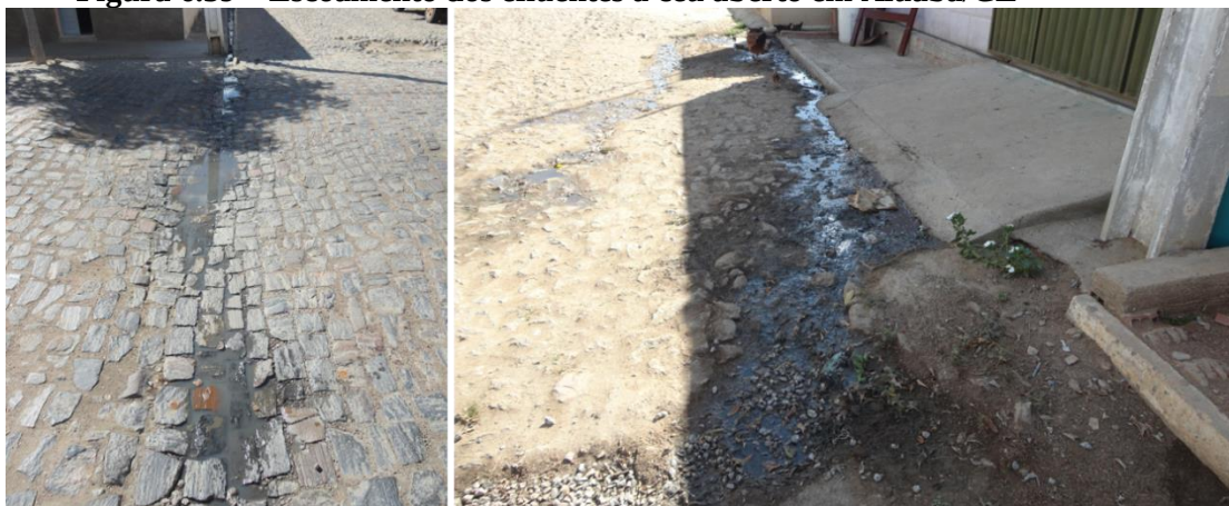
Figura 6.39 – Escoamento dos efluentes a céu aberto em Aiuaba/CE
