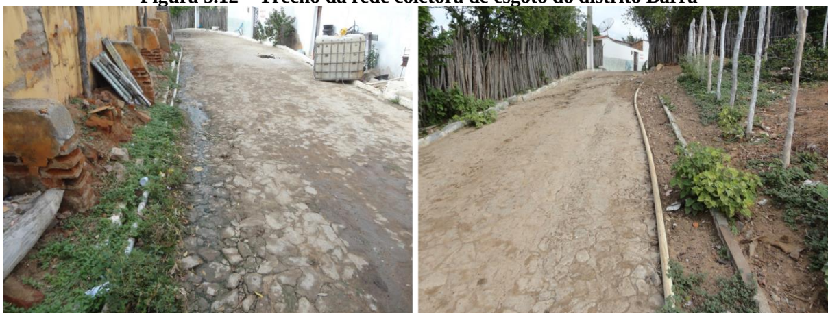
Figura 5.12 – Trecho da rede coletora de esgoto do distrito Barra
