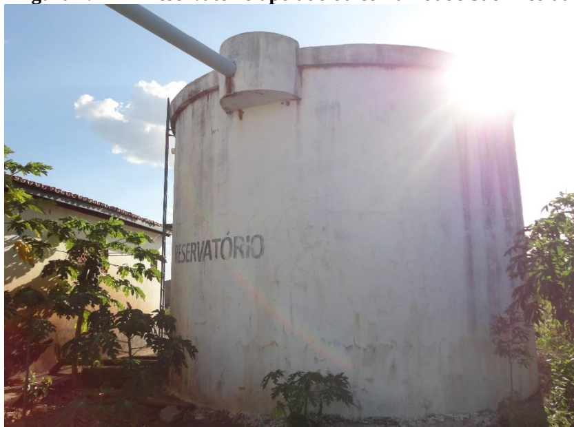
Figura 4.121 – Reservatório apoiado da comunidade São Nicolau
