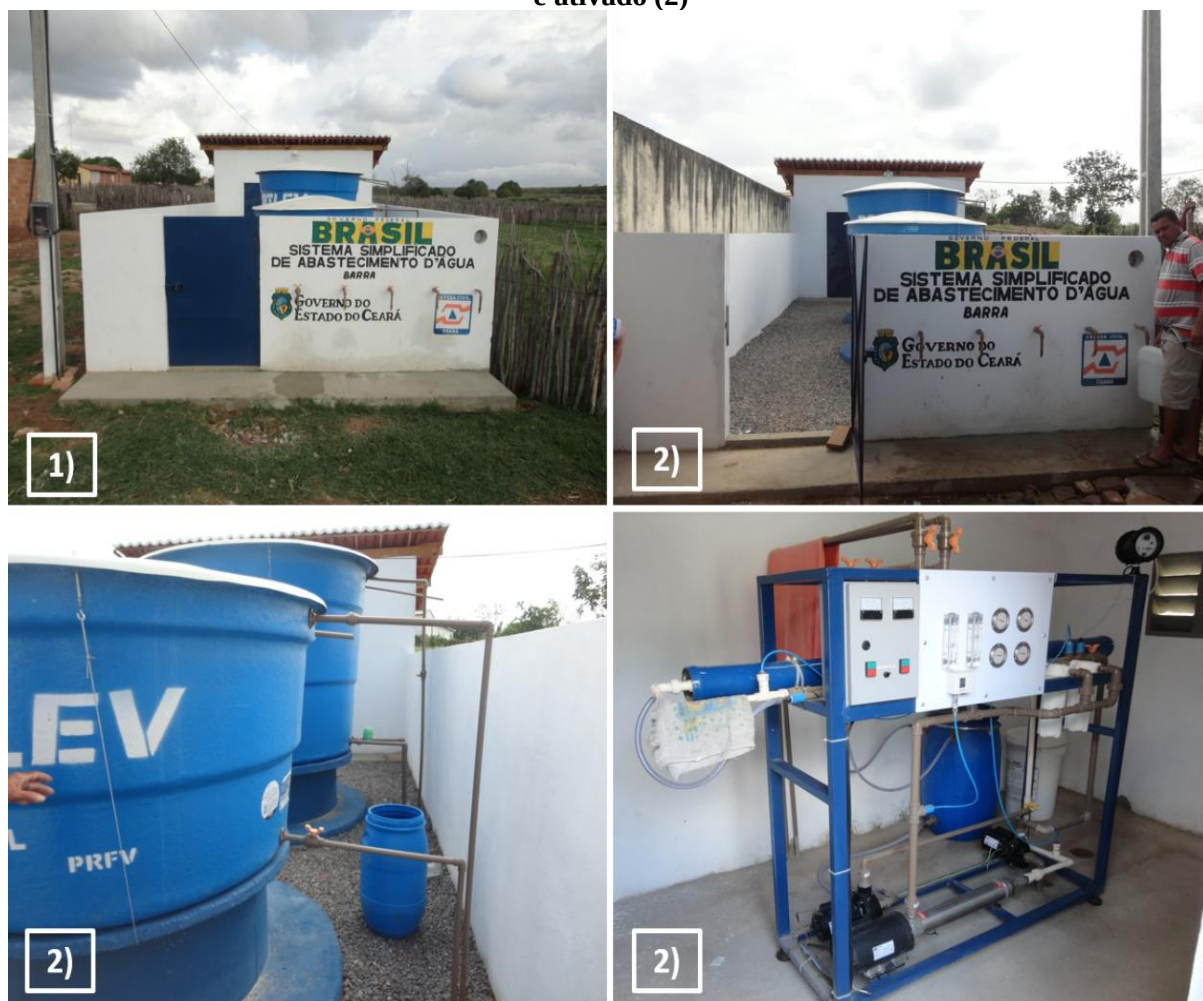
Figura 4.82 – Sistemas simplificados de abastecimento de água do distrito Barra: desativado (1) e ativado (2)
