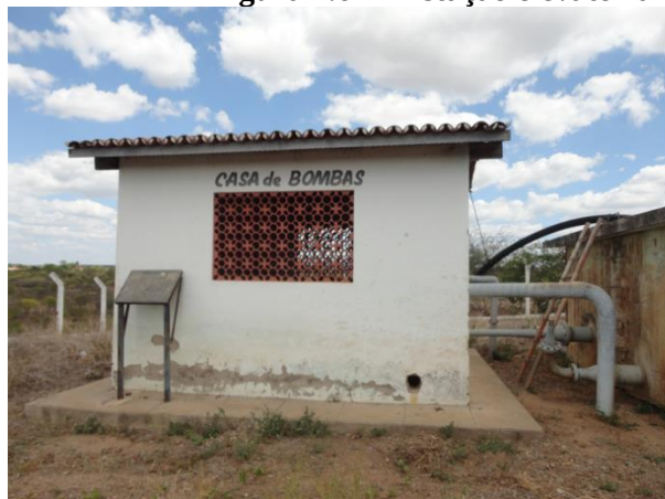
Figura 4.61 – Estação elevatória de água tratada localizada na ETA
