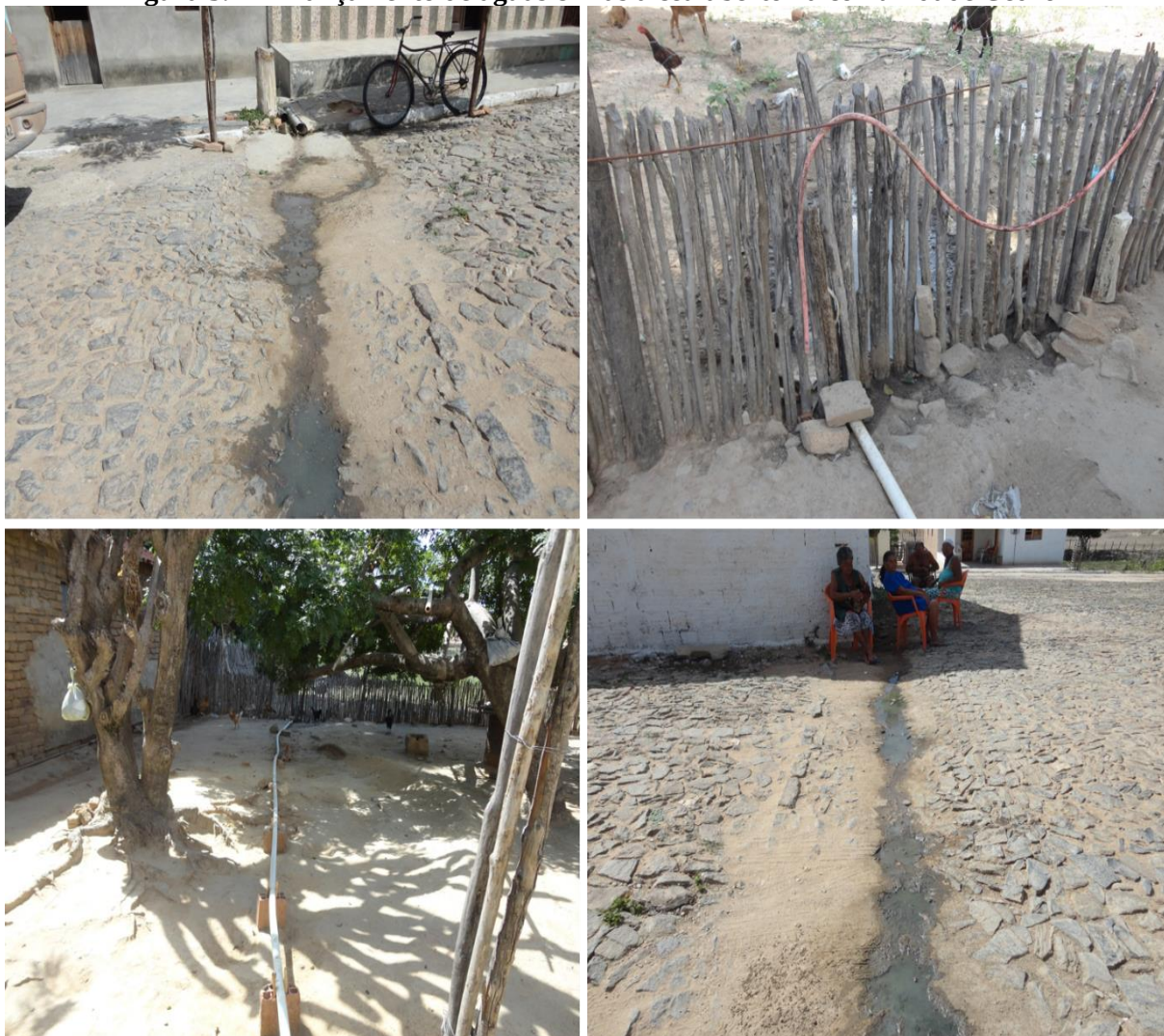
Figura 5.24 – Lançamento de águas cinzas a céu aberto na comunidade Cedro
