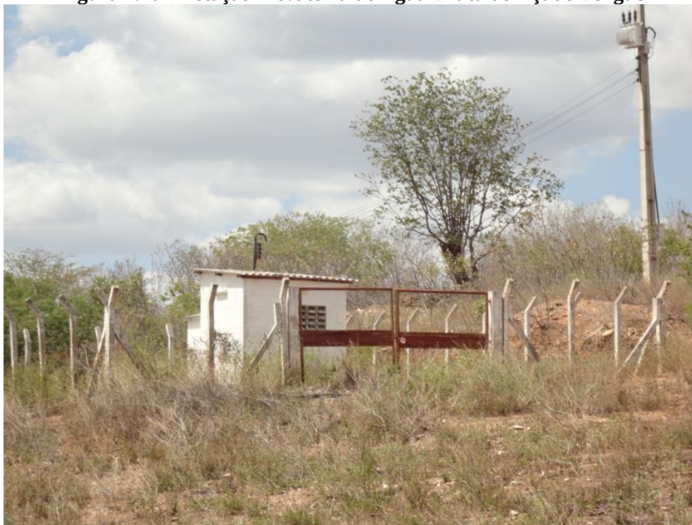
Figura 4.40 – Estação Elevatória de Água Bruta do Açude Benguê
