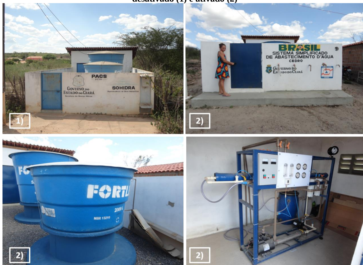
Figura 4.84 – Sistemas simplificados de abastecimento de água da comunidade Cedro: desativado (1) e ativado (2)
