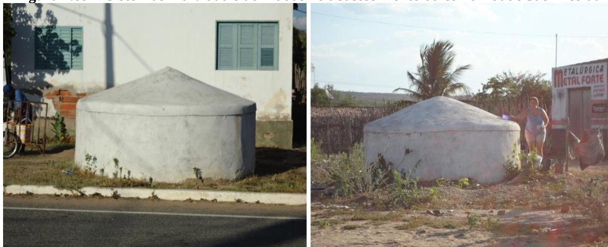
Figura 4.89 – Cisternas individuais utilizadas no abastecimento da comunidade São Nicolau
