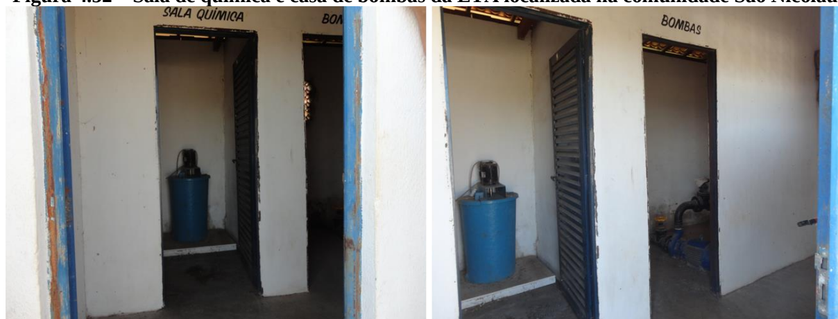
Figura 4.52 – Sala de química e casa de bombas da ETA localizada na comunidade São Nicolau
