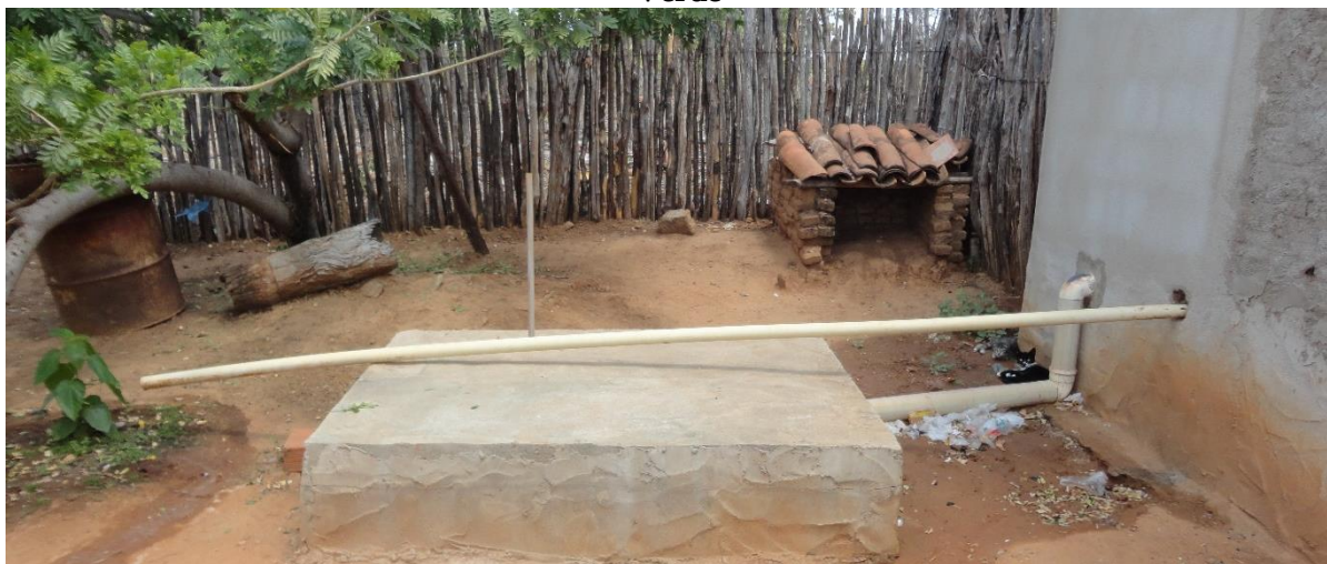
Figura 5.26 – Fossa rudimentar e lançamento de efluentes a céu aberto na comunidade Barra Verde
