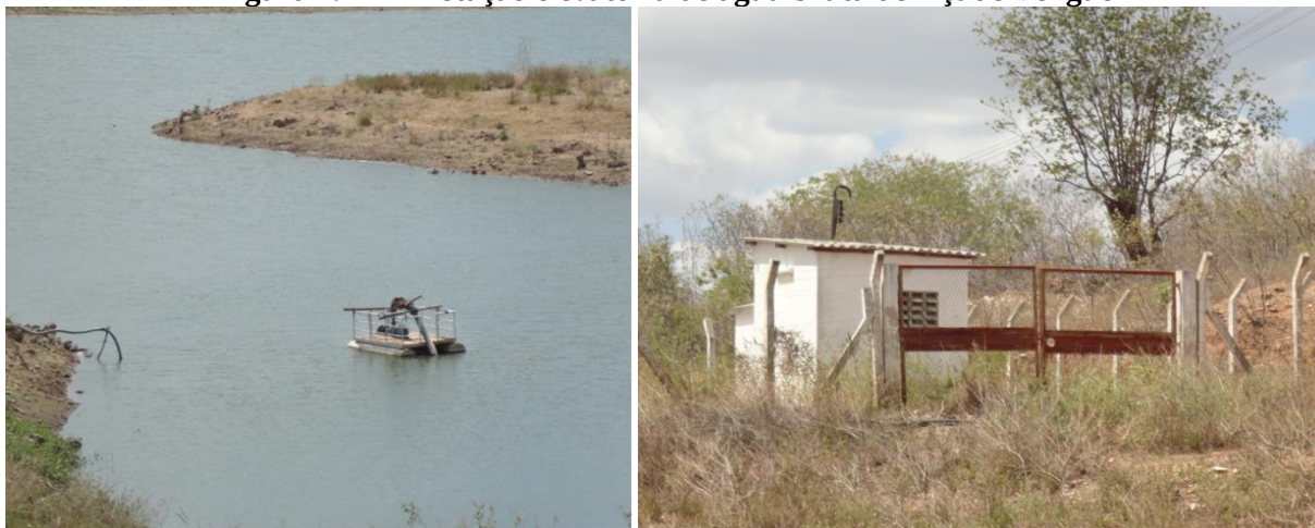
Figura 4.112 – Estação elevatória de água bruta do Açude Benguê
