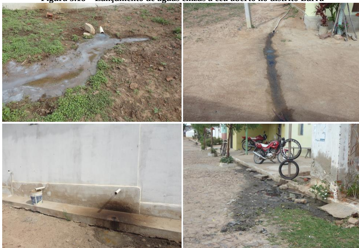
Figura 5.18 – Lançamento de águas cinzas a céu aberto no distrito Barra
