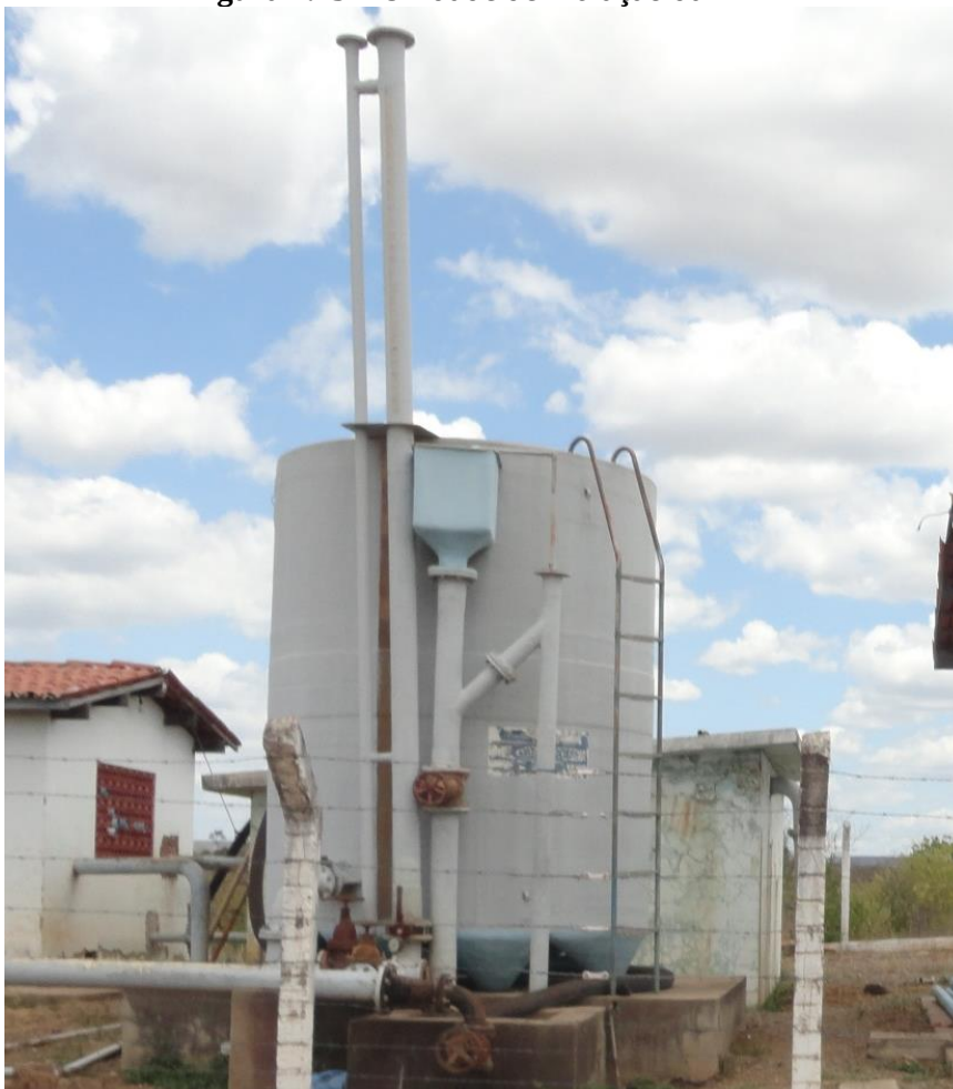
Figura 4.43 – Unidade de filtração da ETA
