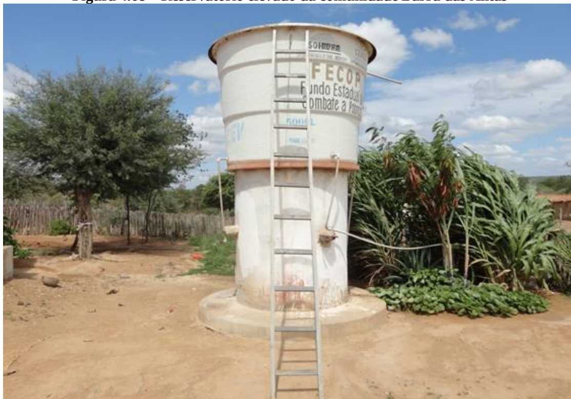
Figura 4.68 – Reservatório elevado da comunidade Barra das Antas
