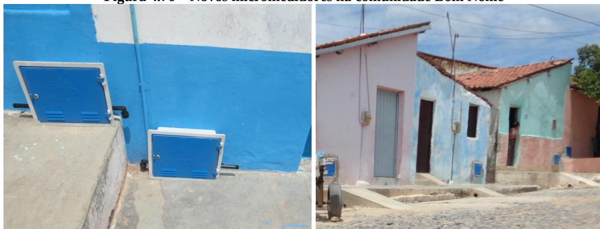
Figura 4.76 – Novos micromedidores na comunidade Bom Nome
