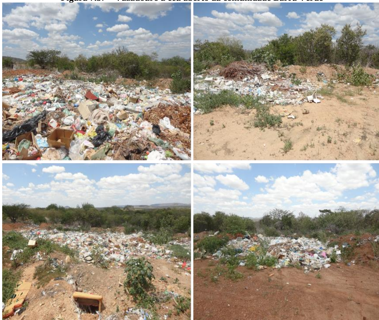
Figura 7.37 – Vazadouro a céu aberto da comunidade Barra Verde
