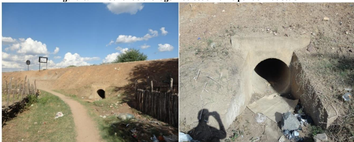
Figura 6.17 – Canal de drenagem da sede municipal de Aiuaba/CE
