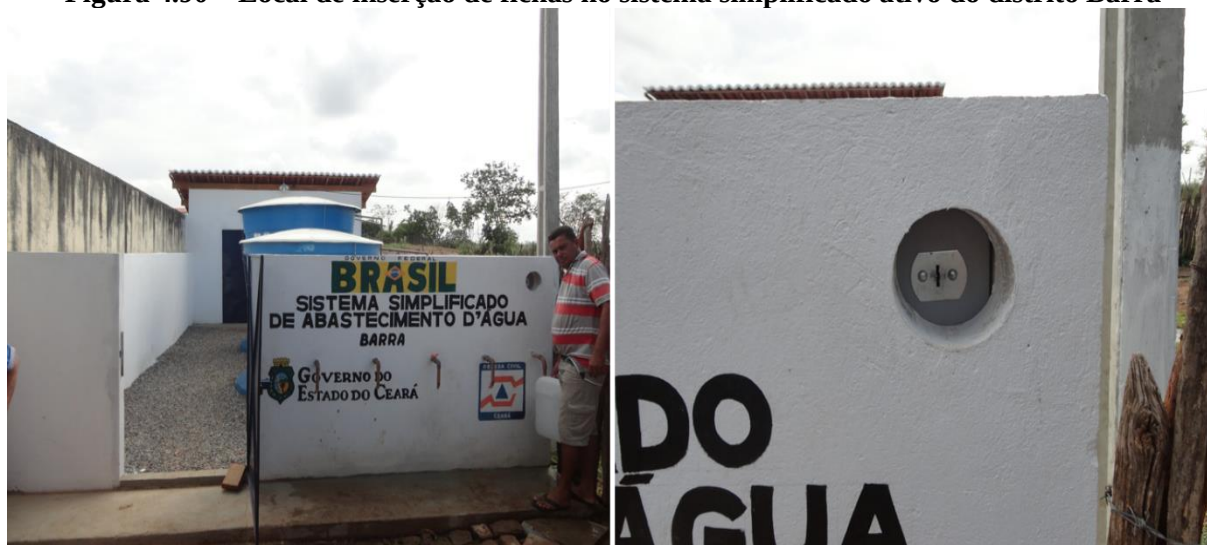
Figura 4.90 – Local de inserção de fichas no sistema simplificado ativo do distrito Barra
