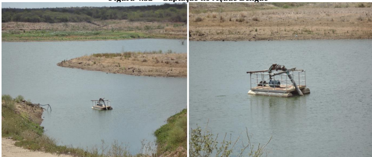
Figura 4.32 – Captação no Açude Benguê
