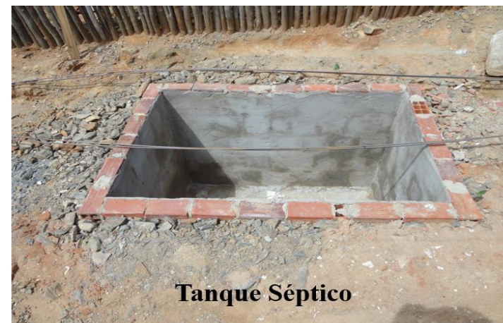
Figura 5.30 – Sistema individual de tratamento de esgotos na comunidade Bom Nome
