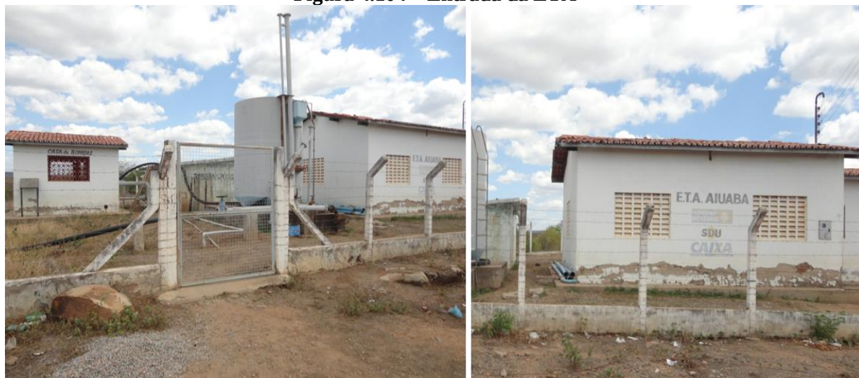
Figura 4.104 – Entrada da ETA
