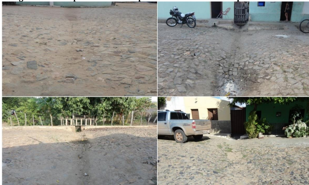
Figura 6.20 – Depressões nas vias pavimentadas sede municipal de Aiuaba/CE
