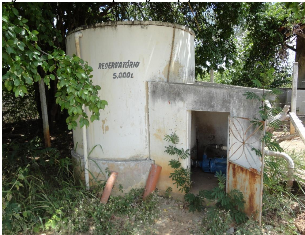
Figura 4.65 – Reservatório apoiado ligado ao poço da comunidade Barra Verde
