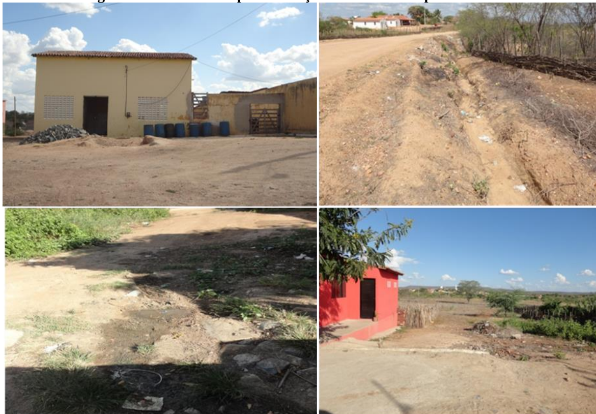
Figura 6.15 – Ruas sem pavimentação da sede municipal de Aiuaba/CE
