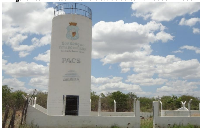
Figura 4.64 – Reservatório elevado da comunidade Mirador
