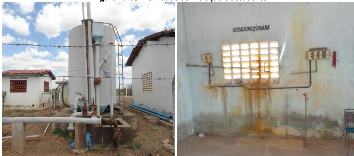
Figura 4.105 – Unidade de filtração e dosadores
