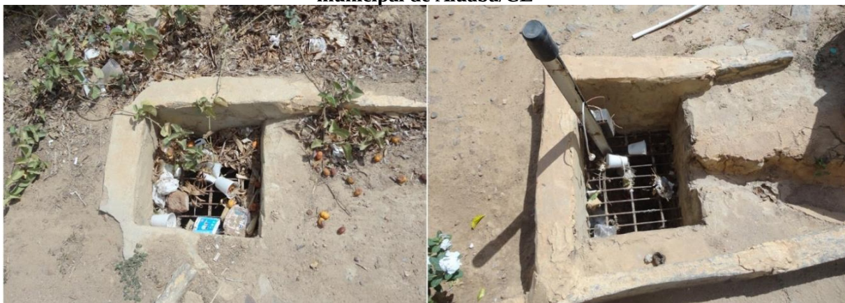
Figura 6.18 – Bocas de lobo das extremidades da galeria da comunidade Camarão da sede municipal de Aiuaba/CE
