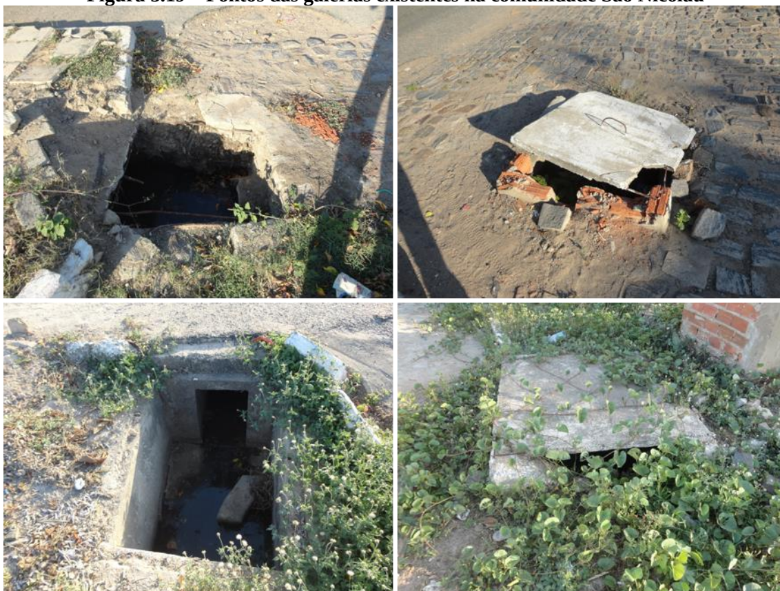
Figura 5.19 – Pontos das galerias existentes na comunidade São Nicolau
