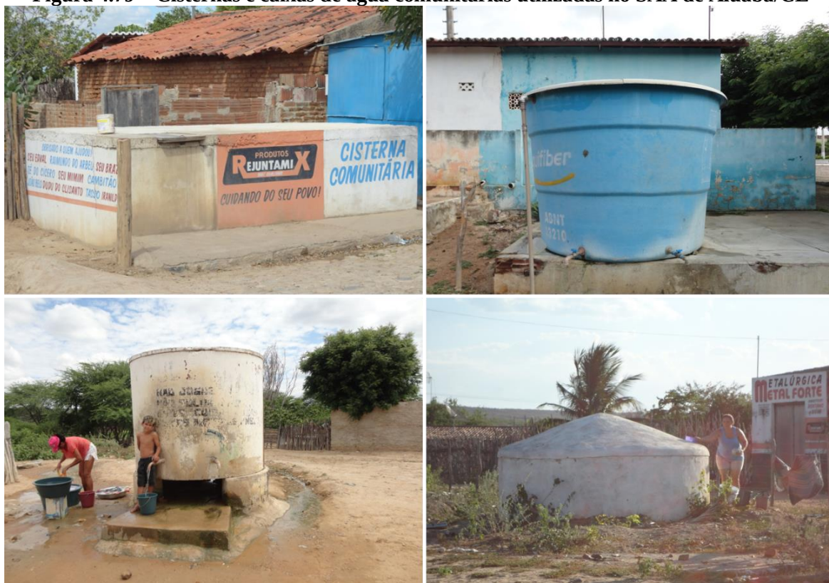
Figura 4.79 – Cisternas e caixas de água comunitárias utilizadas no SAA de Aiuaba/CE
