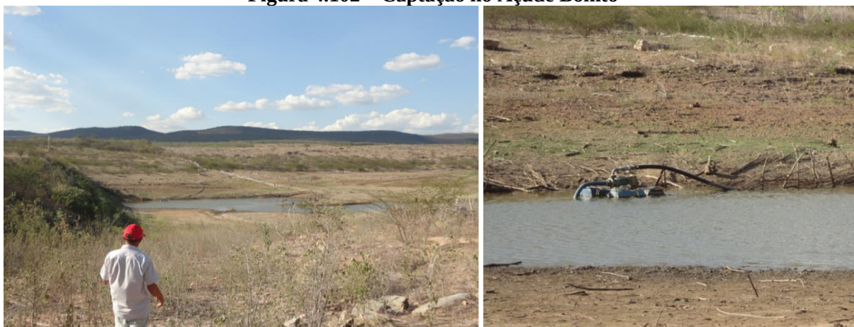
Figura 4.102 – Captação no Açude Bonito
