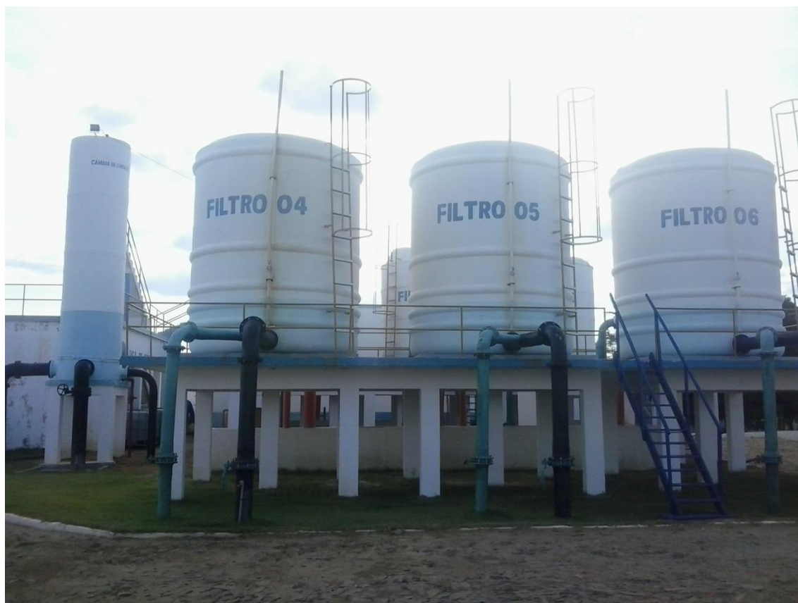
Figura 3.11 – Filtros em fluxo ascendente. Fonte: Conducto Engenharia (2018).
