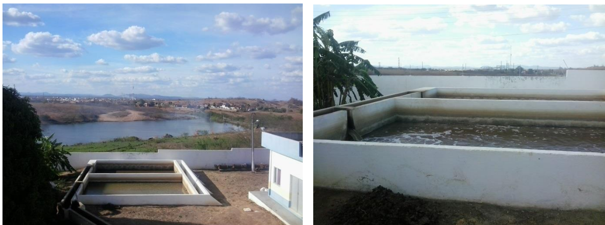
Figura 3.13 – Leitos de secagem.
