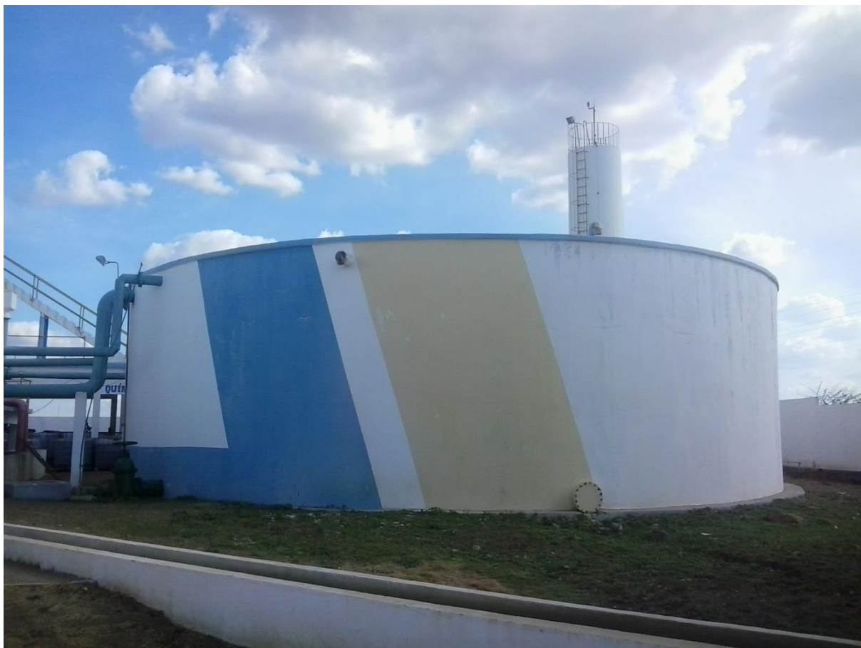
Figura 3.20 – Reservatório apoiado RAP de 1000 m 3 . Fonte: Conduto Engenharia (2018).
