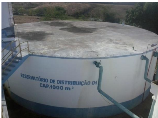
Figura 3.15 – Reservatório apoiado (RAP) existente na ETA.
