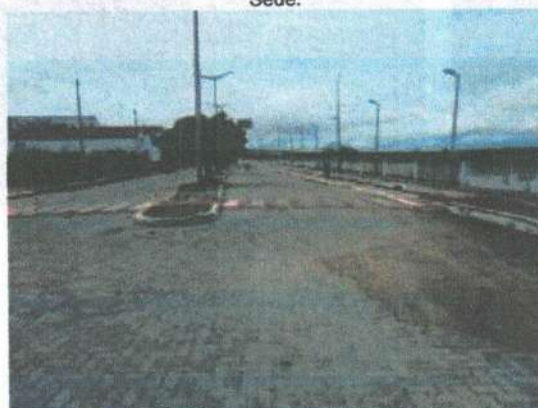
Figura 186: Calçamento polidrico em rua do distrito Sede.
