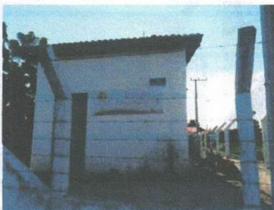
Figura 123: Casa de apoio – EEE-4.
