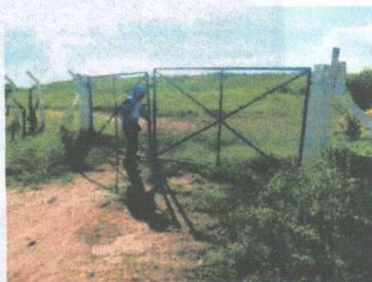
Figura 148: Entrada da estação de tratamento do SES da Sede de Jaguaribe.
