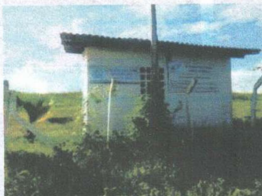
Figura 147: Entrada da estação de tratamento do SES da Sede de Jaguaribe.
