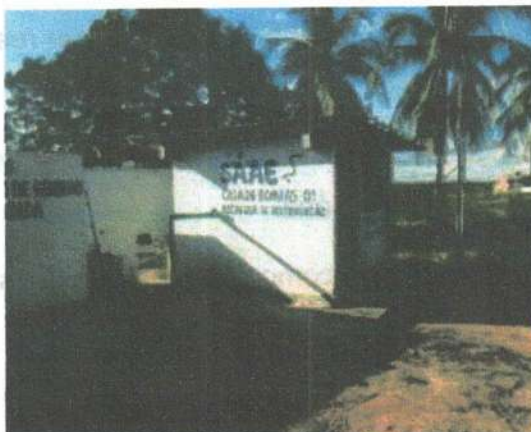
Figura 50: Casas de bombas.
