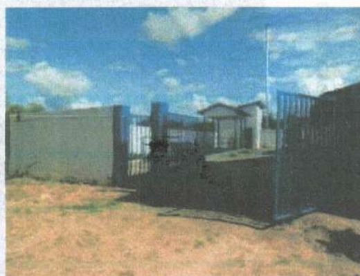
Figura 110: Entrada da EEE-1.
