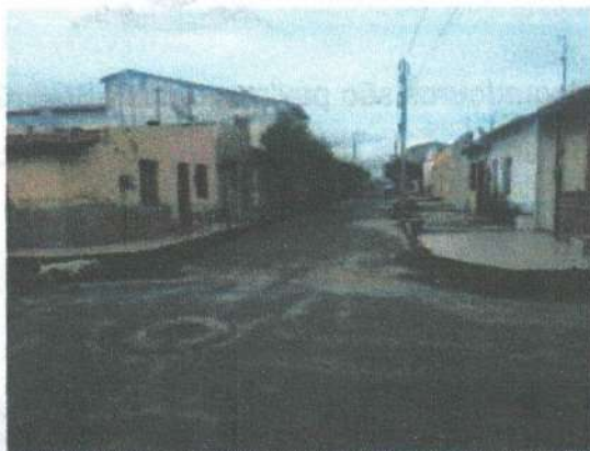
Figura 184: Pavimentação asfáltica em rua do Distrito de Sede.
