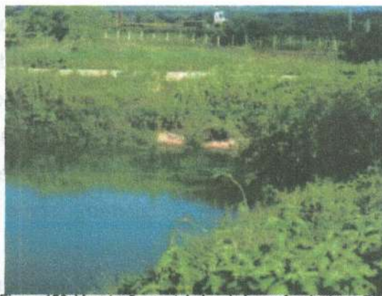
Figura 156: Vegetação nos taludes da lagoa facultativa – ETE Jaguaribe.
