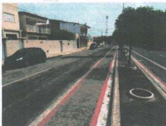
Figura 198: Sarjeta em logradouro no Distrito Sede.
