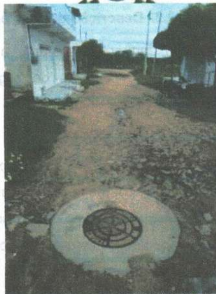
Figura 104: Poço de visita em rua do bairro Luiz Pinto - Distrito Sede.
