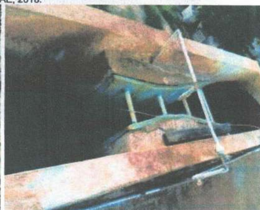
Figura 16: Calha Parshall
