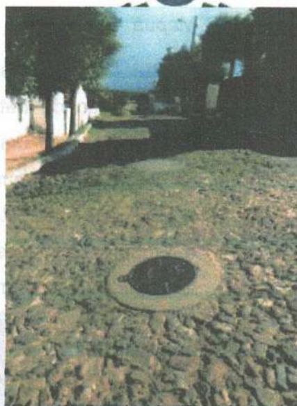
Figura 160: Poço de visita - Distrito de Mapua.
