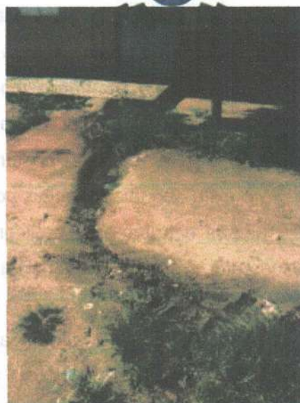
Figura 142: Vaia negra em rua do Bairro Celso Barreira Filho – Distrito Sede.
