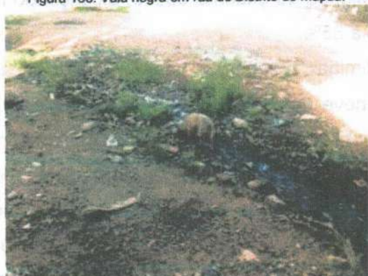
Figura 170: Vaia negra em rua do Distrito de Mapuá.
