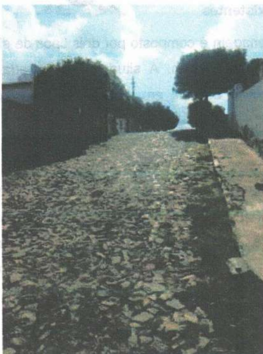
Figura 193: Logradouro com pavimentação com pedra e rachão no Distrito de Mapuá.
