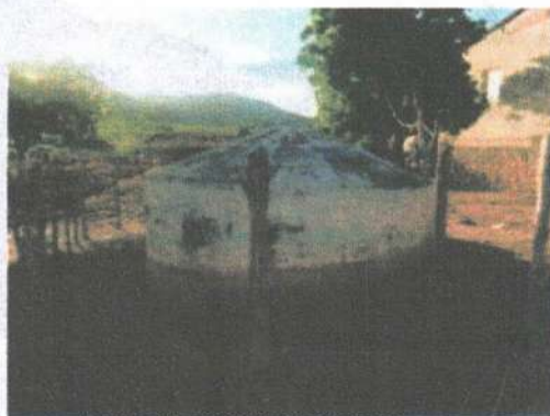
Figura 76: Cisterna em concreto
