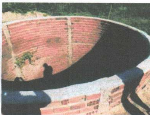
Figura 57: Poço – cacimbão.
