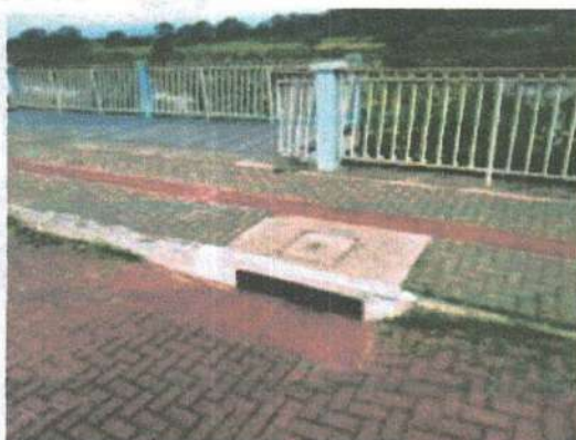
Figura 202: Boca-de-lobo em logradouro do Distrito Sede.
