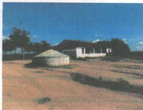
Figura 58: Cisterna de concreto
