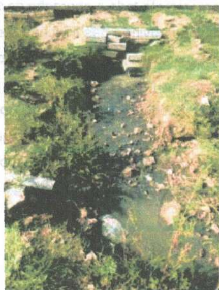
Figura 139: Vala negra em rua do Bairro Mutirão – Distrito Sede.
