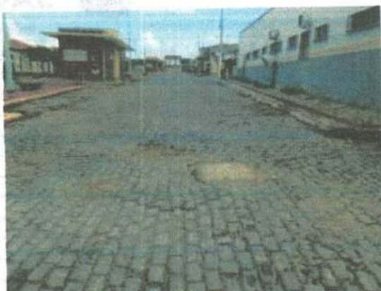
Figura 178: Estrutura do sistema coletor em logradouro do Distrito de Nova Floresta.
