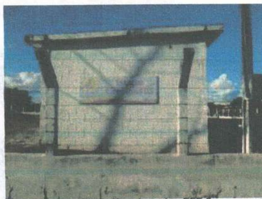
Figura 115: Casa de apoio – EEE-2.
