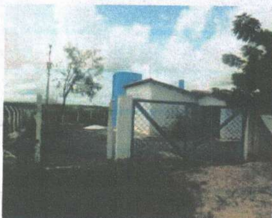
Figura 36: Vista externa ETA Jureminha
