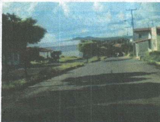
Figura 190: Pavimentação asfáltica em rua do Distrito de Feiticeiro.
