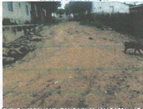
Figura 195: Logradouro sem pavimentação no Distrito de Mapuá.
