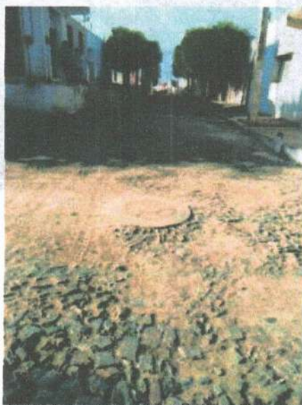
Figura 161: Poço de visita - Distrito de Mapua.
