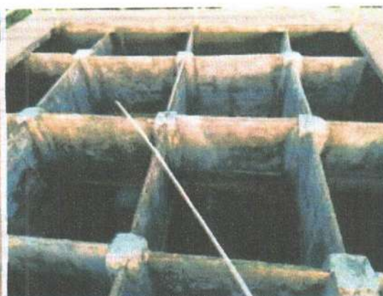
Figura 18: Floculador lamelar
