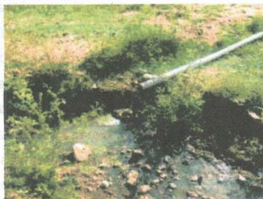
Figura 140: Vala negra em rua do Bairro Mutirão – Distrito Sede.
