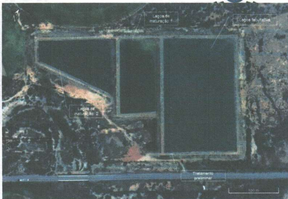
Figura 146: ETE Jaguaribe Sede – Lagoas de estabilização.
