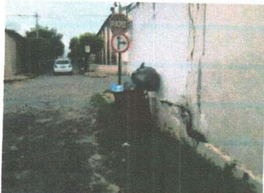
Figura 231: Caçambas utilizadas no acondicionamento dos resíduos para coleta, no Distrito Sede.
