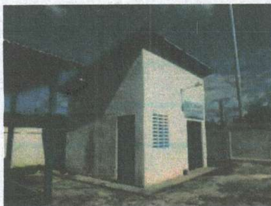
Figura 109: Casa de apoio – EEE-1.
