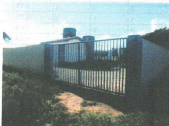
Figura 174: Entrada ETE Mapuá.
