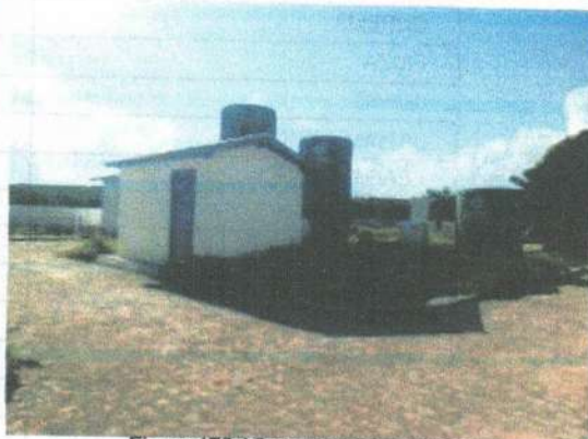
Figura 175: Vista geral da estação.
