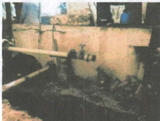
Figura 29: Obras booster mutirão.
