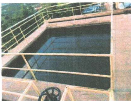
Figura 17: Decantador
