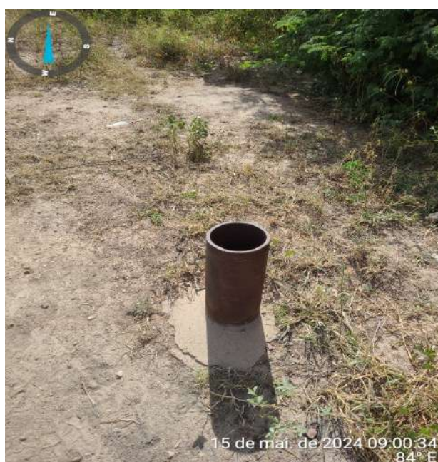
Foto 3 - Poço de captação (sede) - poço inativo com risco de acidentes.
