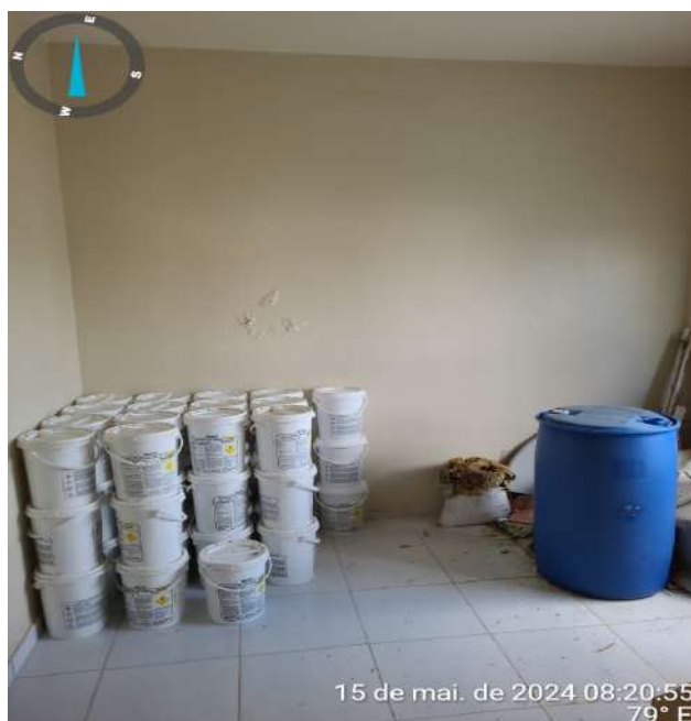
Foto 6 - ETA (sede) - local de armazenamento das pastilhas de cloro inadequado.
