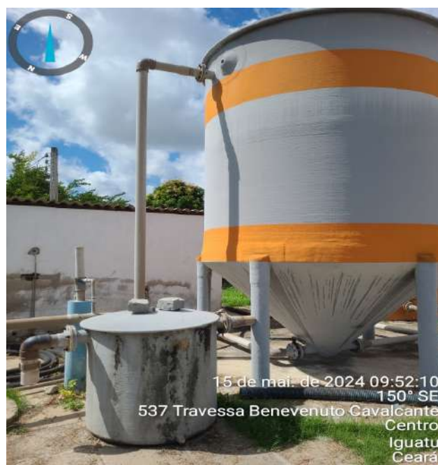
Foto 16 - ETA João Coelho (sede) - componentes do sistema sem escada.
