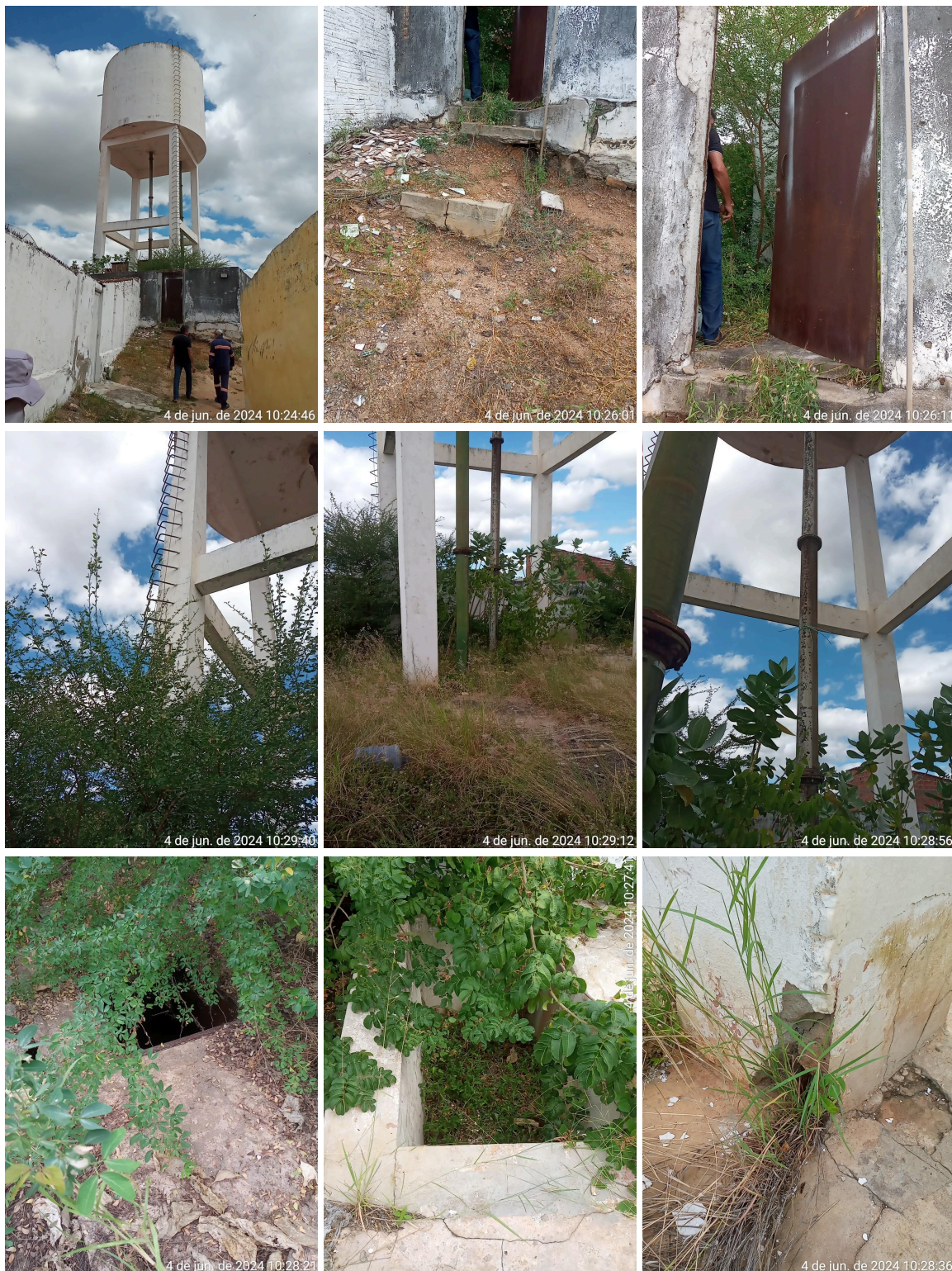
Figura 11. Reservatório elevado do SAA da Sede de Icó - Caixa da Rua.
