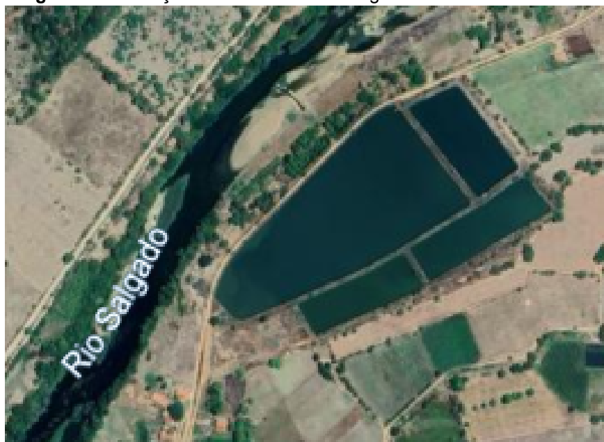
Figura 13. Estação de Tratamento de Esgoto da Sede de Icó.
