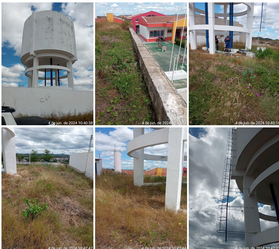
Figura 10. Reservatório elevado do SAA da Sede de Icó - Caixa do Alto.
