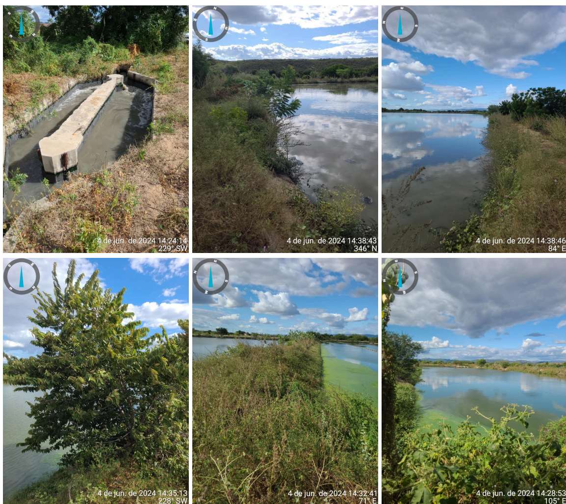
Figura 19. ETE - SES da Sede de Icó.
