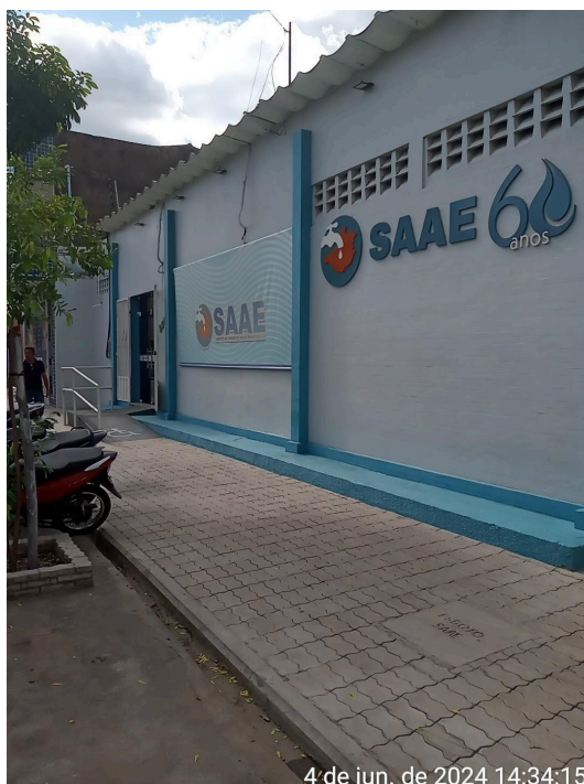
Figura 3. Fachada do prédio do escritório administrativo da Sede do SAAE.
