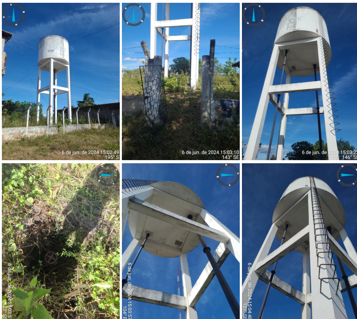
Figura 12. Reservatório elevado do SAA de Lima Campos.
