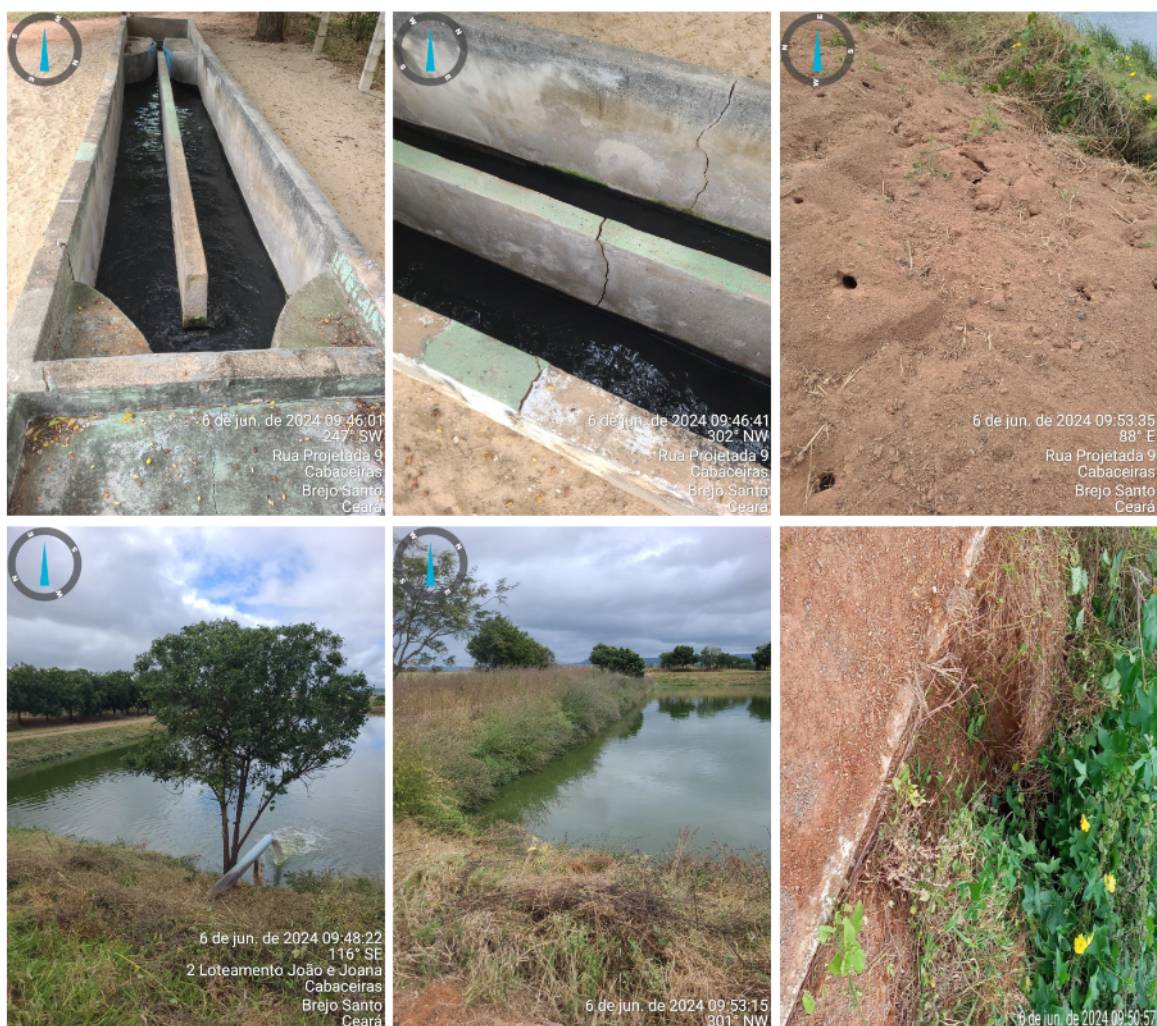
Figura 37. Estação de Tratamento de Esgoto.
