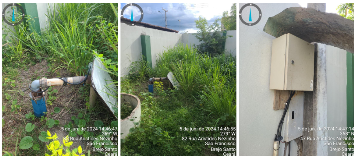
Figura 25. Poço João Landim.
