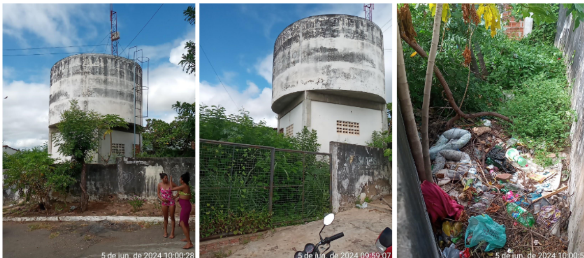
Figura 31. Reservatório Elevado - Caixa Alto da Bela Vista.
