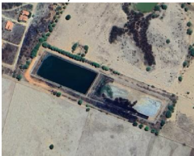
Figura 35. Estação de Tratamento de Esgoto da Sede de Brejo Santo.
