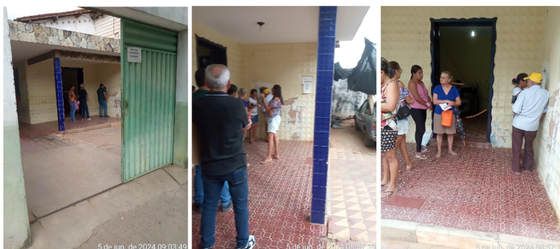
Figura 3. Imagem do prédio do escritório administrativo e do atendimento ao público da Sede do SAAE de Brejo Santo.
