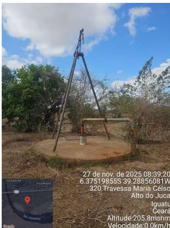
Foto 53 - Poço Amazonas sem proteção, área afetada pela extração de areia.
