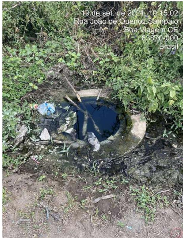
**Foto 12** - Lançamento de esgoto *in natura*.
