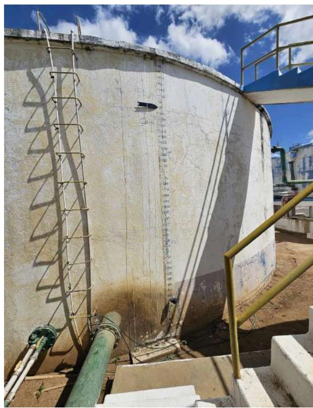
**Foto 6** - RAP-01 - Pintura deteriorada, escada sem guarda corpo e ausência de identificação.
