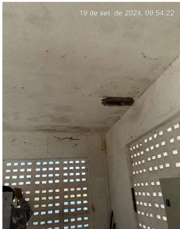
**Foto 8** - Casa de Comando da Captação - Apresenta pintura deteriorada e a armação do teto está exposta.
