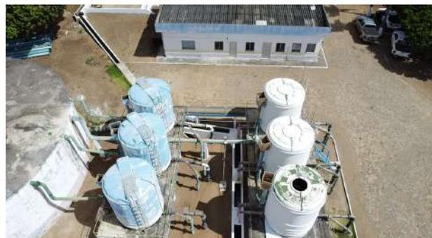
**Foto 2** - Filtros - Ausência de identificação e F-04 não possui tampa.
