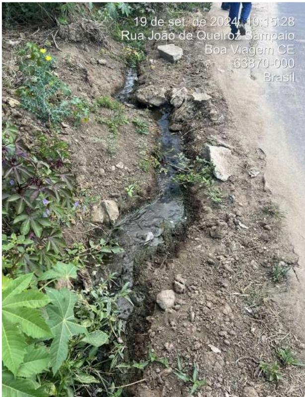
**Foto 11** - Lançamento de esgoto *in natura*.
