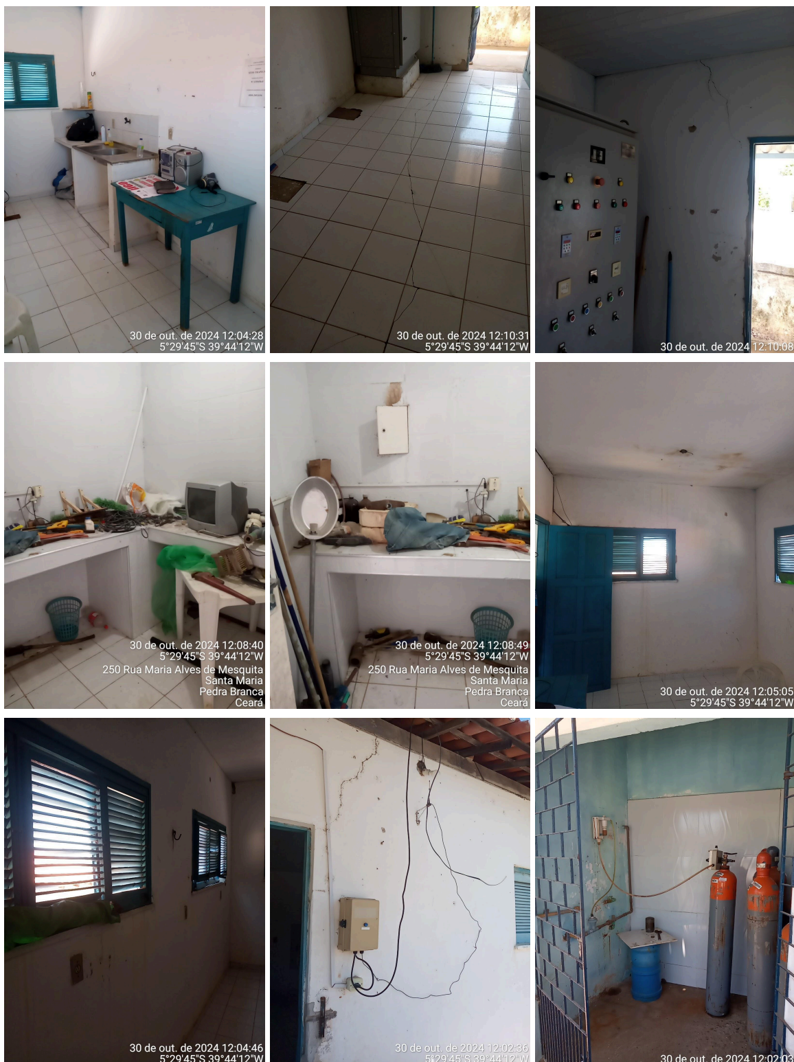
Figura 11. Prédio de Apoio / Laboratório
