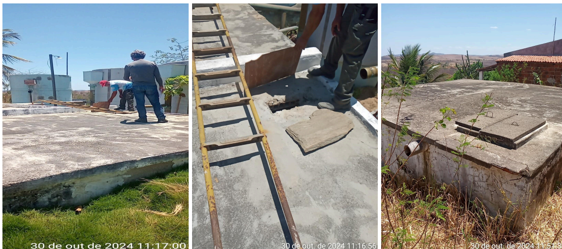
Figura 12. Reservatório Semi-Enterrado (RSE).
