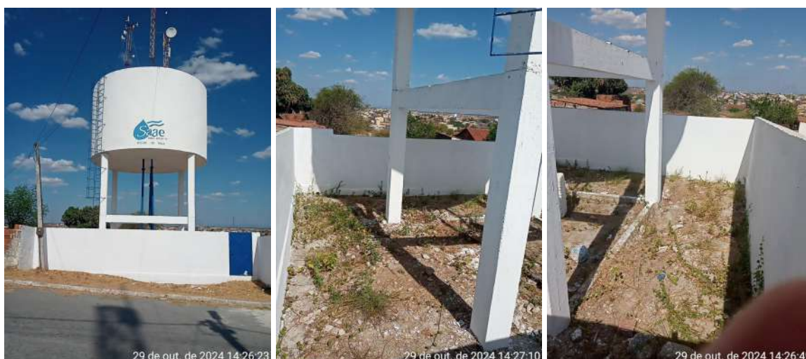
Figura 18. Reservatório Elevado - São Francisco.
