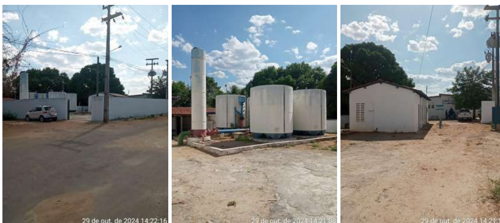
Figura 9. Vista Geral da ETA de Nova Russas.
