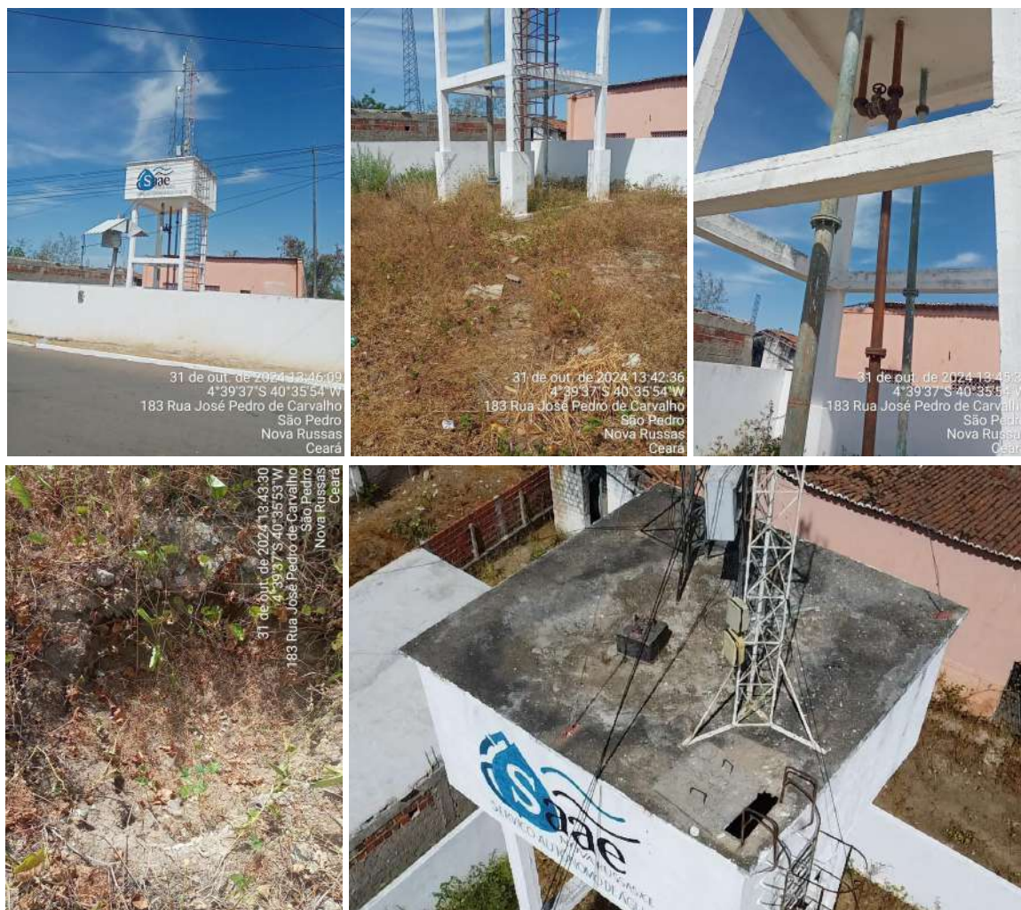
Figura 23. Reservatório Elevado - Localidade São Pedro.
