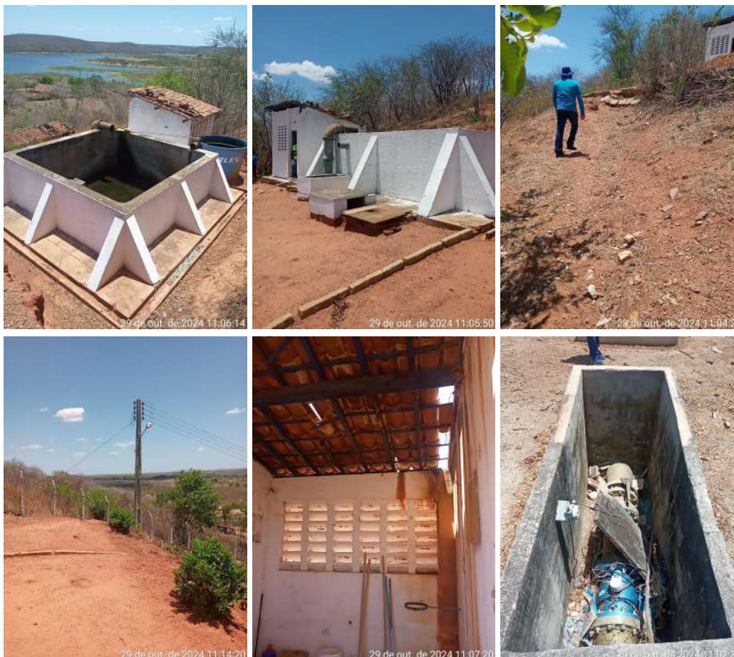
Figura 8. Imagens do reservatório apoiado (RAP do Açude).
