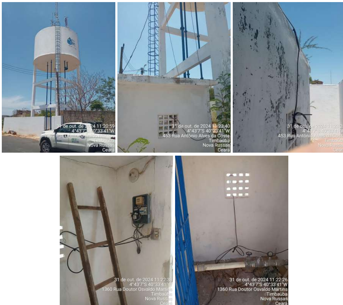
Figura 20. Reservatório Elevado - Timbaúba.
