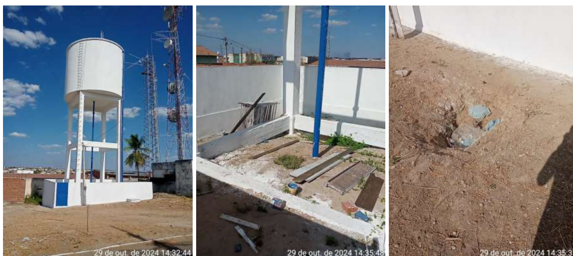
Figura 19. Reservatório Elevado - Centro.
