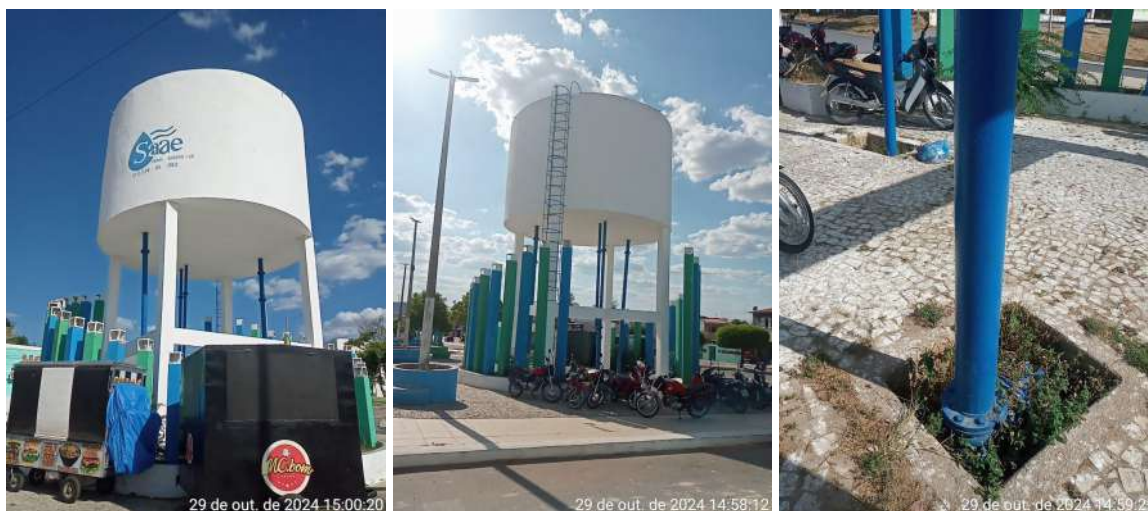
Figura 21. Reservatório Elevado - Rodoviária.
