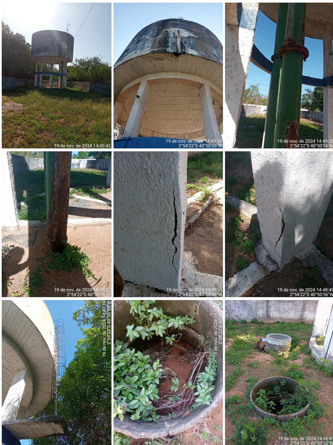
Figura 15. Reservatório Elevado - João Pessoa.
