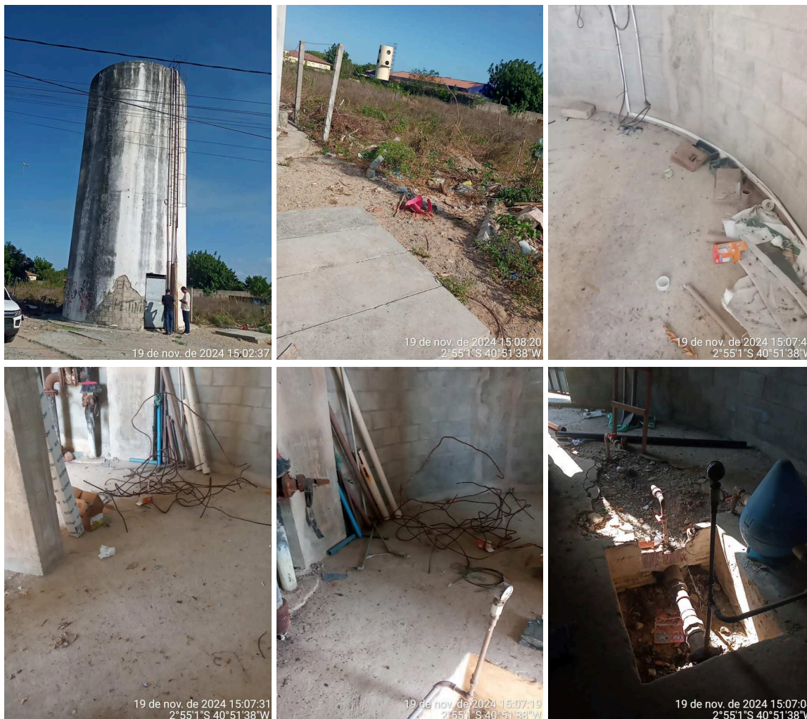
Figura 16. Reservatório Elevado - N. Sra. de Fátima.
