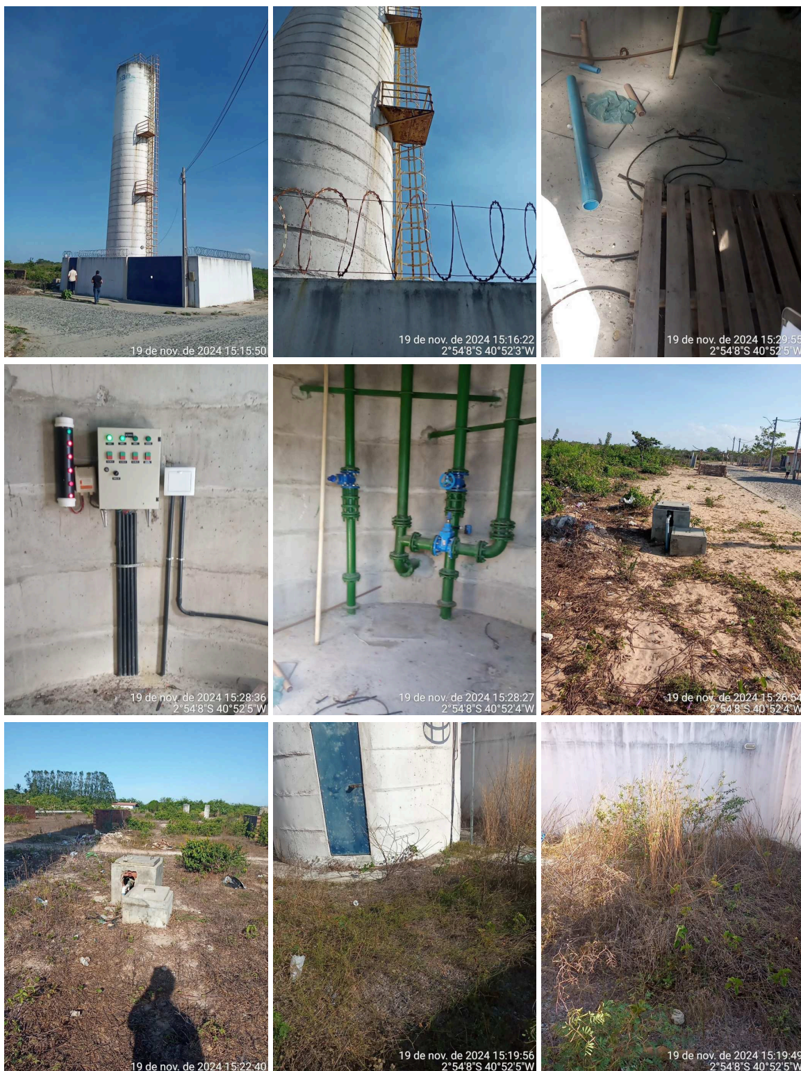
Figura 17. Reservatório Elevado - Bonito.
