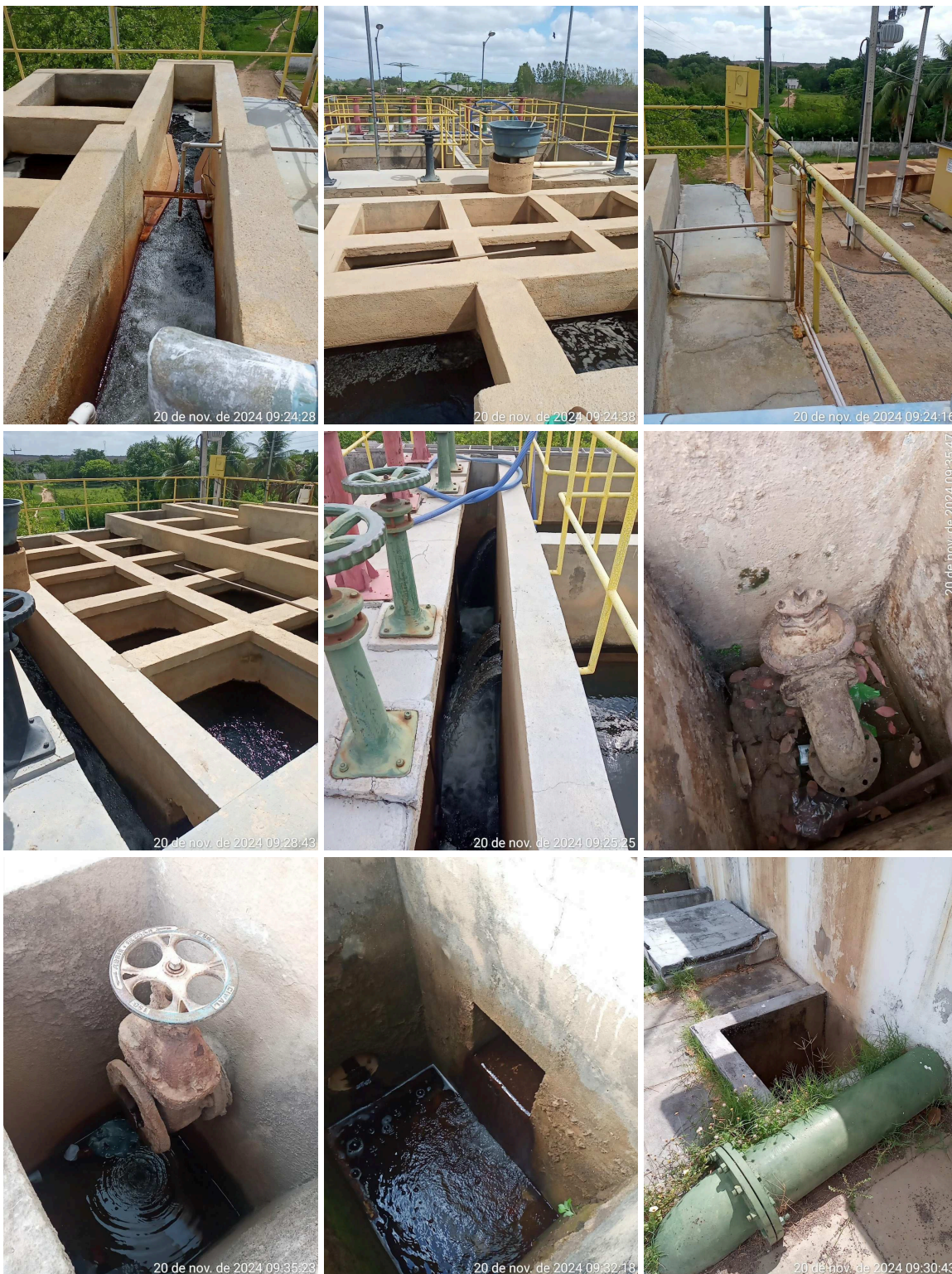
Figura 10. Floculadores / Decantadores / Filtros.
