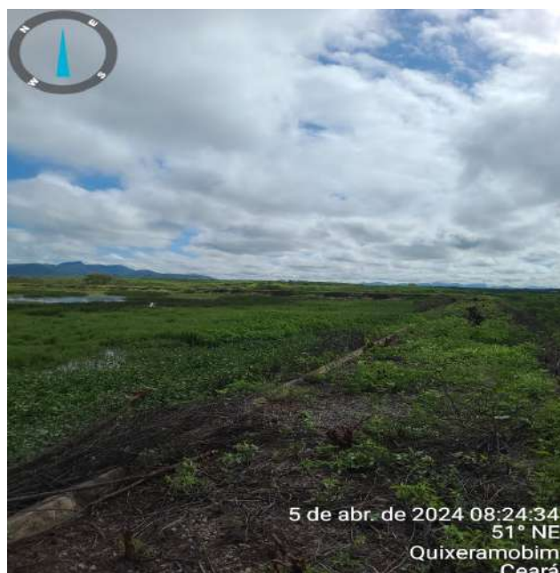
Foto 8 - ETE: vegetação no interior da lagoa facultativa e nos taludes.
