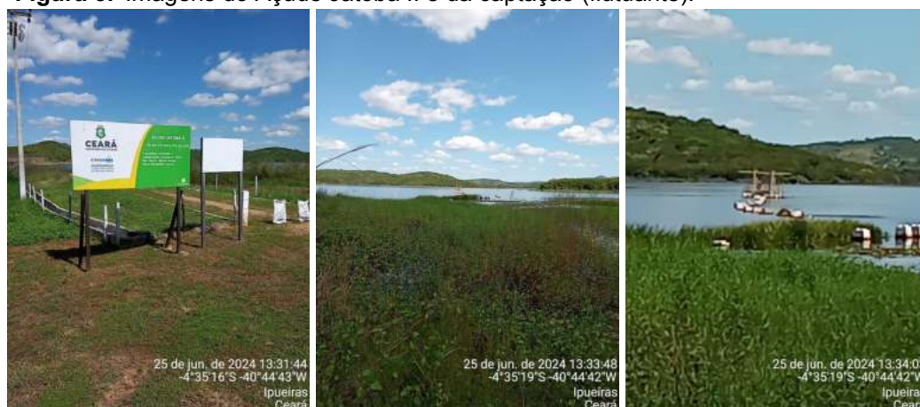
Figura 5. Imagens do Açude Jatobá II e da captação (flutuante).
