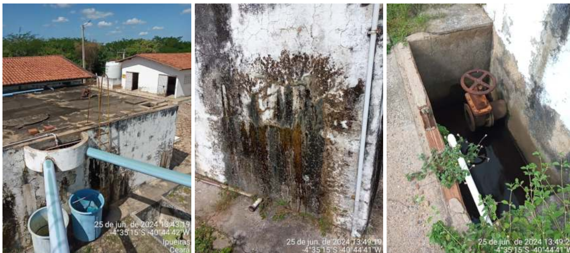
Figura 10. Reservatório Apoiado (RAP).
