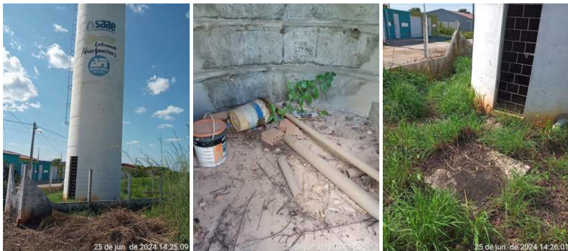
Figura 15. Reservatório Elevado - Loteamento Nova Ipueiras.
