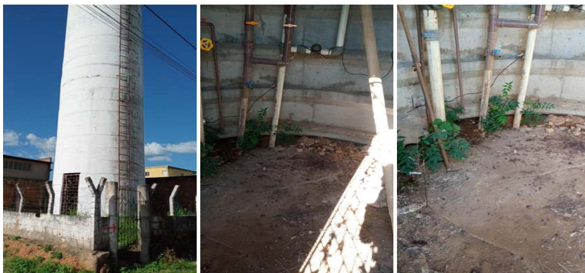
Figura 19. Reservatório Elevado - Telcon.
