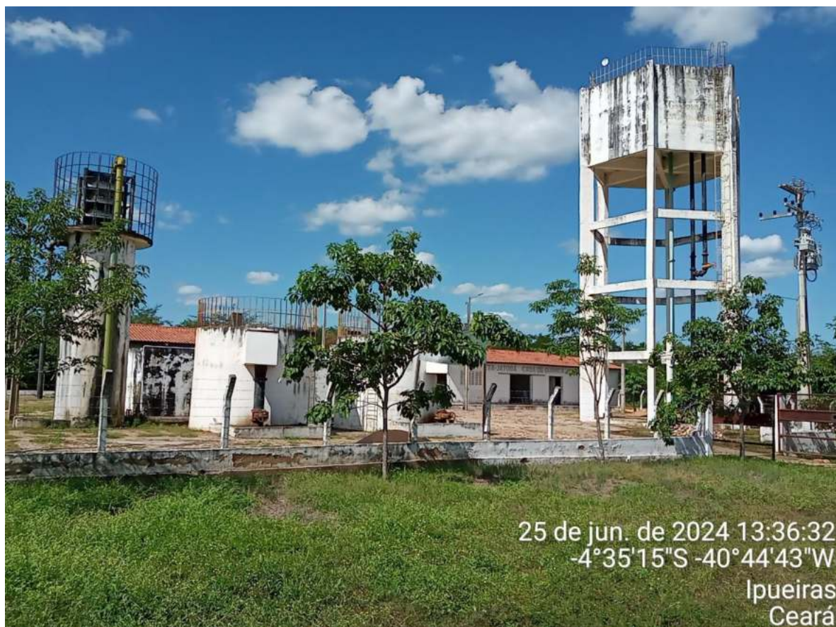
Figura 6. Vista Geral da ETA de Ipueiras.
