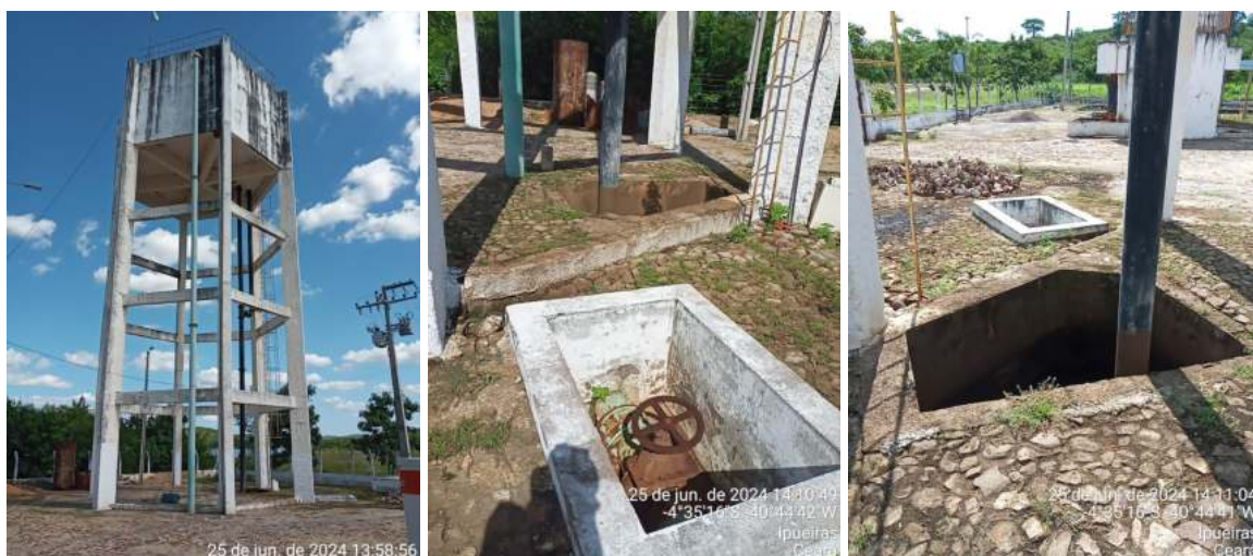
Figura 9. Reservatório Elevado (REL).
