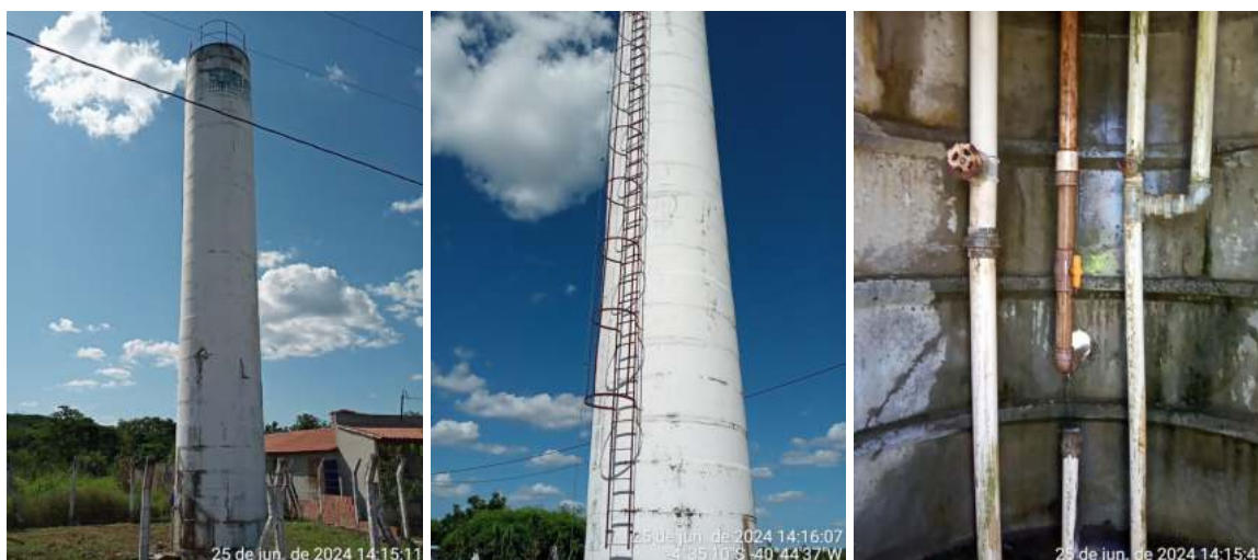
Figura 14. Reservatório Elevado - Agrovila.
