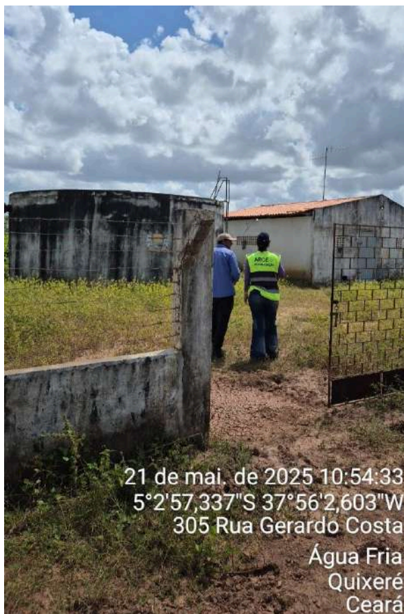
Foto 9 - Recalque Santa Terezinha.
