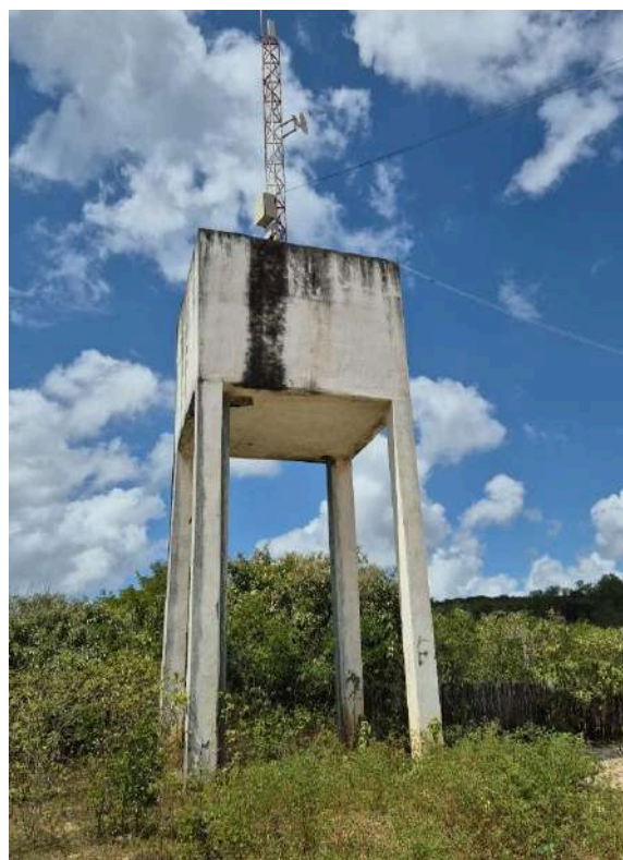
Foto 12 - Reservatório de Vertente.
