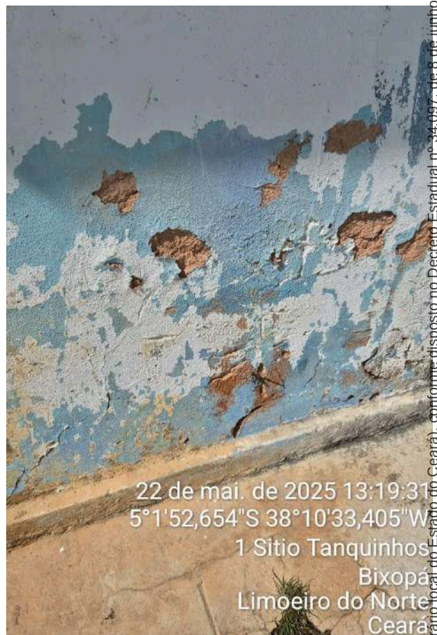
Foto 57 - Parede desgastada.
