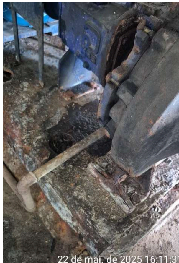
Foto 42 - Tubulações das bombas oxidadas e com vazamento.
