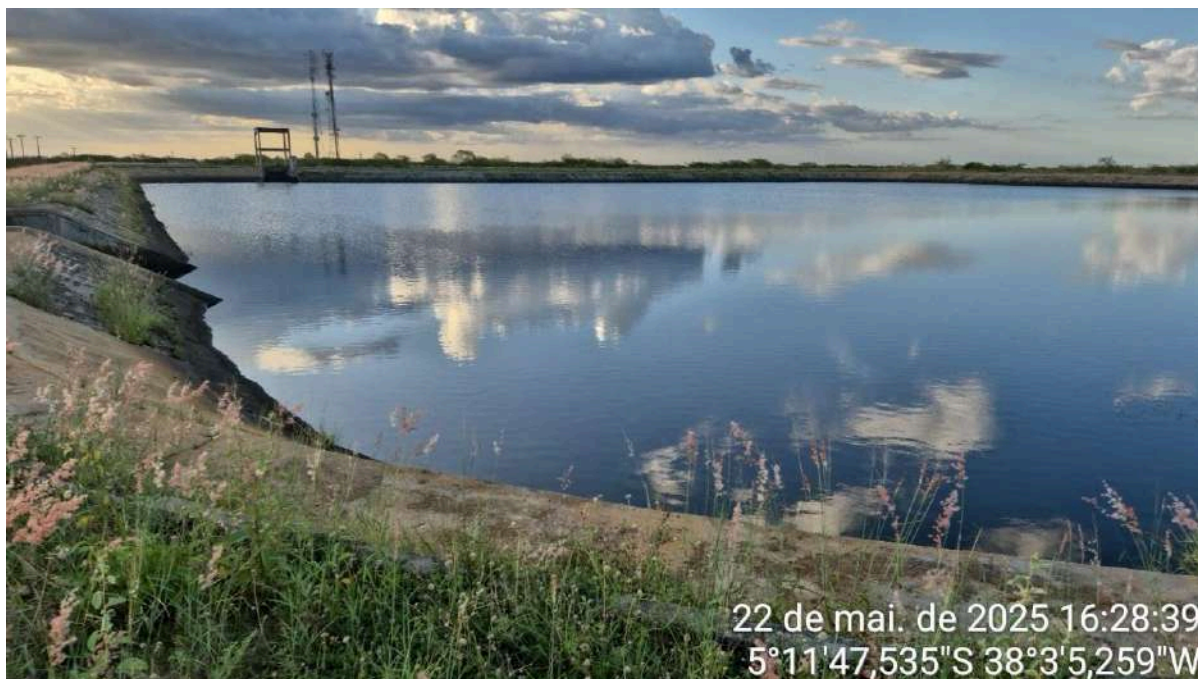
Foto 3 - Captação - ETA Santa Maria.
