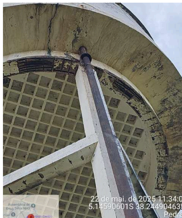
Foto 70 - Armadura exposta.
