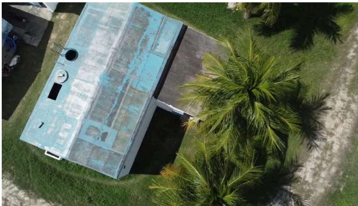
Foto 50 - Tampa do reservatório aberta.
