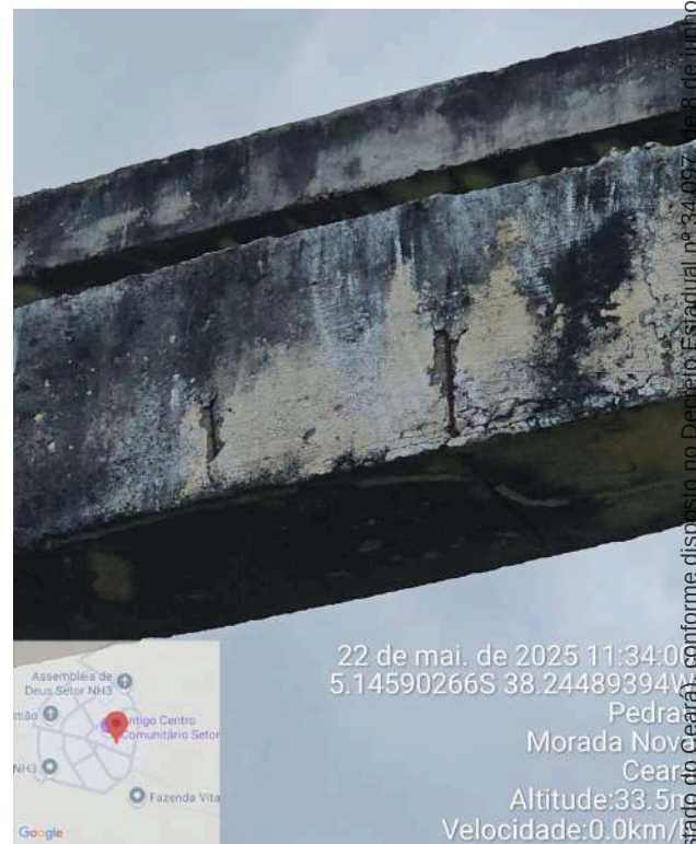
Foto 72 - Armadura exposta.
