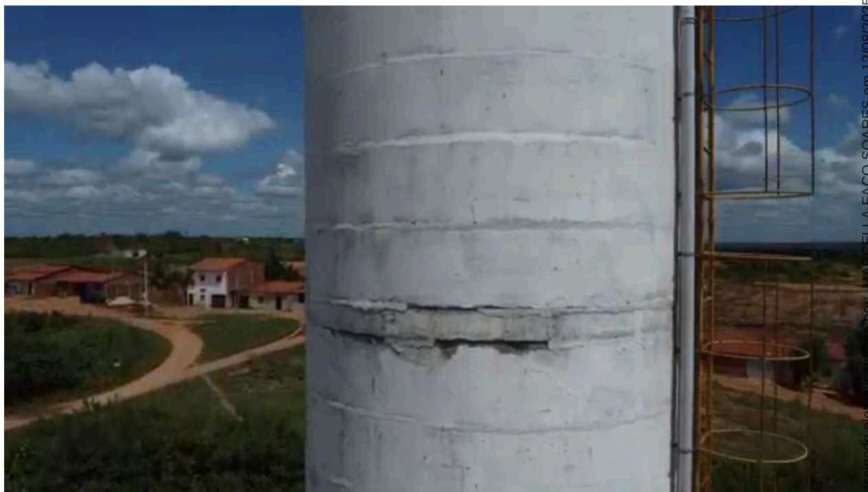
Foto 84 - Armadura exposta.
