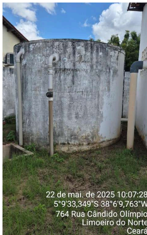
Foto 13 - Booster ETA Bom Fim - Cidade Alta.
