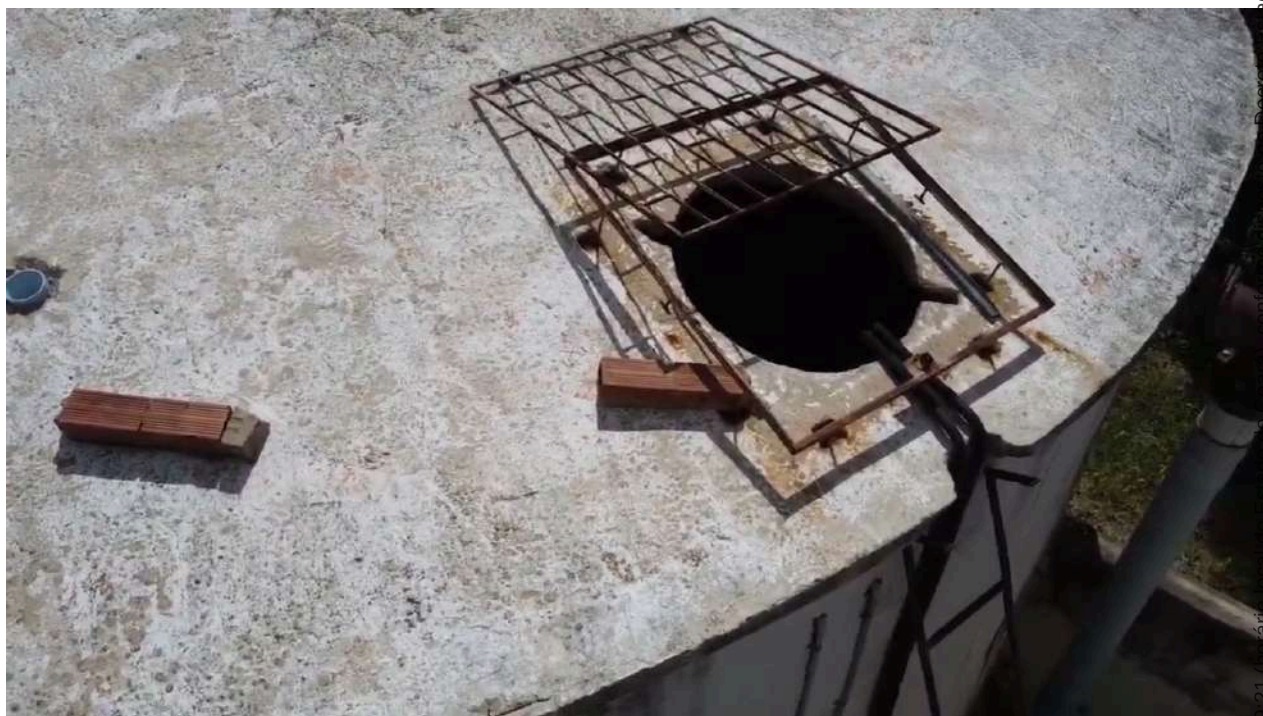
Foto 93 - Tampa do reservatório aberta.
