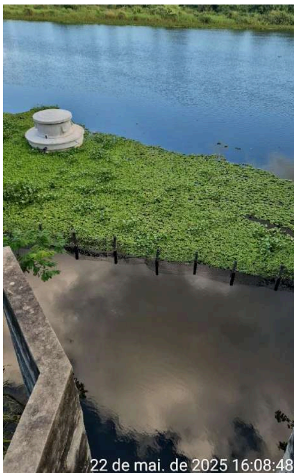
Foto 8 - Captação - ETA Bom Fim.
