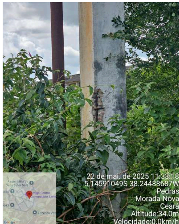
Foto 71 - Armadura exposta.
