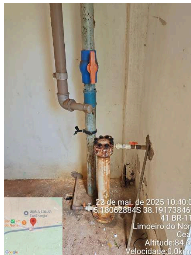
Foto 92 - Clorador desgastado.
