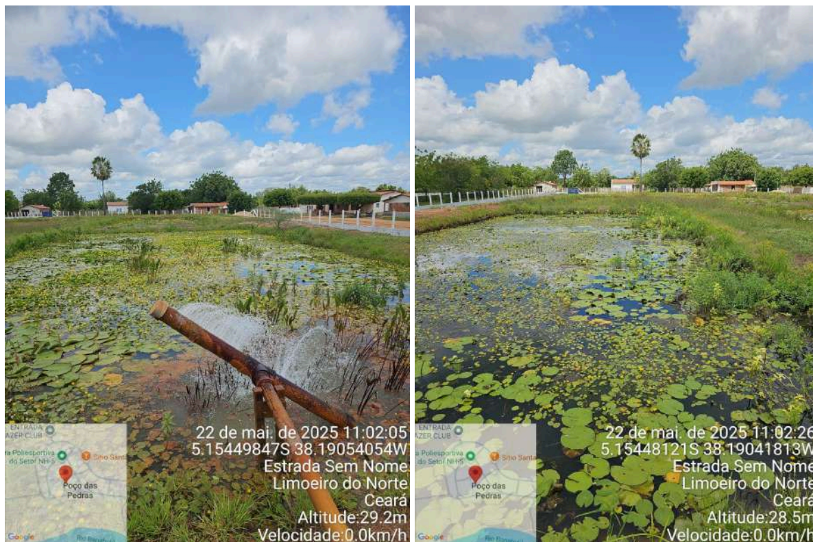
Foto 5 - Wetland, captação por poço - ETA Setores.
