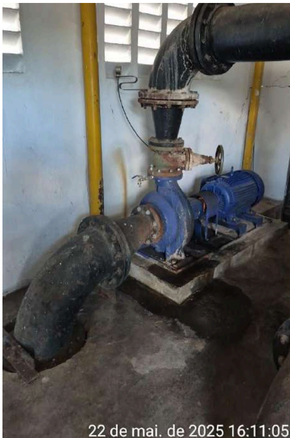
Foto 41 - Tubulações das bombas oxidadas e com vazamento.
