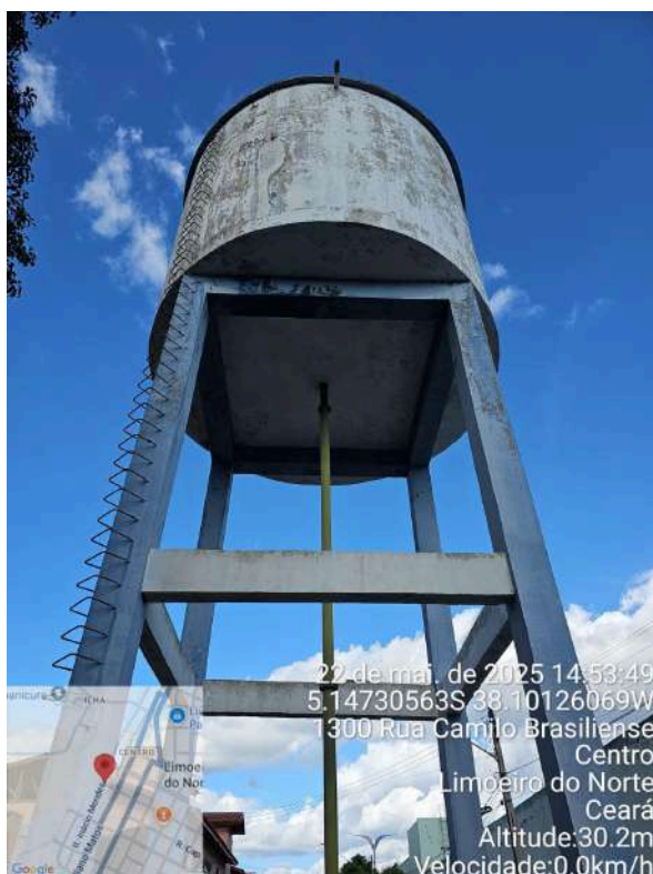
Foto 19 - Reservatório do Centro.
