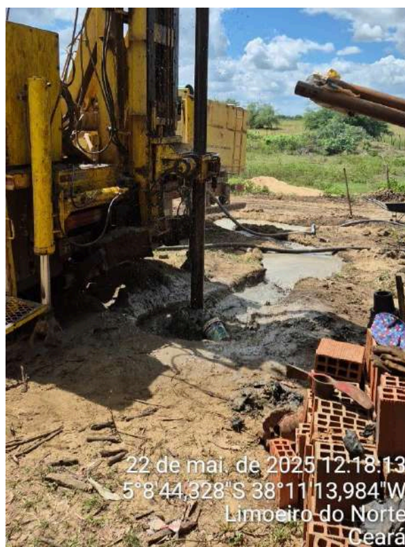
Foto 16 - Escavação de um novo poço profundo em processo de escavação.
