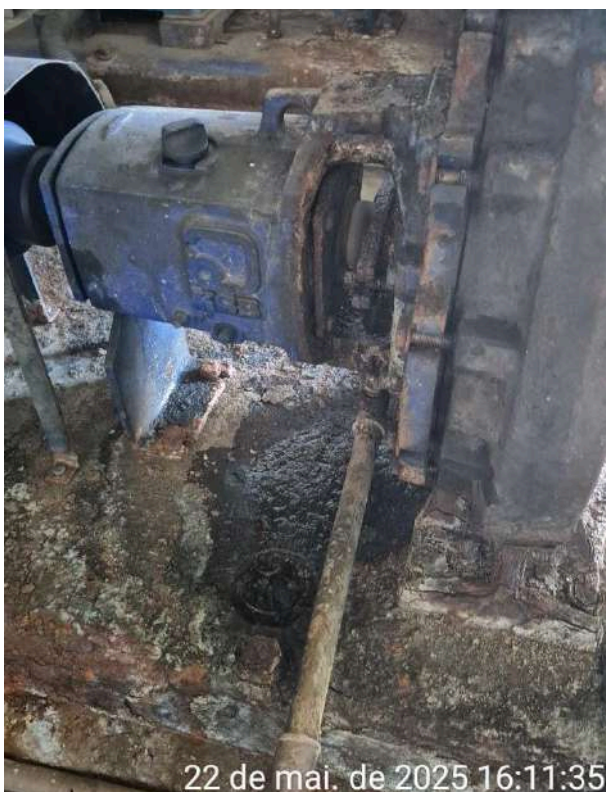
Foto 43 - Tubulações das bombas oxidadas e com vazamento.
