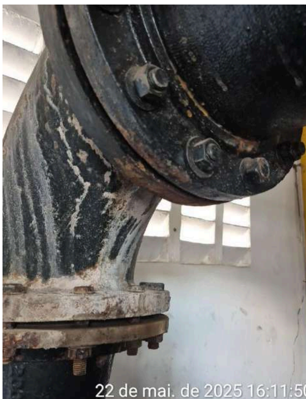
Foto 44 - Tubulações das bombas oxidadas e com vazamento.
