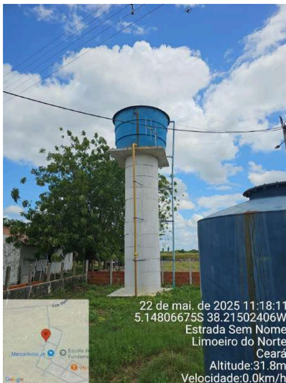
Foto 17 - Poço Profundo - NH4.
