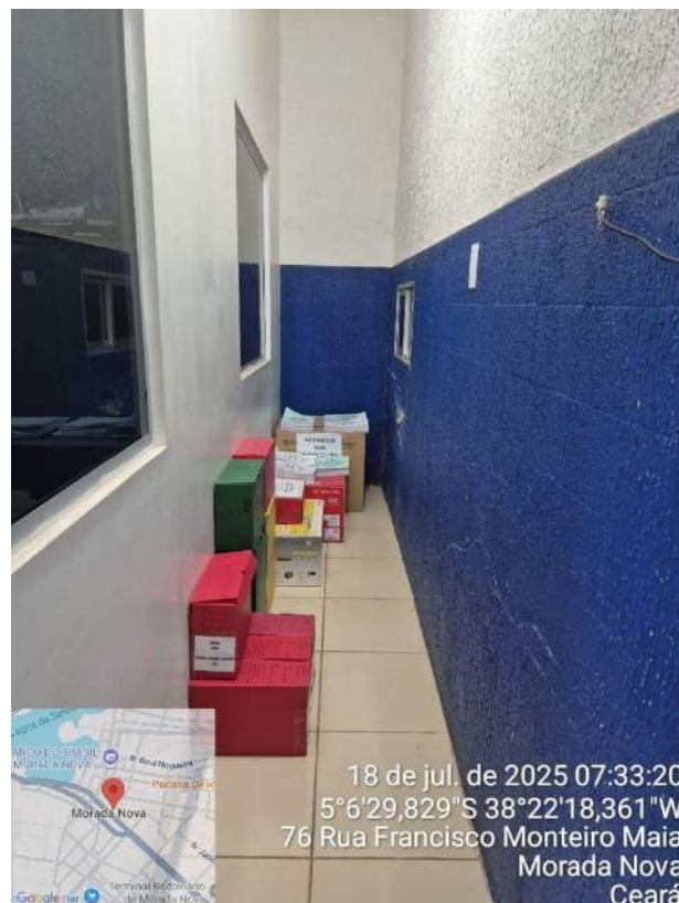
Foto 62 - Sala Operacional: armazenamento de material de escritório no chão.
