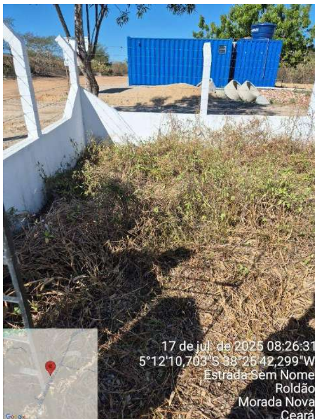
Foto 179 - Casa de comando da captação com vegetação alta.
