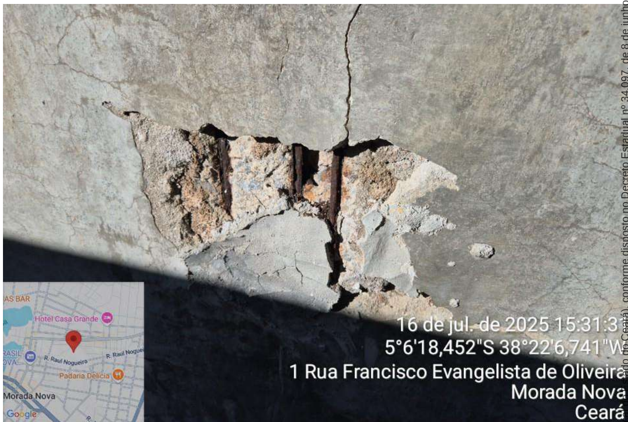
Foto 156 - Armadura exposta.
