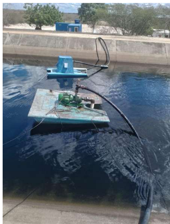
Foto 22 - Captação Lagoa dos Bois (reparo do vazamento após a visita).
