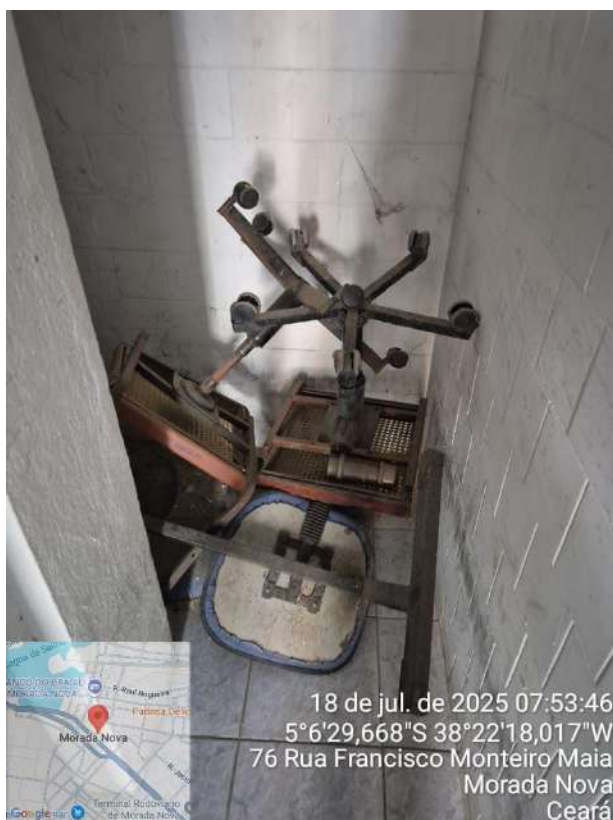
Foto 71 - Banheiro Masculino: acúmulo de material inadequado.
