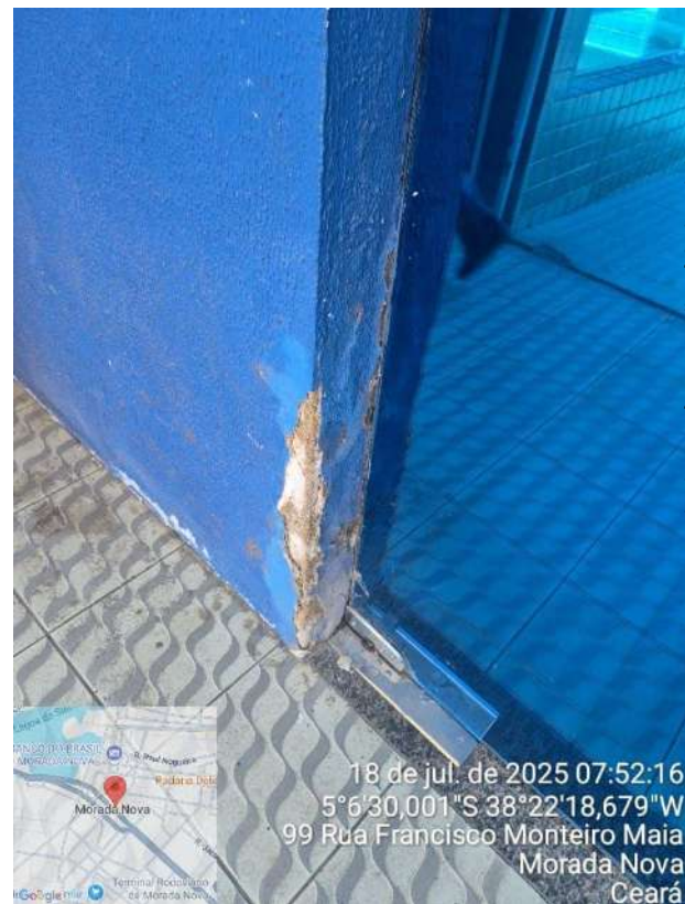
Foto 48 - Entrada do SAAE: parede com infiltração e rachaduras.
