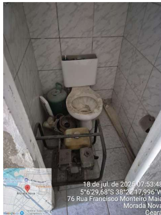
Foto 70 - Banheiro Masculino: acúmulo de material inadequado.
