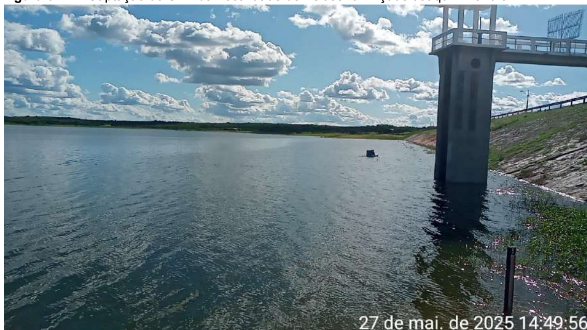
Figura 6 - Captação do SAA da Localidade de Feiticeiro - Açude Joaquim Távora.
