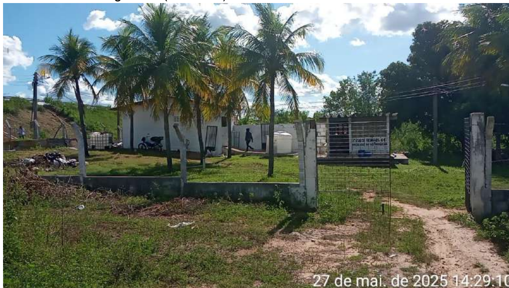
Figura 19 - Vista geral da Estação de Tratamento de Água do SAAE de Jaguaribe (Feiticeiro).
