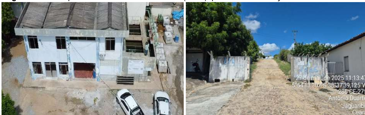
Figura 14 - Oportunidade de Melhorias - ETA (Sede): pintura e identificação.
