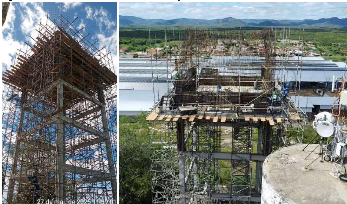
Figura 26 - Reservatório elevado em construção, localizado na área da ETA.
