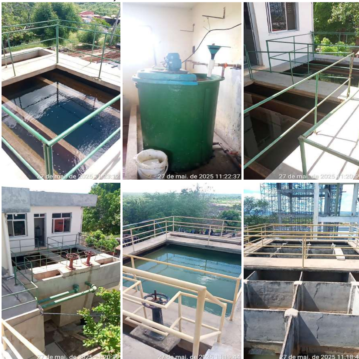
Figura 12 - Estação de Tratamento de Água do SAAE de Jaguaribe (Sede) em bom estado de conservação - Tratamento.
