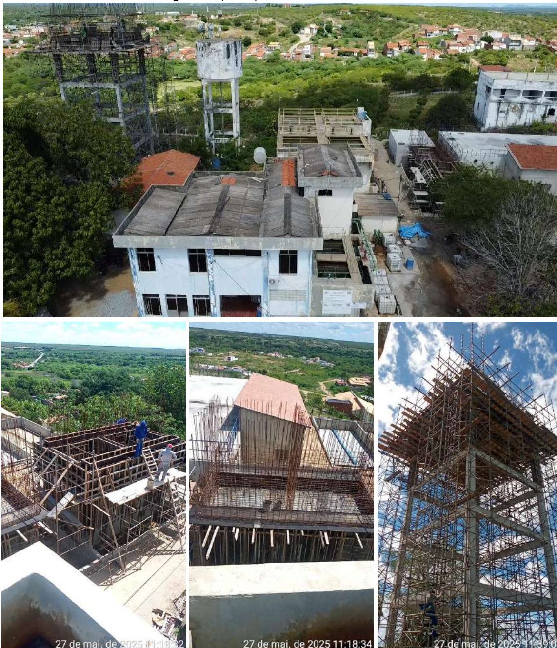
Figura 13 - Obras de recuperação e ampliação da Estação de Tratamento de Água do SAAE de Jaguaribe (Sede).
