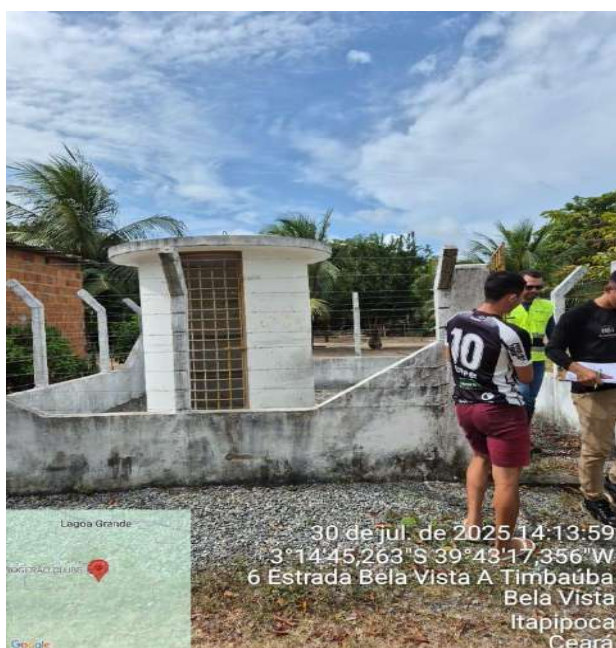
Foto 163 - Ausência de identificação.
