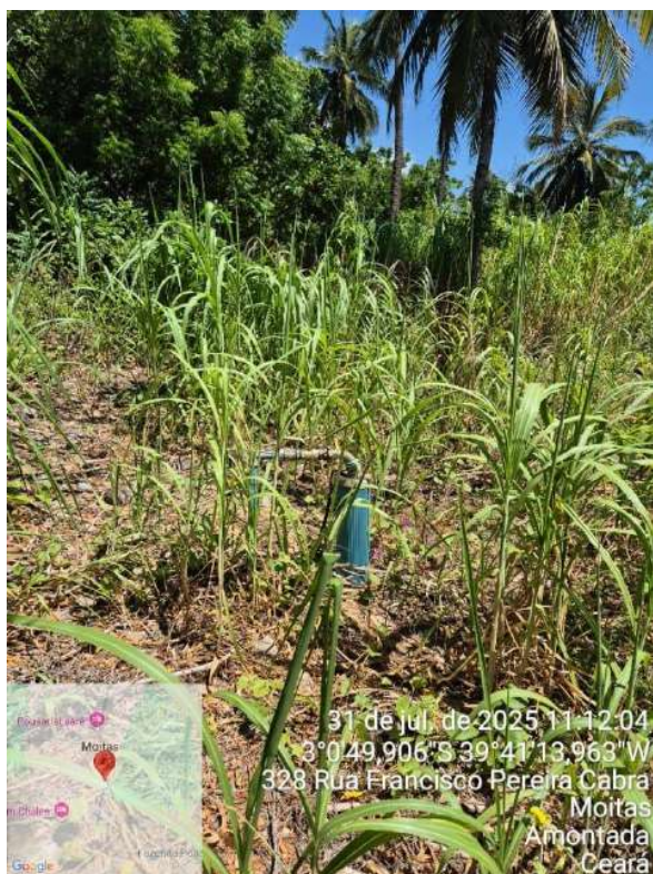
Foto 83 - Captação de Moitas (Poço 1) - Ao lado da ETA Moitas.
