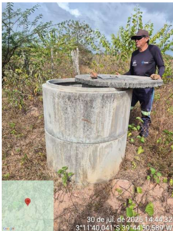
Foto 65 - Poço de Aracatiara.
