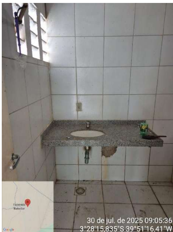
Foto 23 - ETA de Missi (desativada) - Banheiro.
