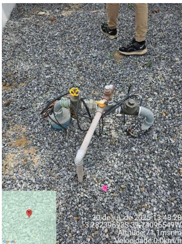
Foto 47 - Poço de Arengas.
