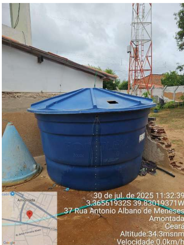
Foto 152 - Reservatório de mistura transbordando.
