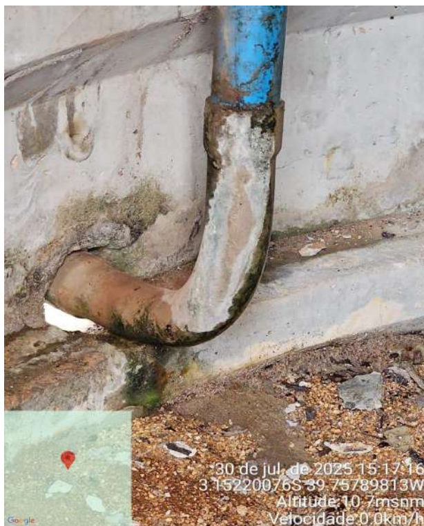
Foto 183 - Vazamento.
