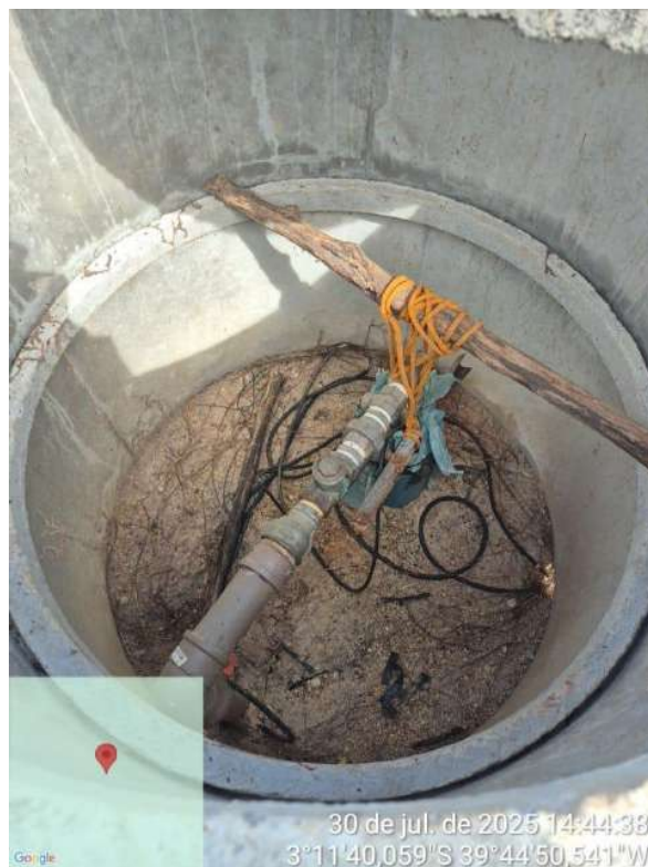
Foto 66 - Poço de Aracatiara.
