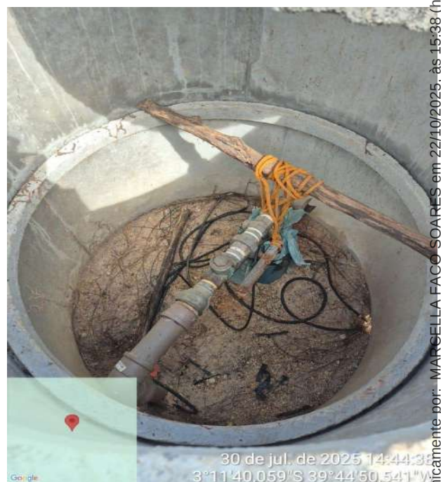
Foto 209 - Fiação inadequada.
