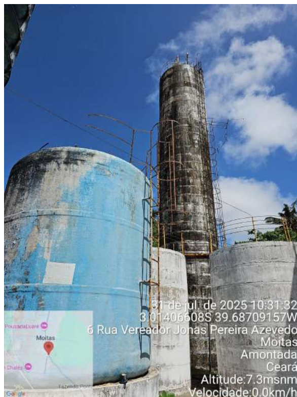
Foto 80 - ETA de Moitas/Filtros/REL.
