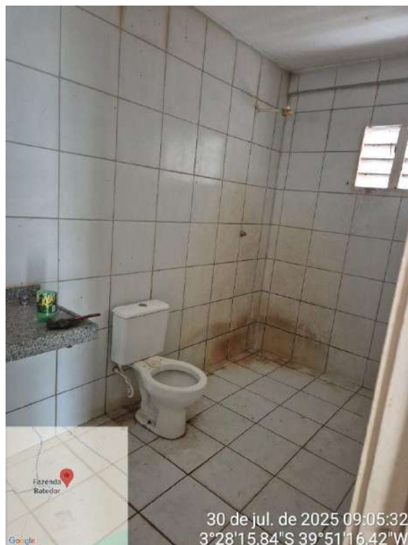
Foto 22 - ETA de Missi (desativada) - Banheiro.
