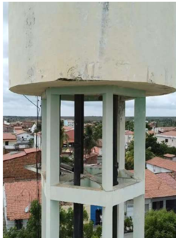
Foto 159 - Armadura exposta.
