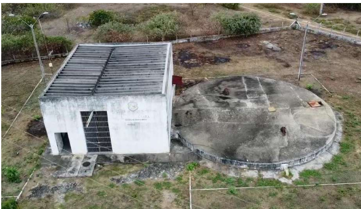
Foto 26 - ETA de Missi (desativada) - Casa de bombas e RSE.
