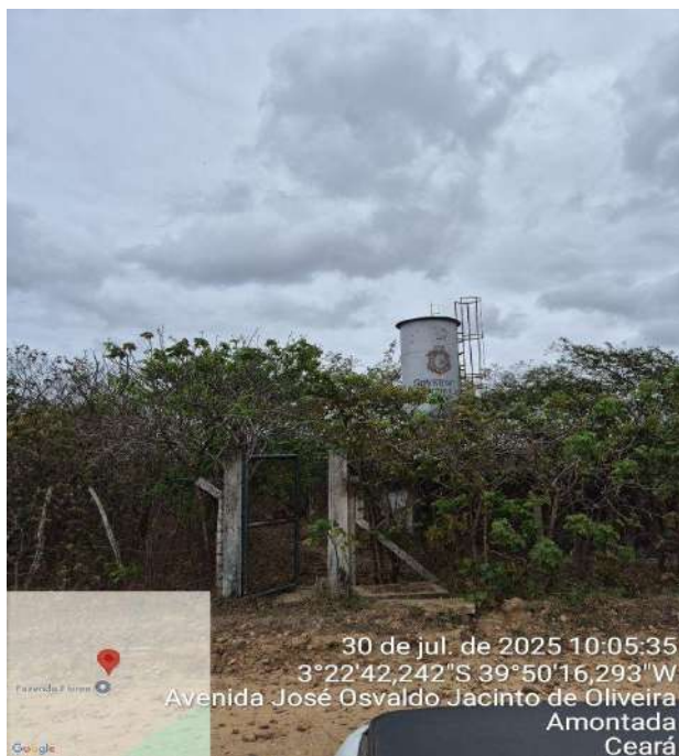
Foto 135 - Excesso de vegetação.
