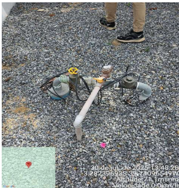
Foto 161 - Fiação inadequada.
