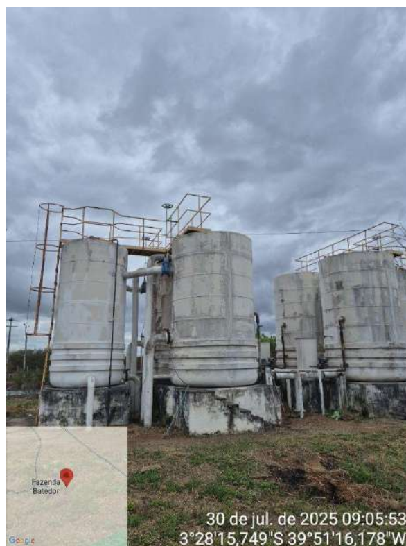
Foto 24 - ETA de Missi (desativada) - Filtros.
