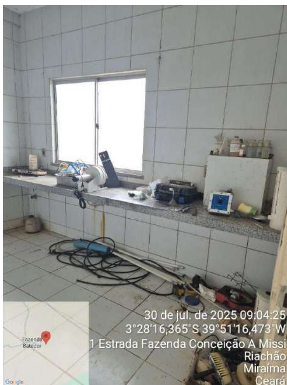
Foto 19 - ETA de Missi (desativada) - Laboratório.
