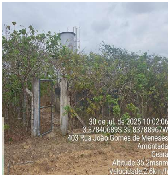
Foto 32 - Torre de Equalização 3.
