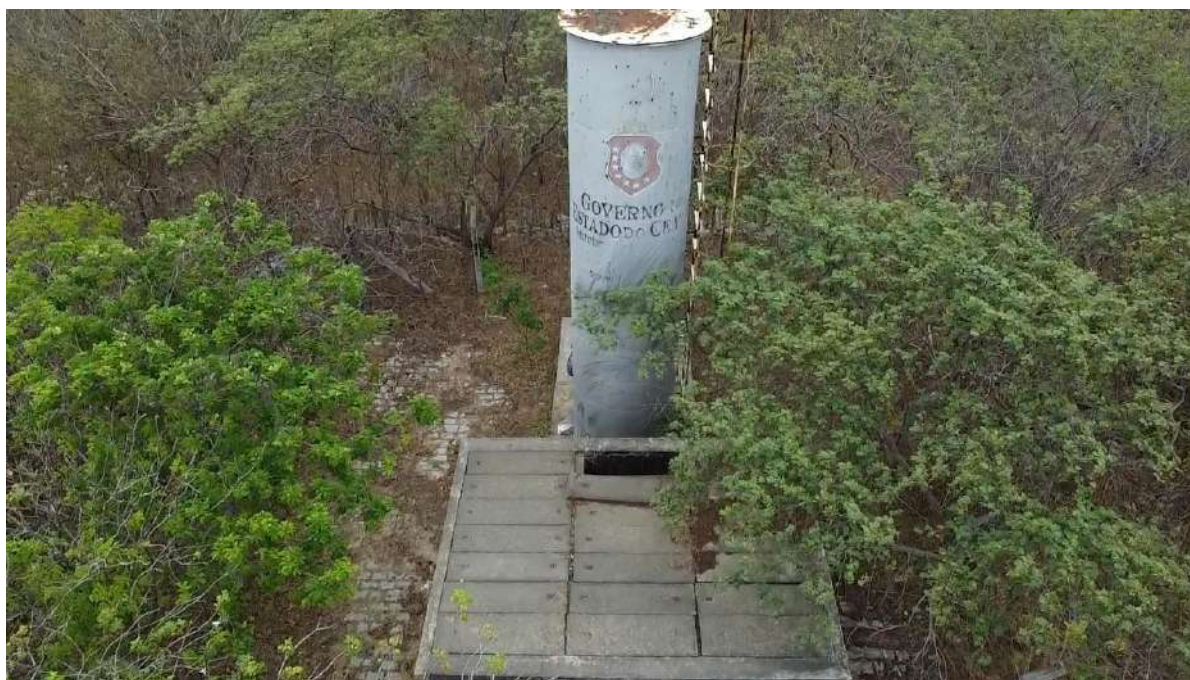
Foto 33 - Torre de Equalização 3.
