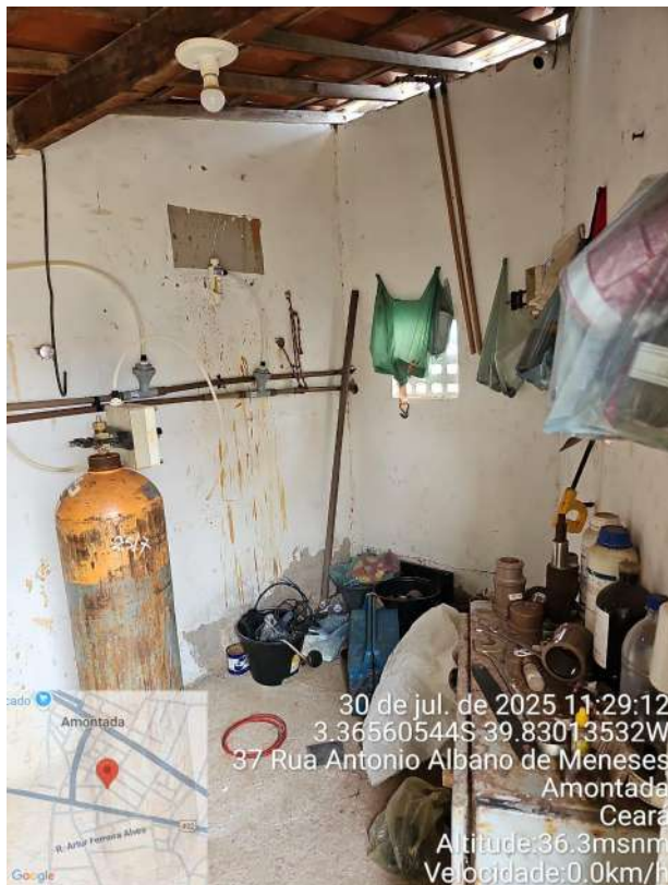
Foto 150 - Armazenamento inadequado de materiais.
