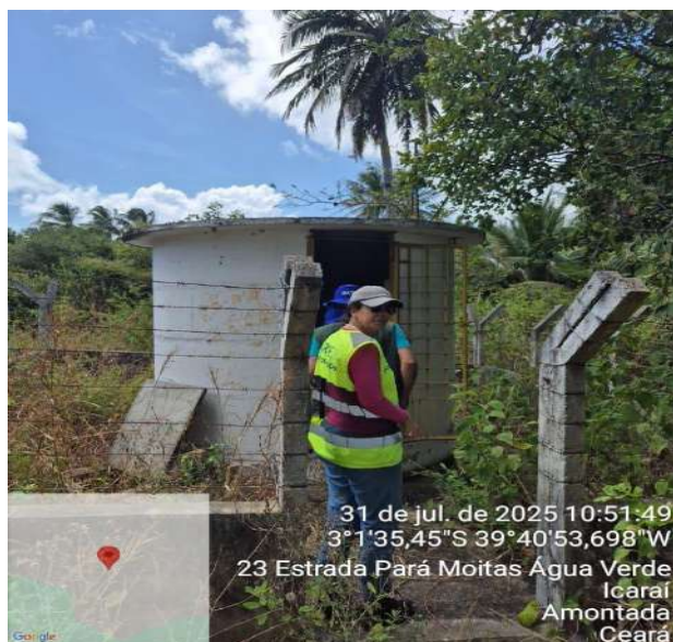
Foto 224 - Ausência de identificação e sem portão de acesso.
