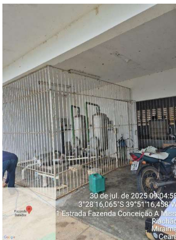
Foto 16 - ETA de Missi (desativada).
