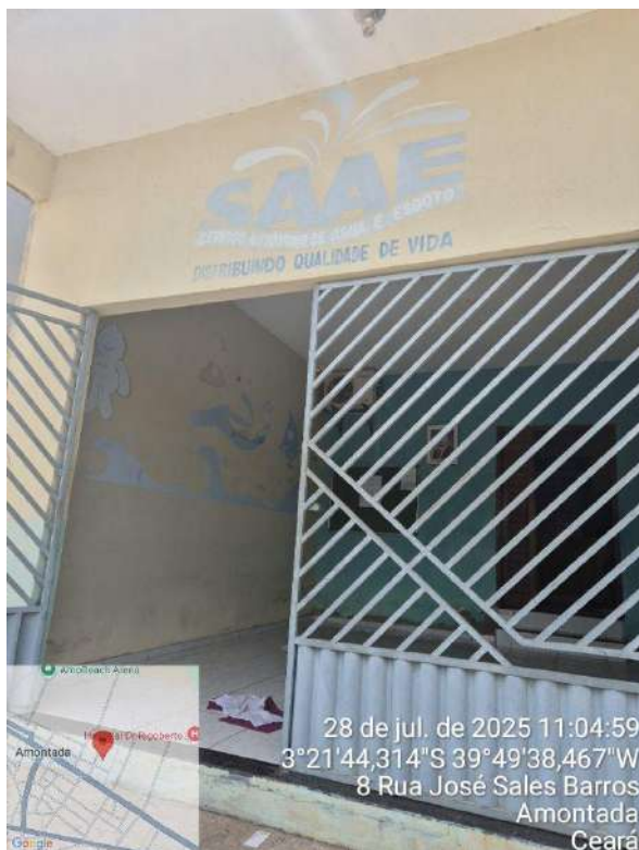
Foto 95 - Fachada de entrada do SAAE.
