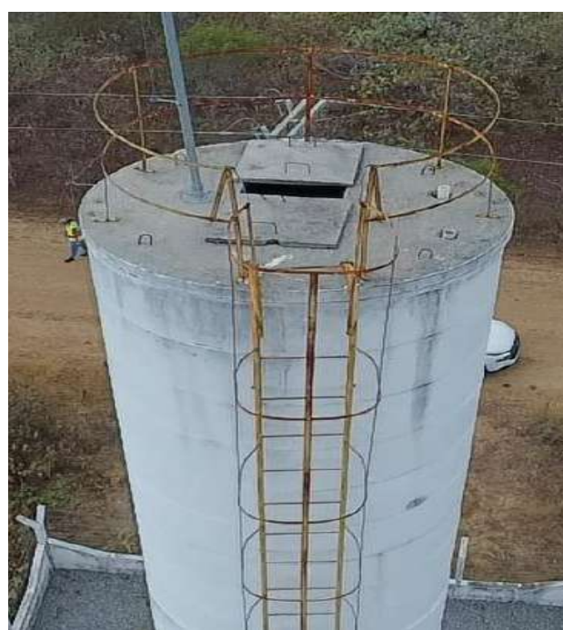
Foto 147 - Escada/guarda-corpo oxidados.
