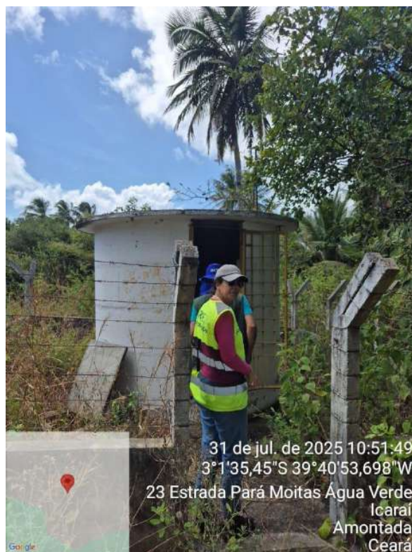
Foto 84 - Captação de Moitas (Poço 2) - Ilha dos Cavalos.
