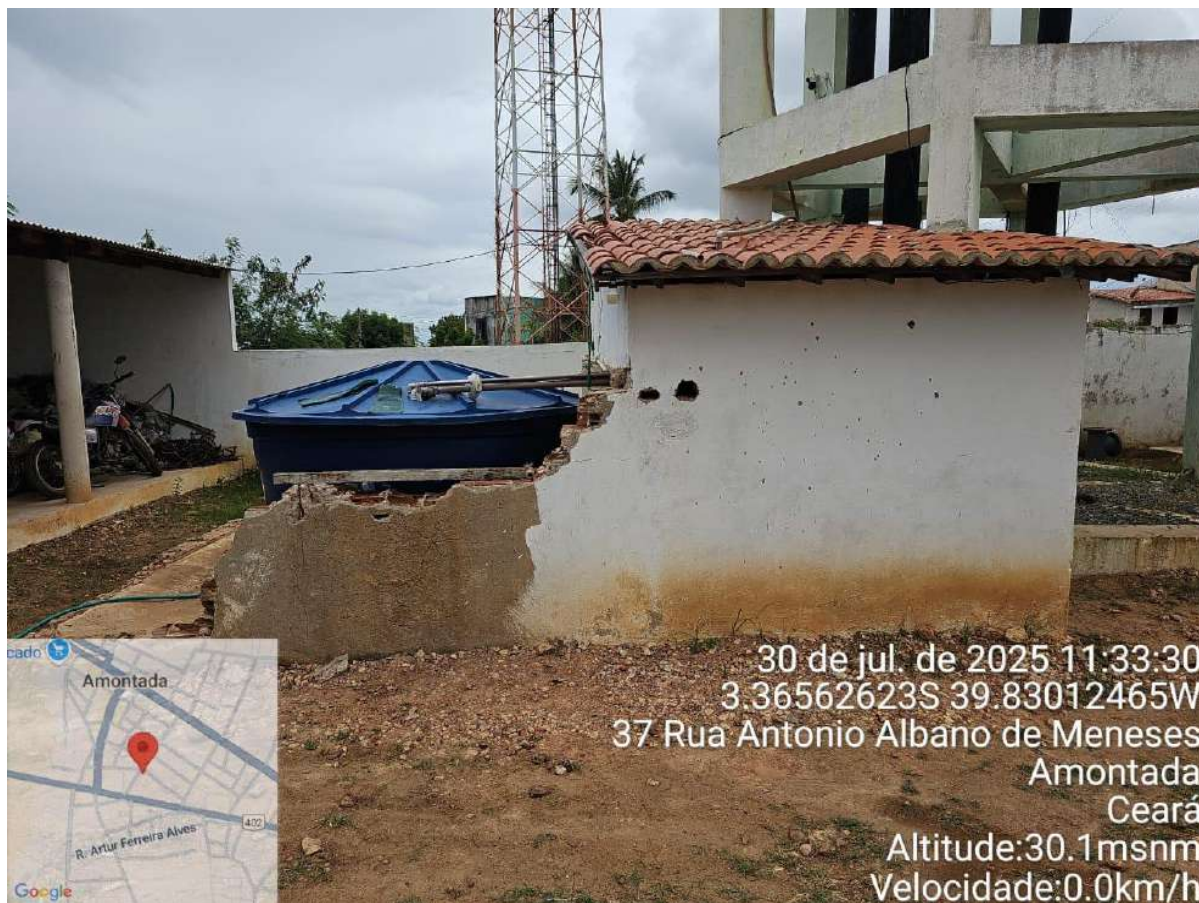
Foto 42 - REL da Sede (Casa de Comando/Cloração).
