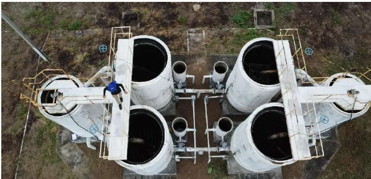
Foto 25 - ETA de Missi (desativada) - Filtros.
