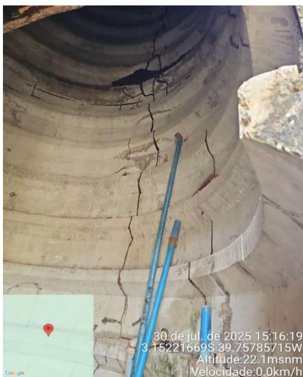
Foto 181 - Presença de cupim.
