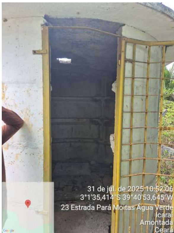
Foto 85 - Captação de Moitas (Poço 2) - Ilha dos Cavalos.
