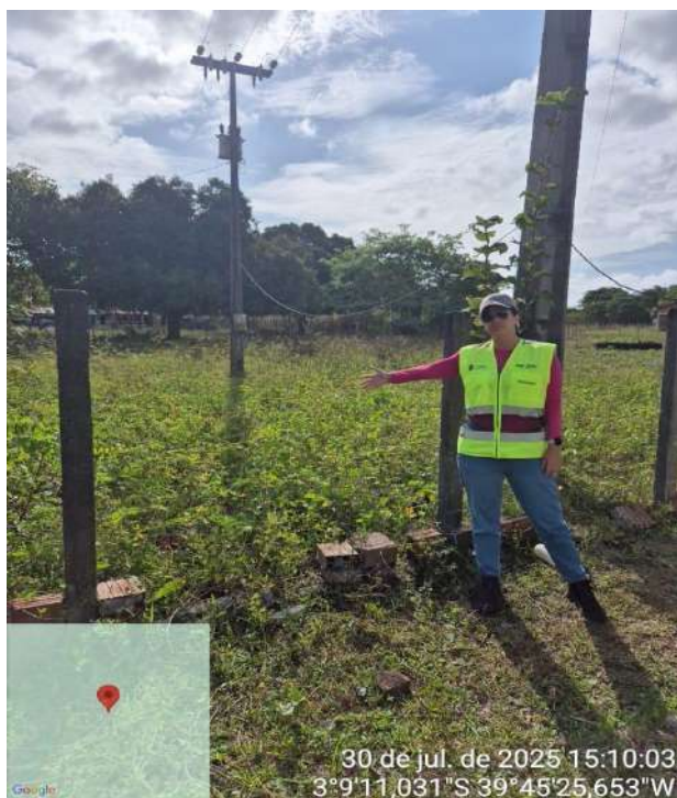
Foto 171 - Sem cercamento adequado.
