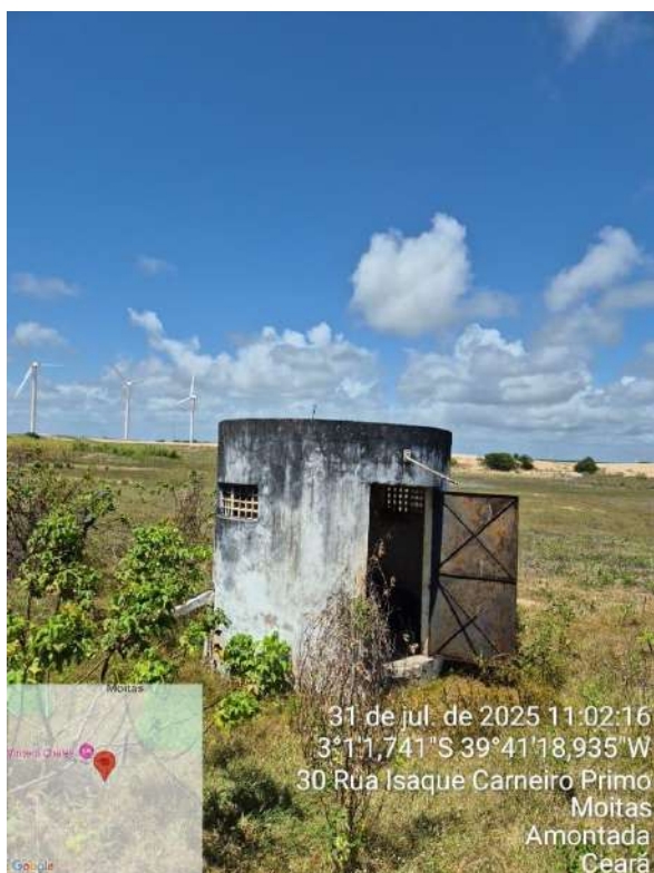
Foto 87 - Captação Moitas (Poço 3) - Casa do Valdo.
