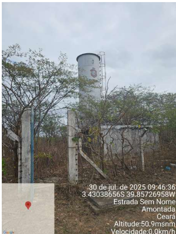
Foto 29 - Torre de Equalização 1 - Missi.
