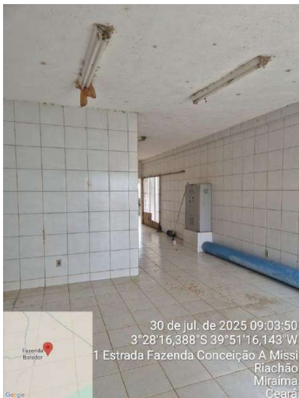
Foto 21 - ETA de Missi (desativada).
