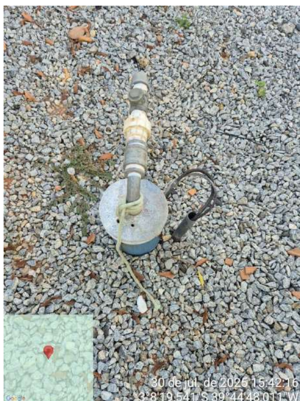
Foto 63 - Poço de Cabatan (Casa de Comando).
