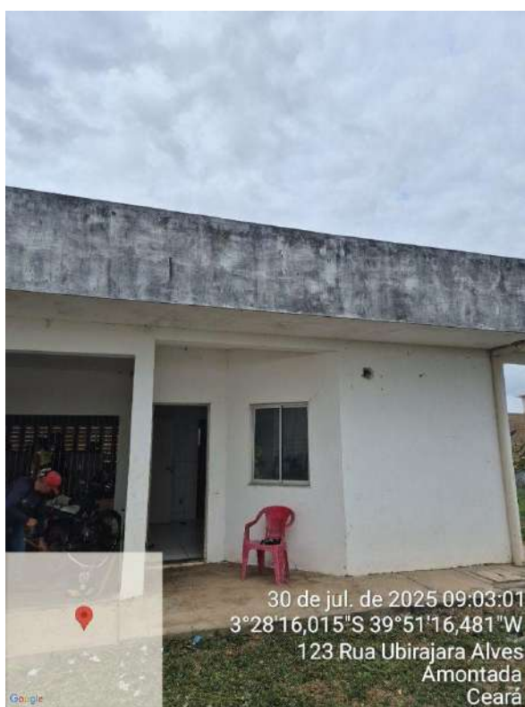
Foto 15 - ETA de Missi (desativada).
