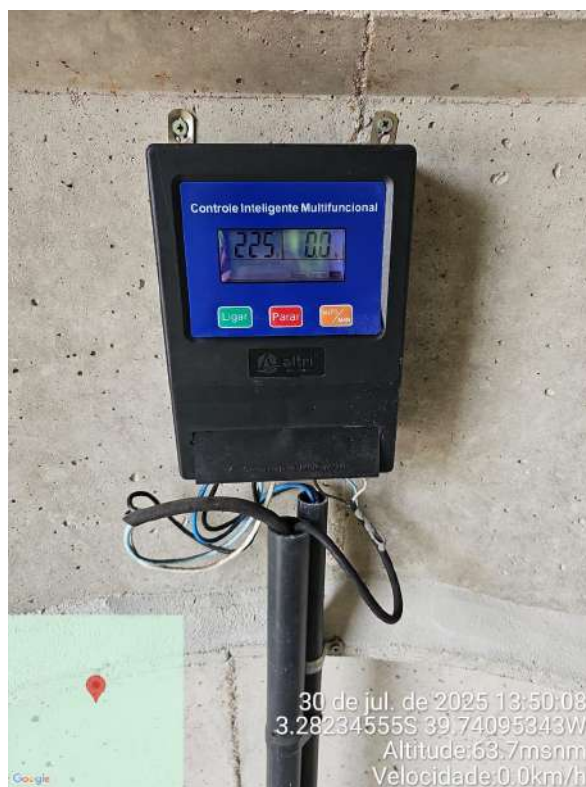
Foto 48 - Poço de Arengas.
