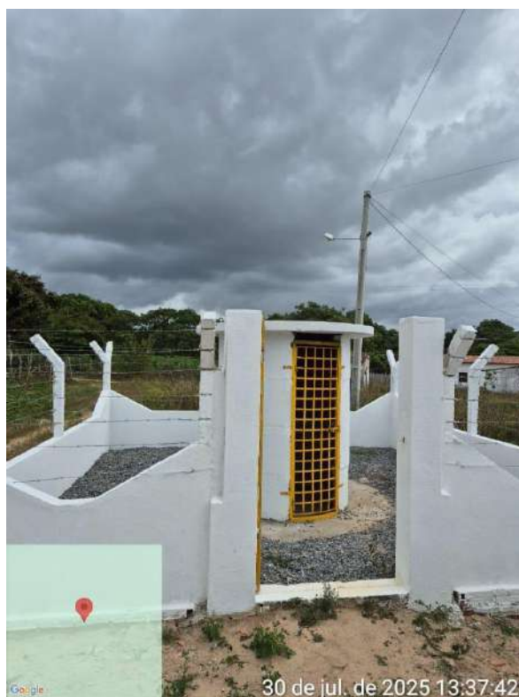
Foto 43 - Poço de Baixios.
