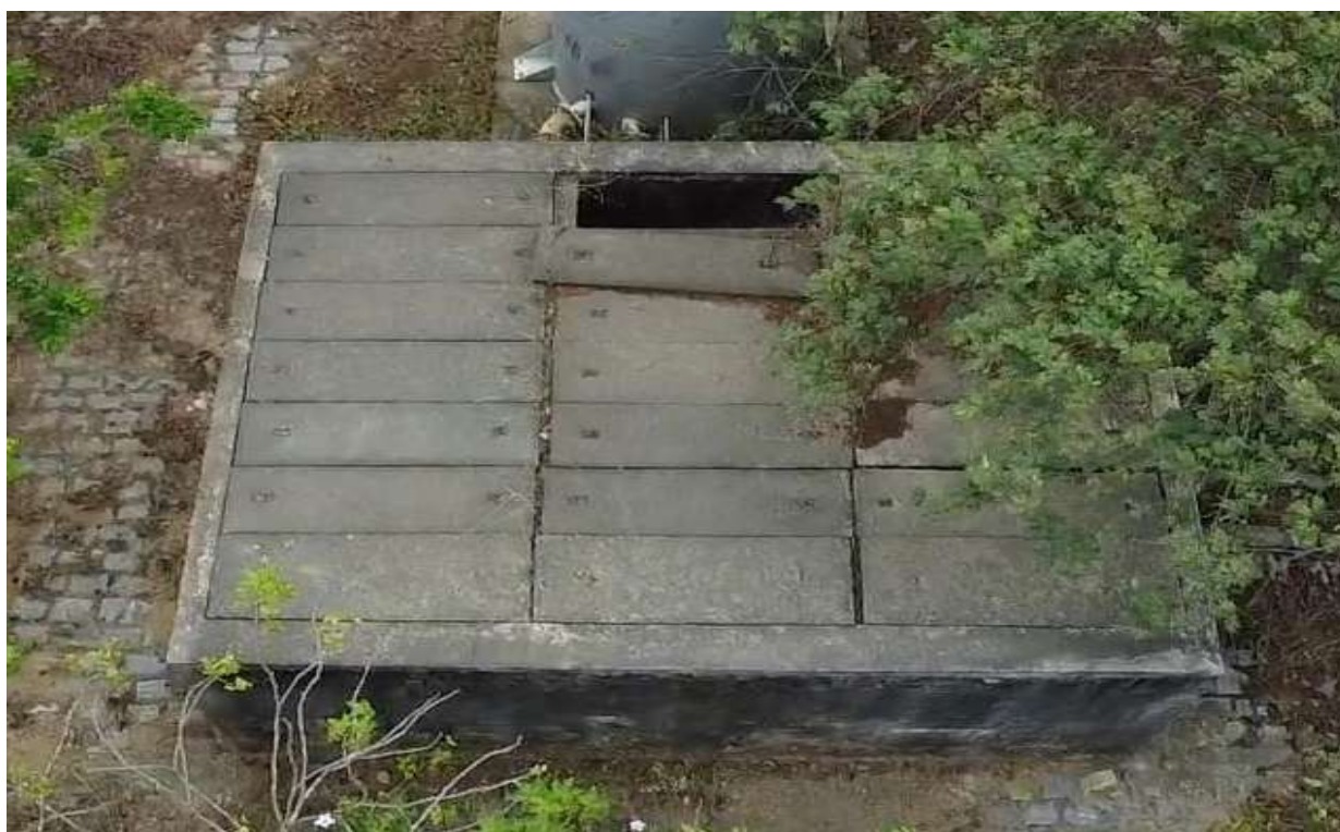
Foto 137 - Reservatório com abertura.
