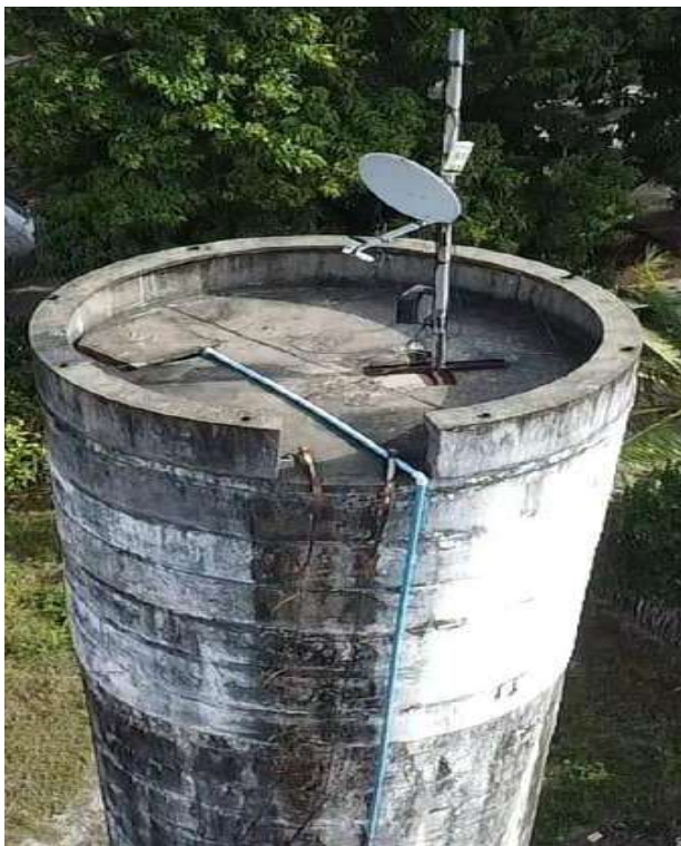
Foto 187 - Escada danificada e sem guarda-corpo.
