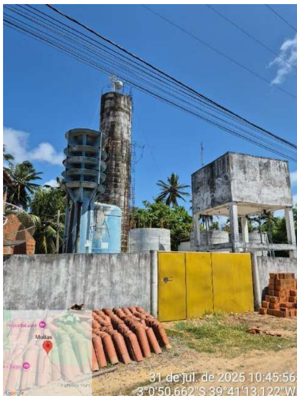
Foto 79 - ETA de Moitas.
