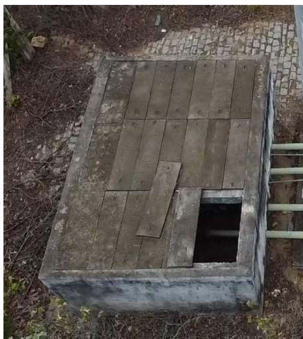
Foto 133 - Reservatório com abertura.
