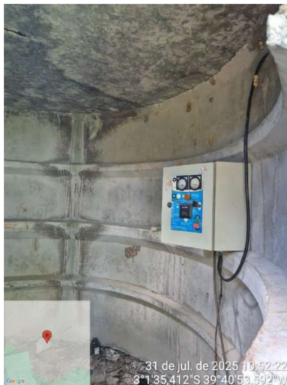
Foto 86 - Captação de Moitas (Poço 2) - Ilha dos Cavalos.
