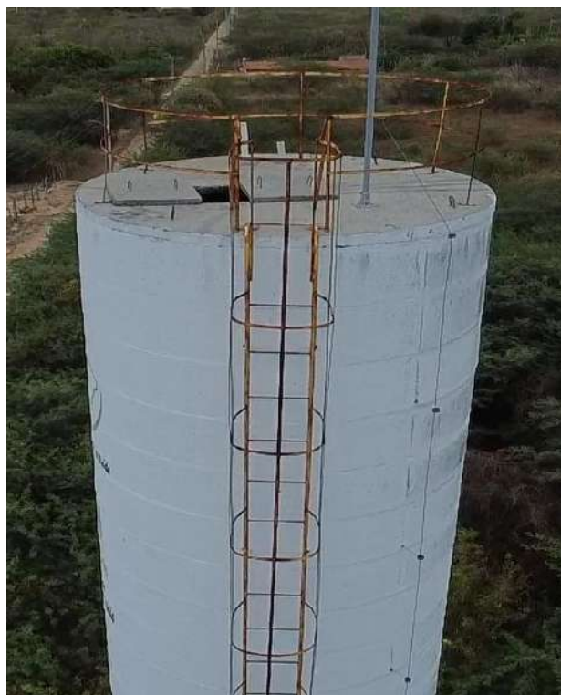
Foto 143 - Escada/guarda-corpo oxidados.
