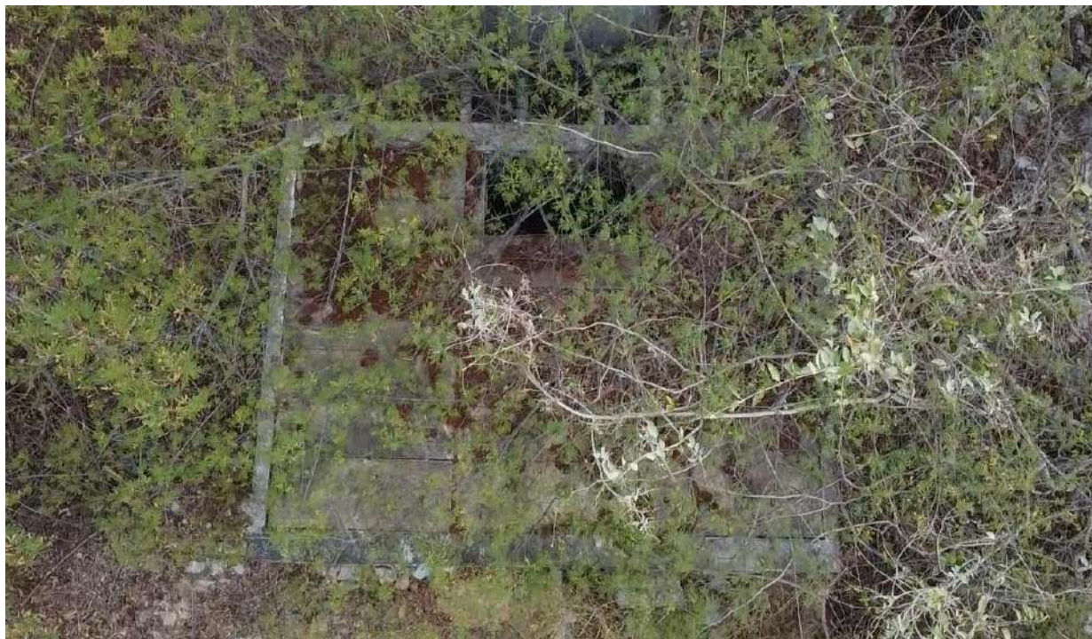
Foto 130 - Reservatório com abertura.
