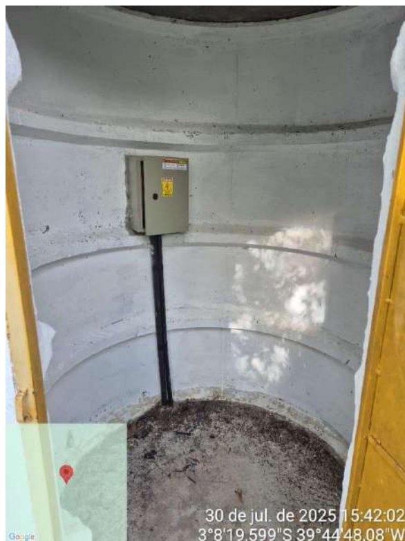
Foto 62 - Poço de Cabatan (Casa de Comando).
