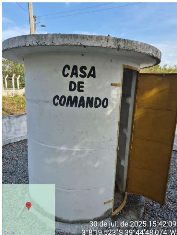
Foto 61 - Poço de Cabatan (Casa de Comando).
