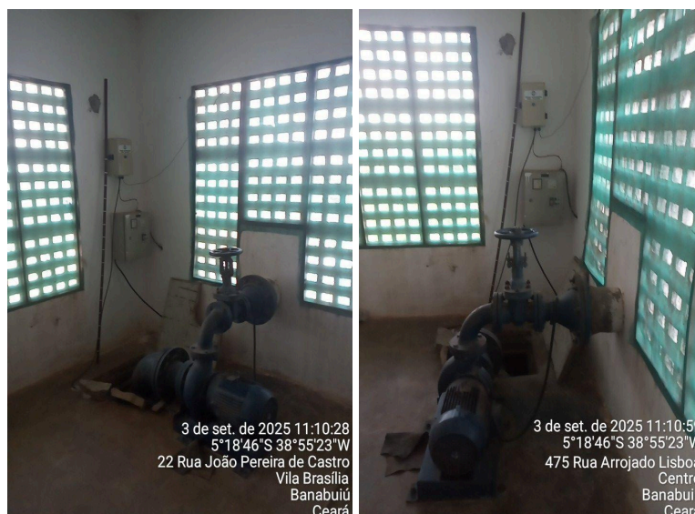
Figura 13 - ETA do SAAE de Banabuiú - Elevatória de lavagem dos filtros.
