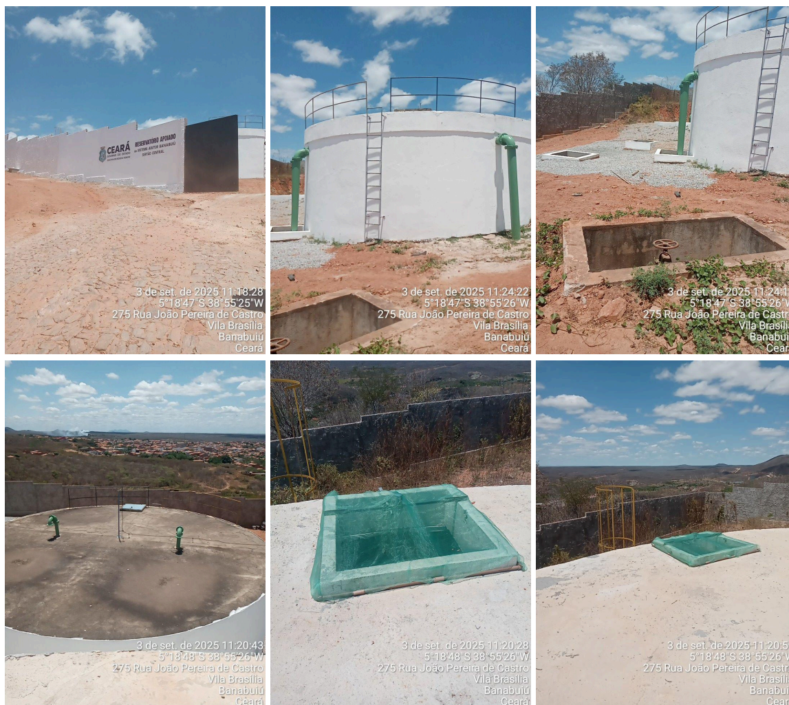
Figura 18 - Reservatório Apoiado - Malha d'Água.
