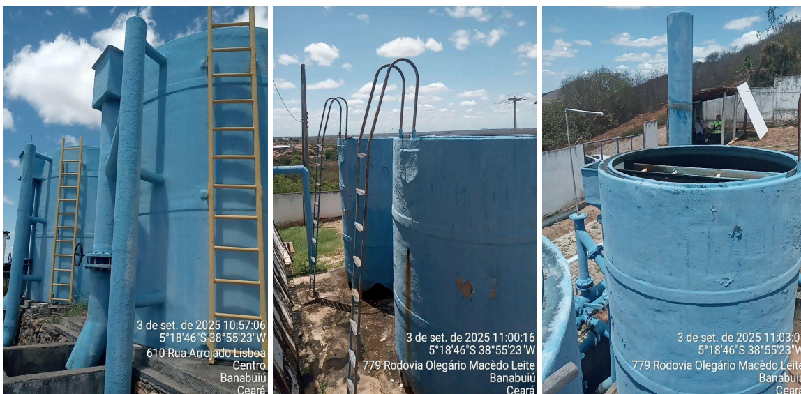
Figura 10 - ETA do SAAE de Banabuiú - Filtros.
