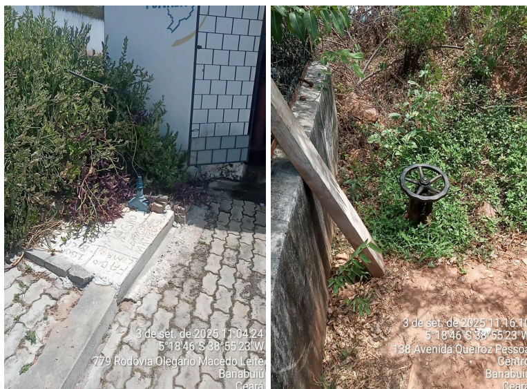
Figura 14 - ETA do SAAE de Banabuiú - Dispositivos sem caixa de proteção.
