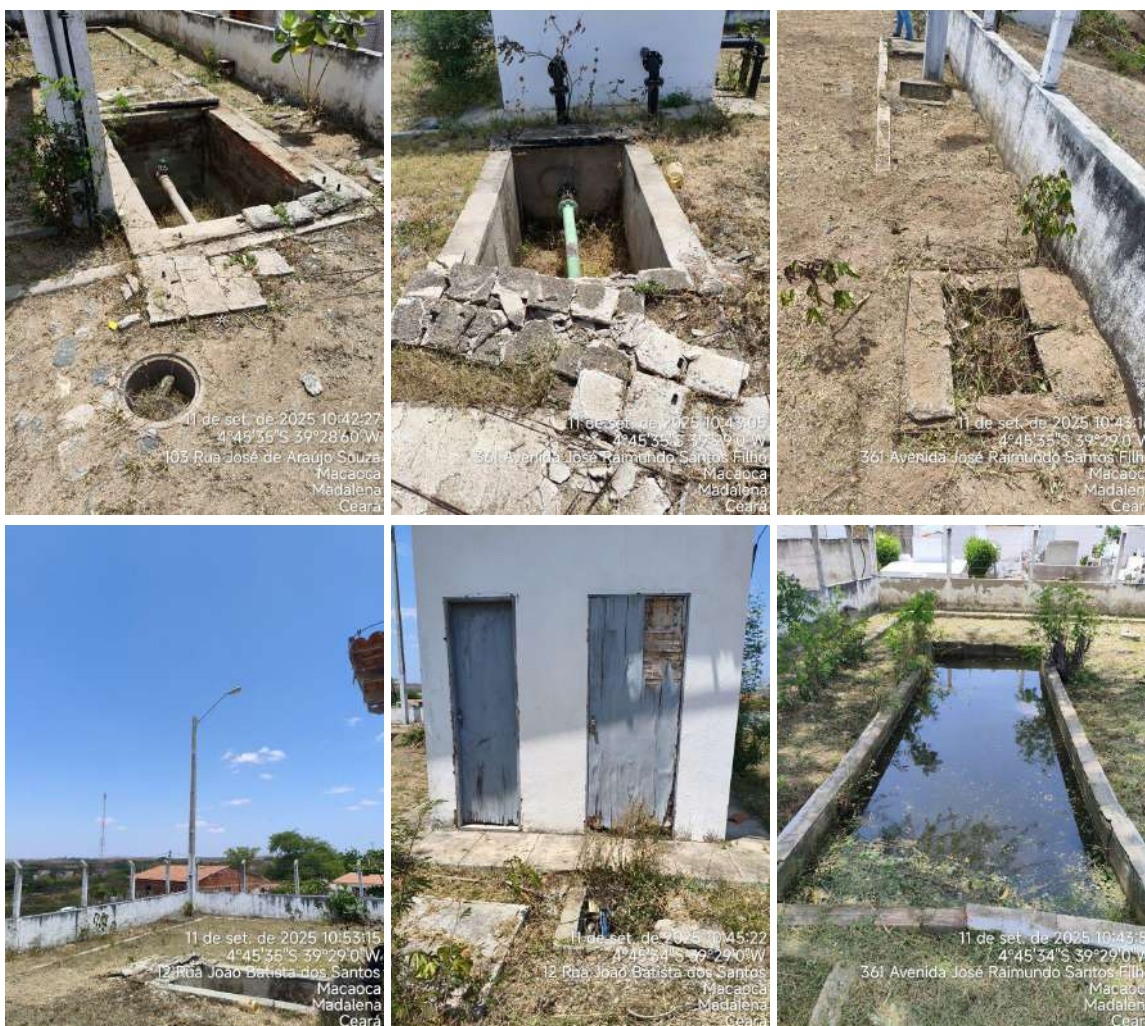
Figura 18 - Reservatório Elevado - Localidade de Macaoca: caixas sem tampa e sinais de extravasamento.
