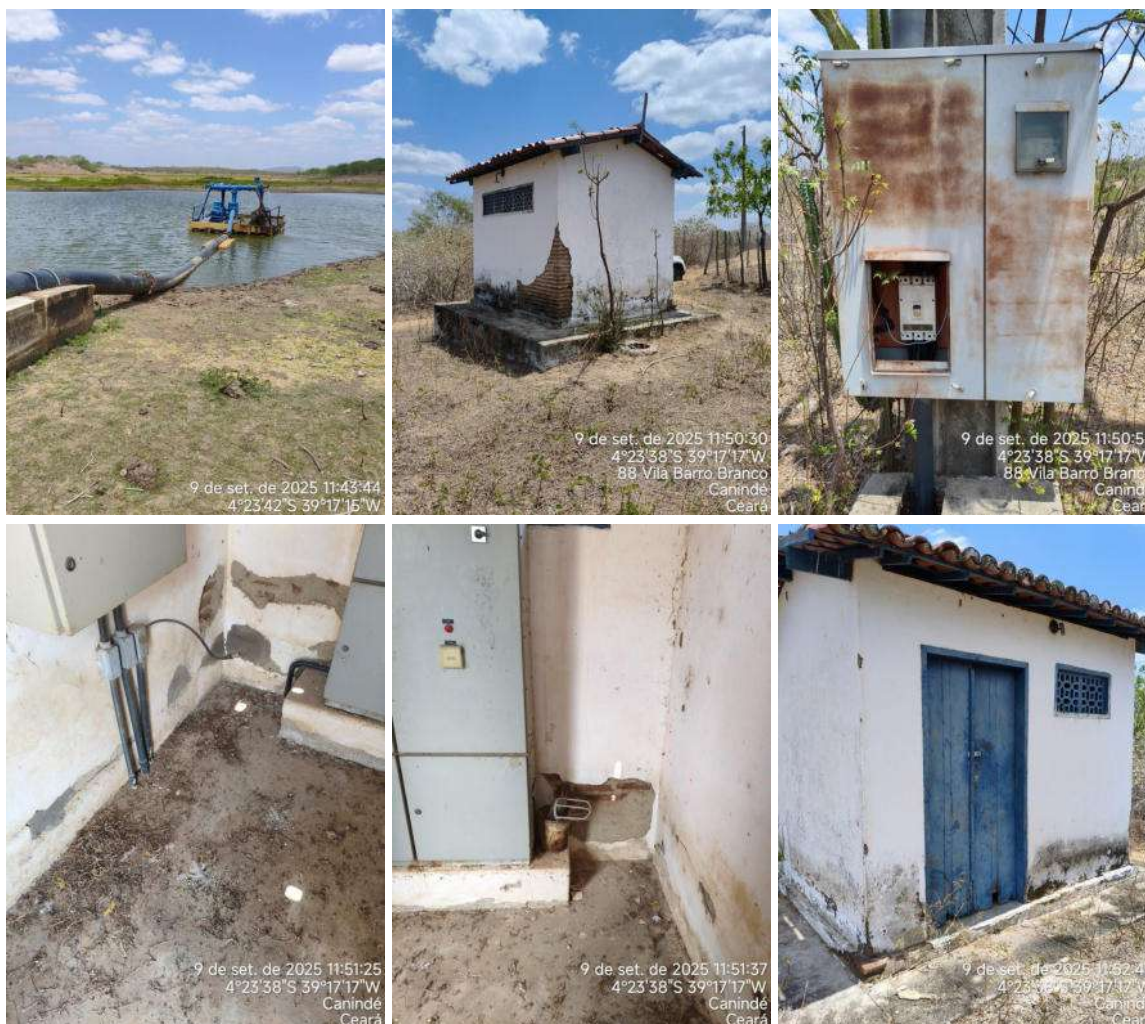
Figura 11 - Captação Açude Souza – Oportunidades de Melhorias.
