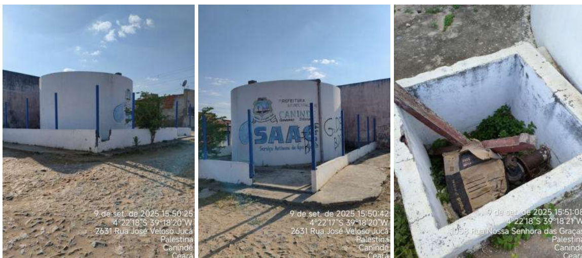
Figura 31 - Reservatório Apoiado - Palestina.
