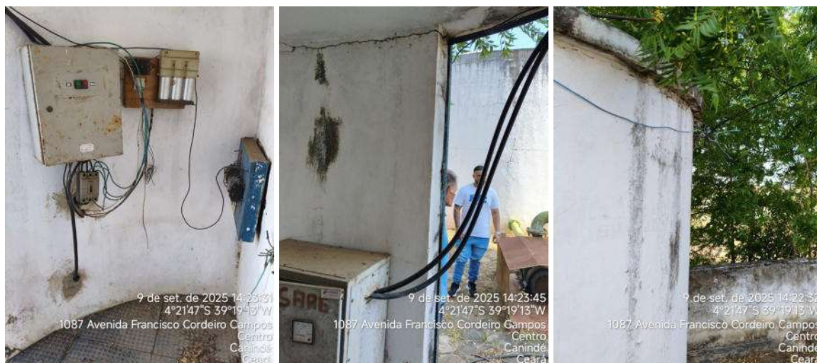
Figura 19 - ETA Antiga – Oportunidades de Melhorias – Casa dos Quadros de Bombas.
