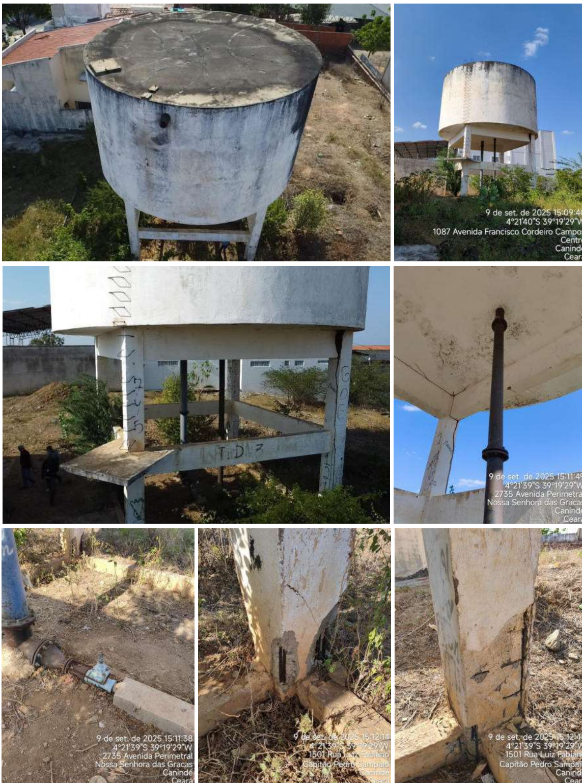
Figura 27 - Reservatório Elevado - CAN.
