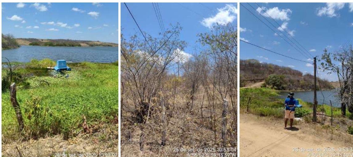
Figura 16 - Manancial / Captação do SAA da localidade de Baixio.
