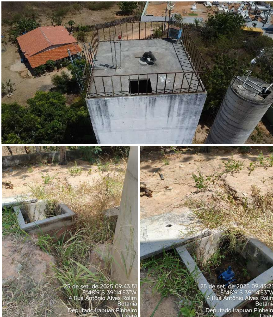
Figura 15 - Reservatório Elevado / Distrito de Betânia - Oportunidades de melhorias.
