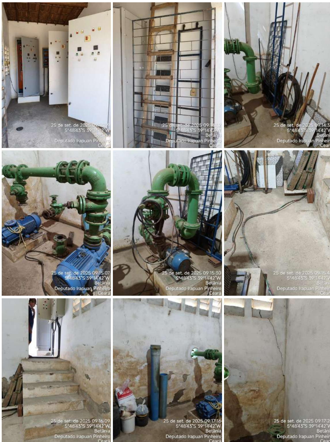
Figura 13 - ETA / Casa dos Quadros de Comando e de Bombas - Oportunidades de Melhorias.
