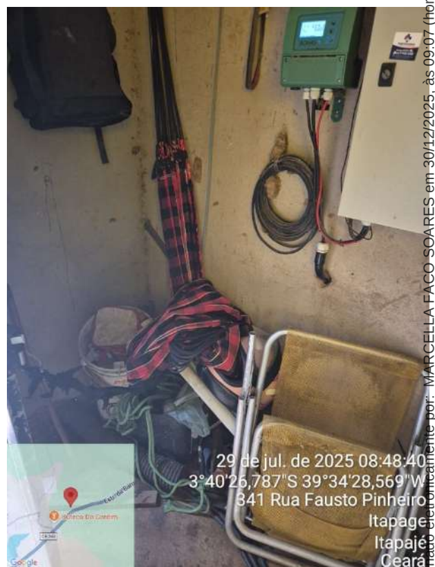
Foto 22 - Acúmulo de material inadequado, sem móveis de apoio.
