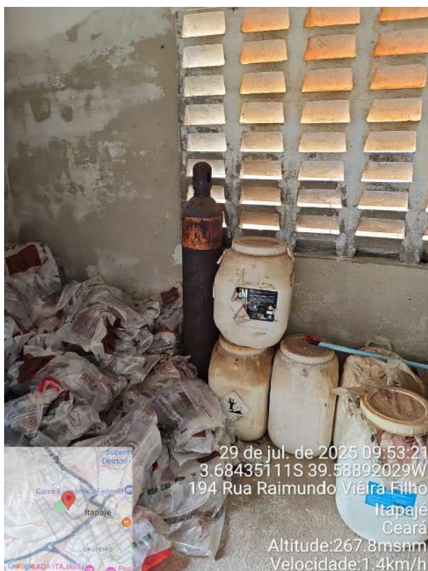
Foto 48 - Casa de química com acúmulo de material de descarte.
