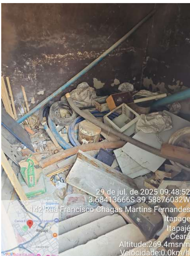
Foto 37 - Material disposto inadequadamente..
