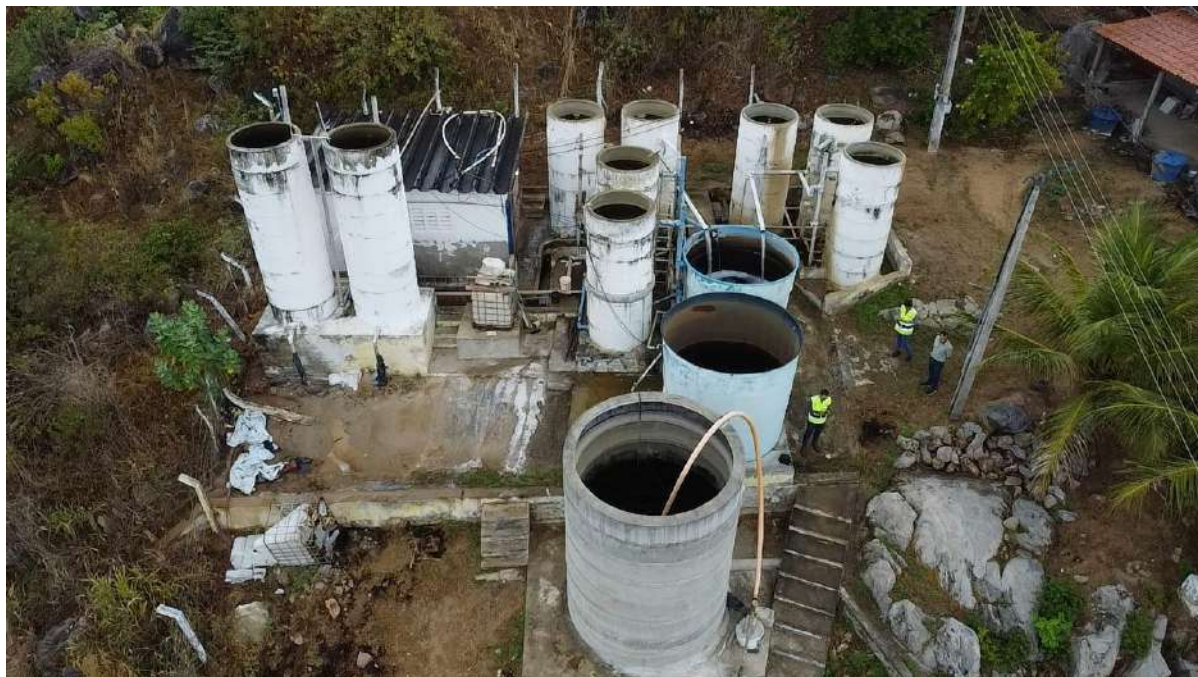
Foto 7 - ETA Iratinga - Instalações.
