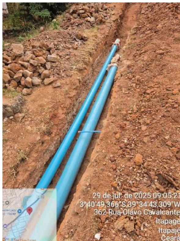
Foto 10 - Obra da adutora.
