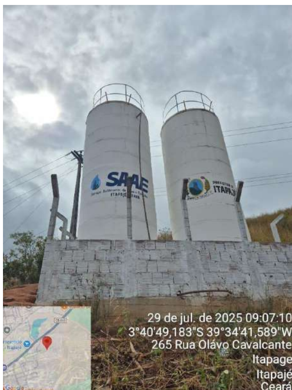
Foto 11 - REL Bela Vista (em implementação).
