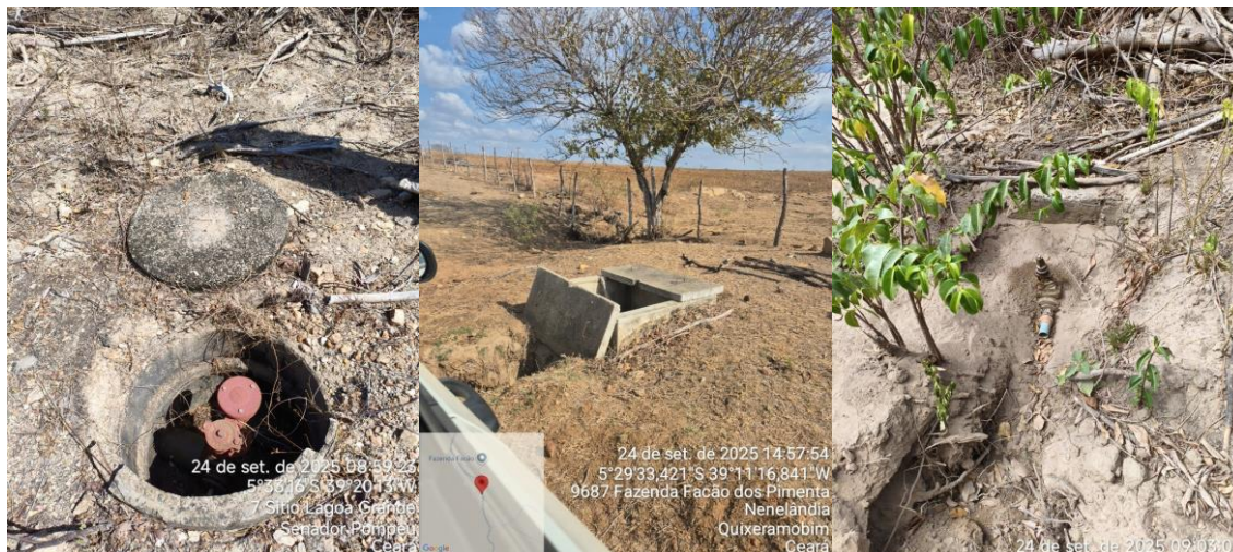
Figura 9 - Elevatória Jenipapeiro - Reservatório Apoiado.
