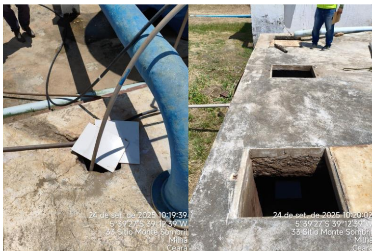
Figura 13 - ETA / Sede - Reservatório Apoiado.
