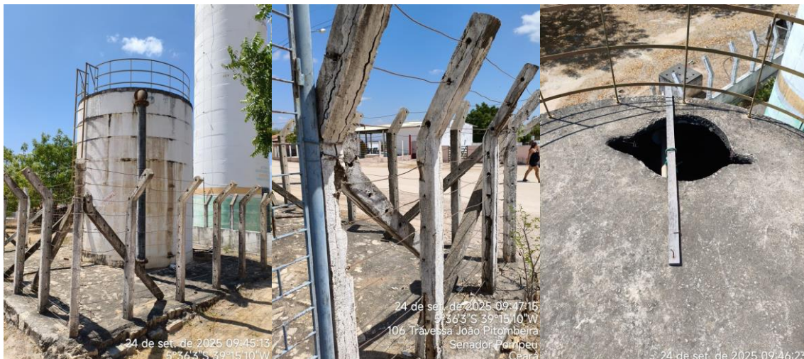
Figura 15 - Elevatória Jenipapeiro - Reservatório Apoiado.
