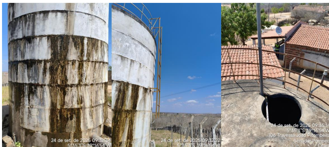
Figura 8 - Elevatória Jenipapeiro - Reservatório Apoiado.
