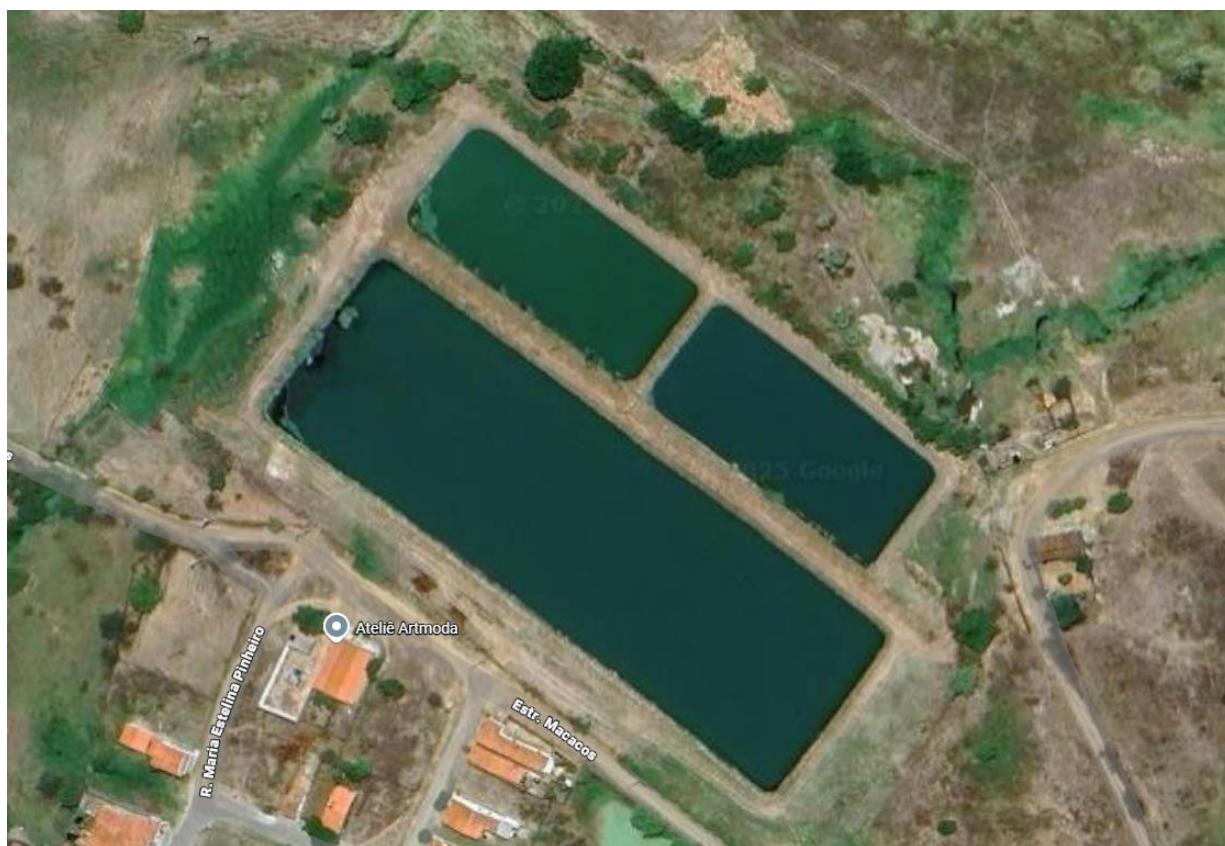
Figura 25 - Estação de Tratamento de Esgotos da Sede de Milhã - Vista Geral.
