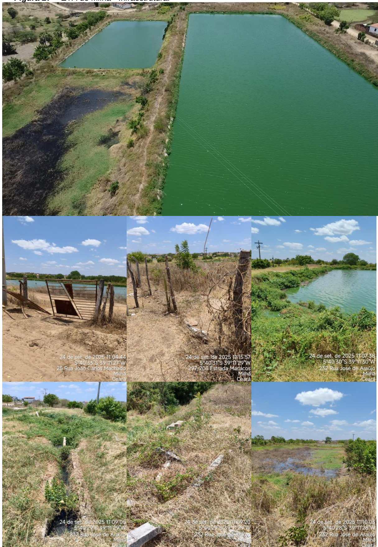
Figura 27 - ETA de Milhã - Infraestrutura.
