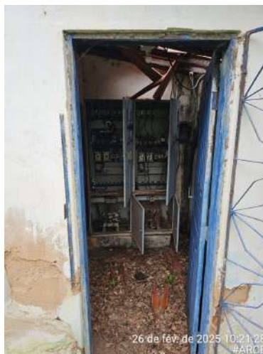
Foto 3 - Casa de Comando da Captação.
