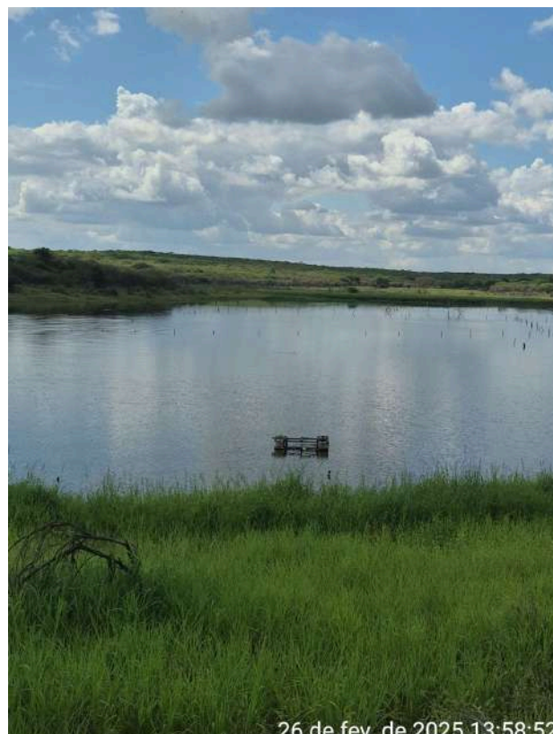
Foto 48 - Captação: Vegetação alta em volta do Açude da Campina.
