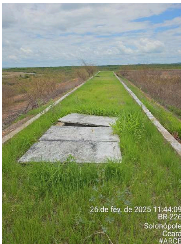
Foto 29 - Estação de Tratamento de Esgoto.
