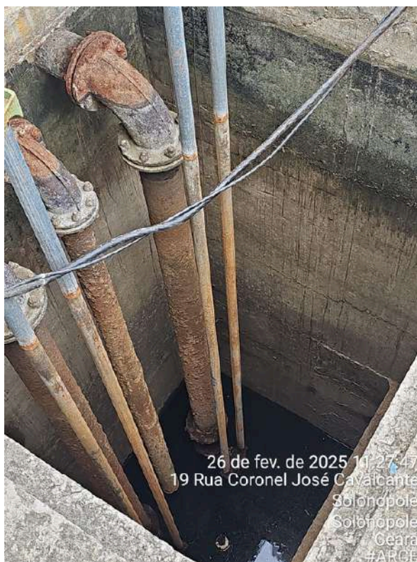
Foto 25 - Estação Elevatória - Fosso.
