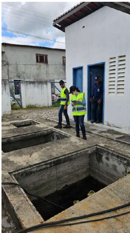
Foto 23 - Estação Elevatória - Estrutura.
