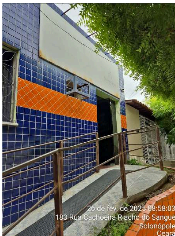
Foto 36 - Entrada do SAAE com rampa de acessibilidade.
