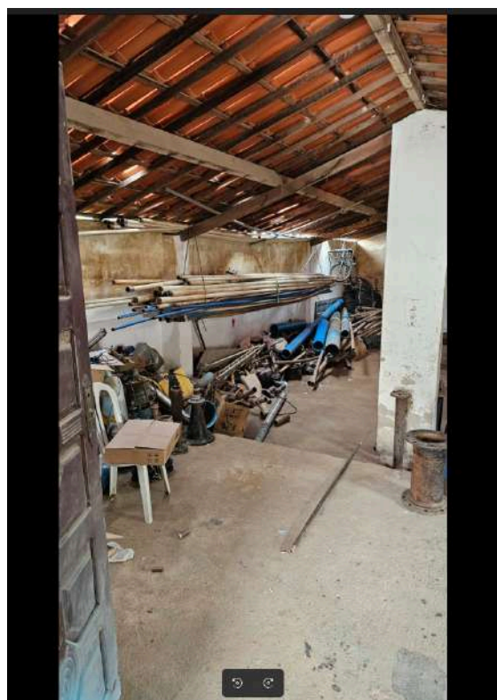
Foto 8 - Armazenamento das tubulações.
