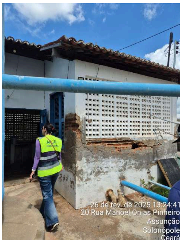
Foto 45- Parede deteriorada.
