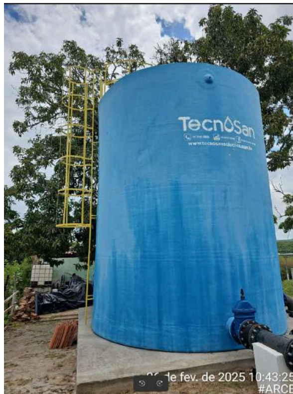
Foto 10 - Decantador em processo de instalação.
