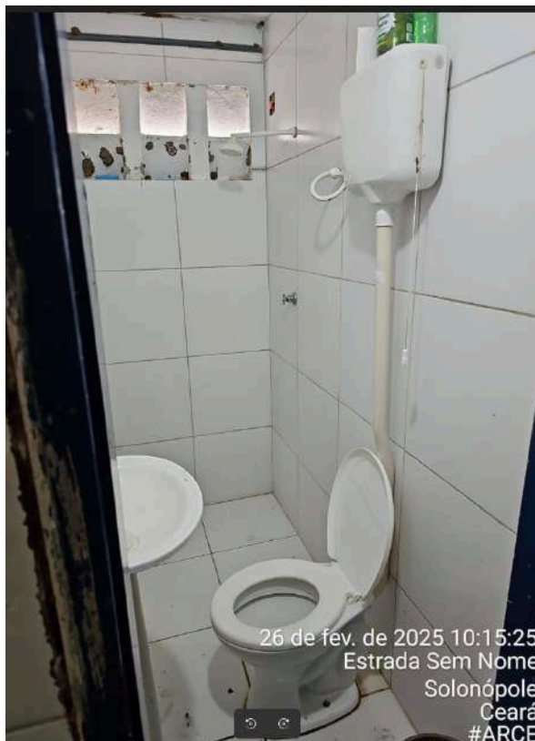
Foto 17 - Banheiro do Operador.
