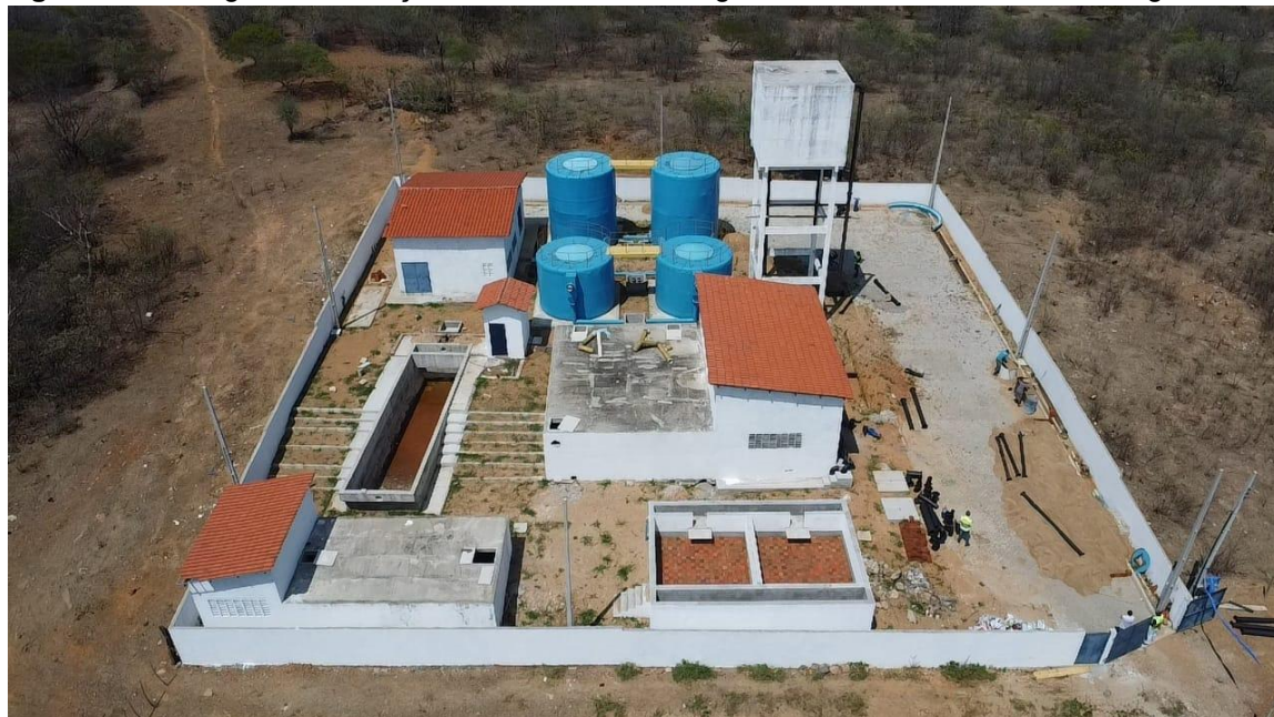
Figura 8 - Vista geral da Estação de Tratamento de Água do SAAE de São João do Jaguaribe.
