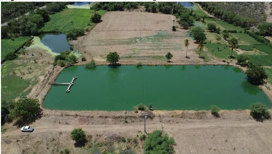
Figura 12 - ETE - SES da Sede de São João do Jaguaribe.
