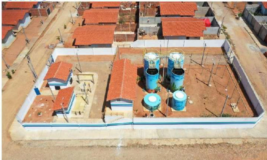
Figura 5 - ETE São Bento II.
