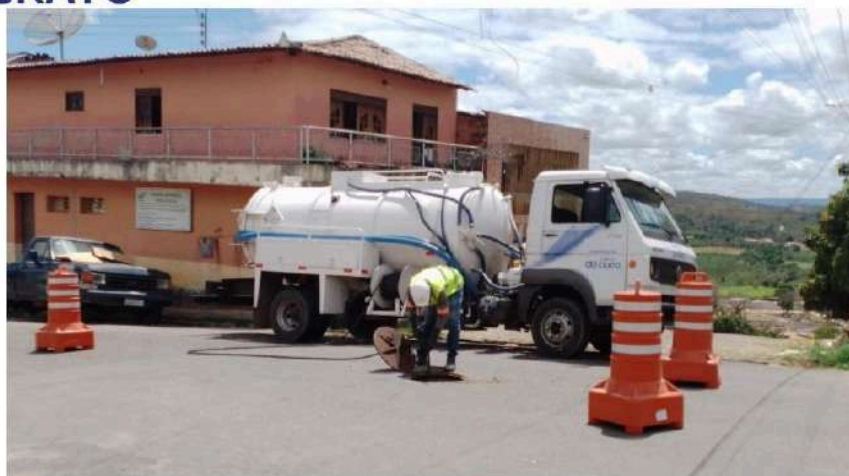
Figura 1 - Serviço de limpeza e desobstrução da rede.
