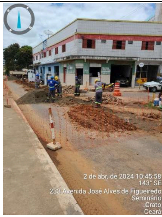
Foto 2 – Trecho interceptor margem direita rio Grangeiro
