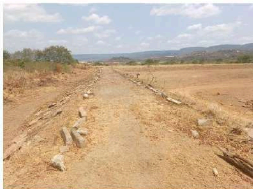
Foto 07. Talude divisor entre a primeira e segunda lagoa de estabilização.
