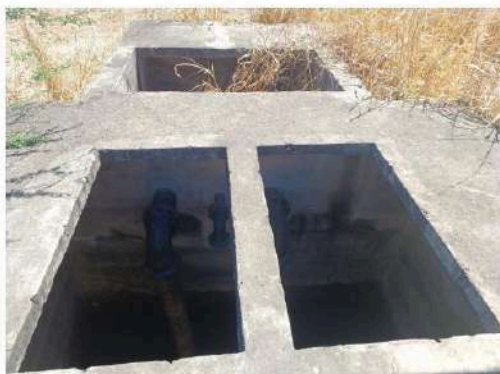
Foto 05. Poço de sucção.
