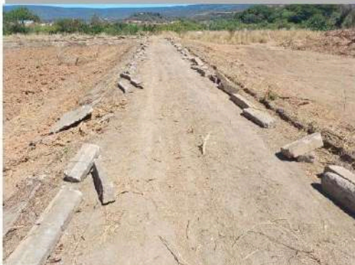
Foto 01. Taludes para recuperação ao redor das lagoas de estabilização.
