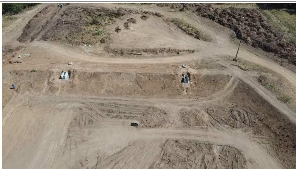
Vista da saída do efluente final
