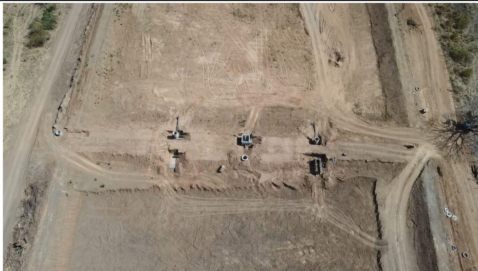
Vista das caixas de passagem entre as lagoas
