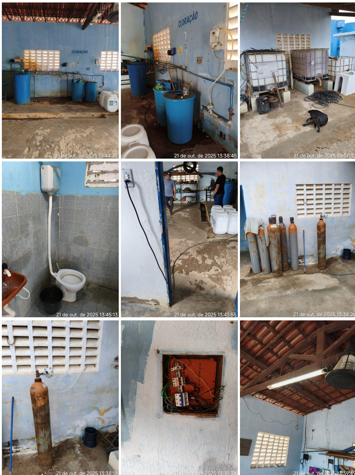
Figura 11 - ETA - Casa de Química ou Tratamento.
