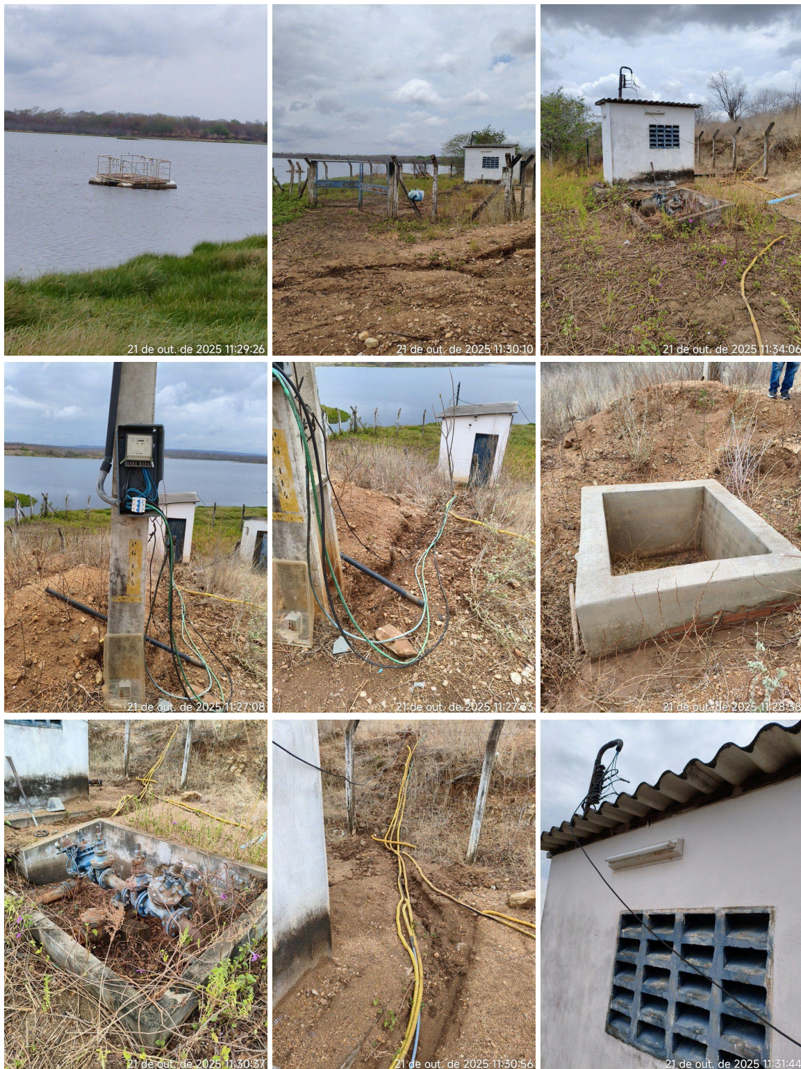
Figura 4 - Captação Açude Benguê - Infraestrutura.
