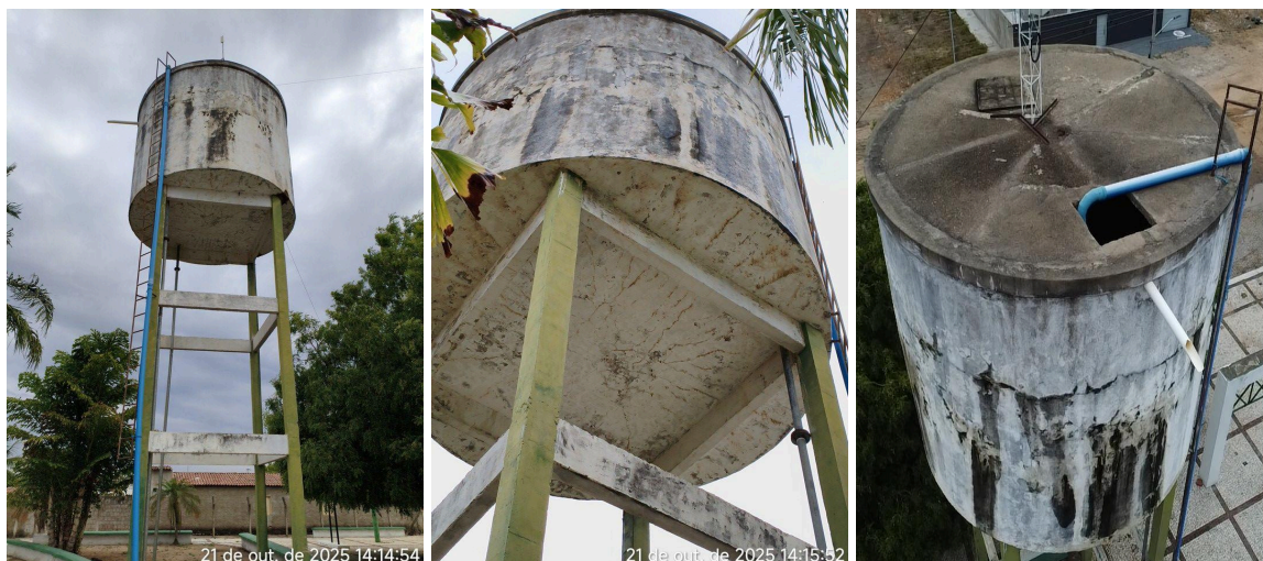
Figura 15 - Reservatório Elevado - Centro de Eventos.
