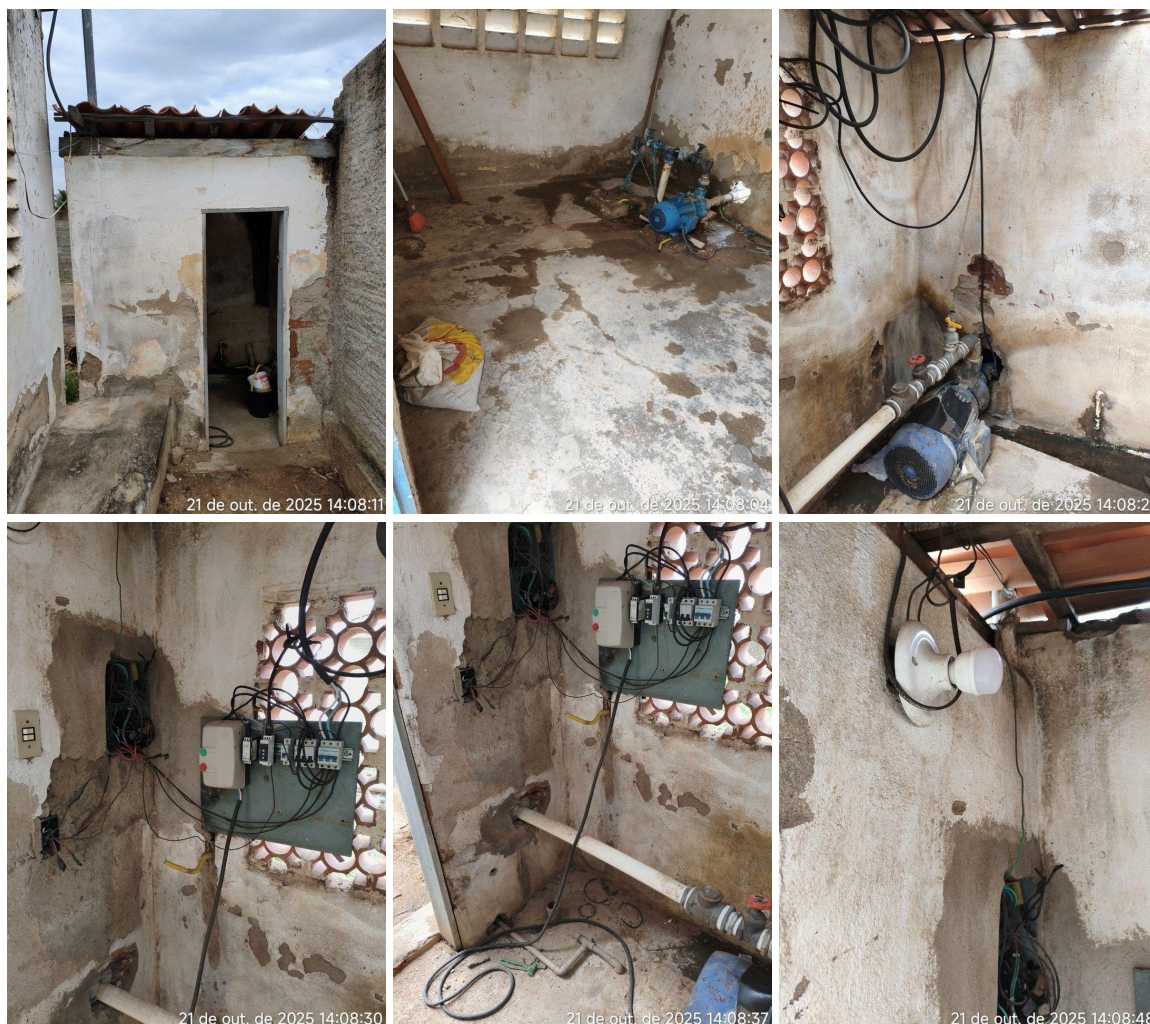
Figura 16 - Reservatório Apoiado - CRAS - Casa de Bombas.
