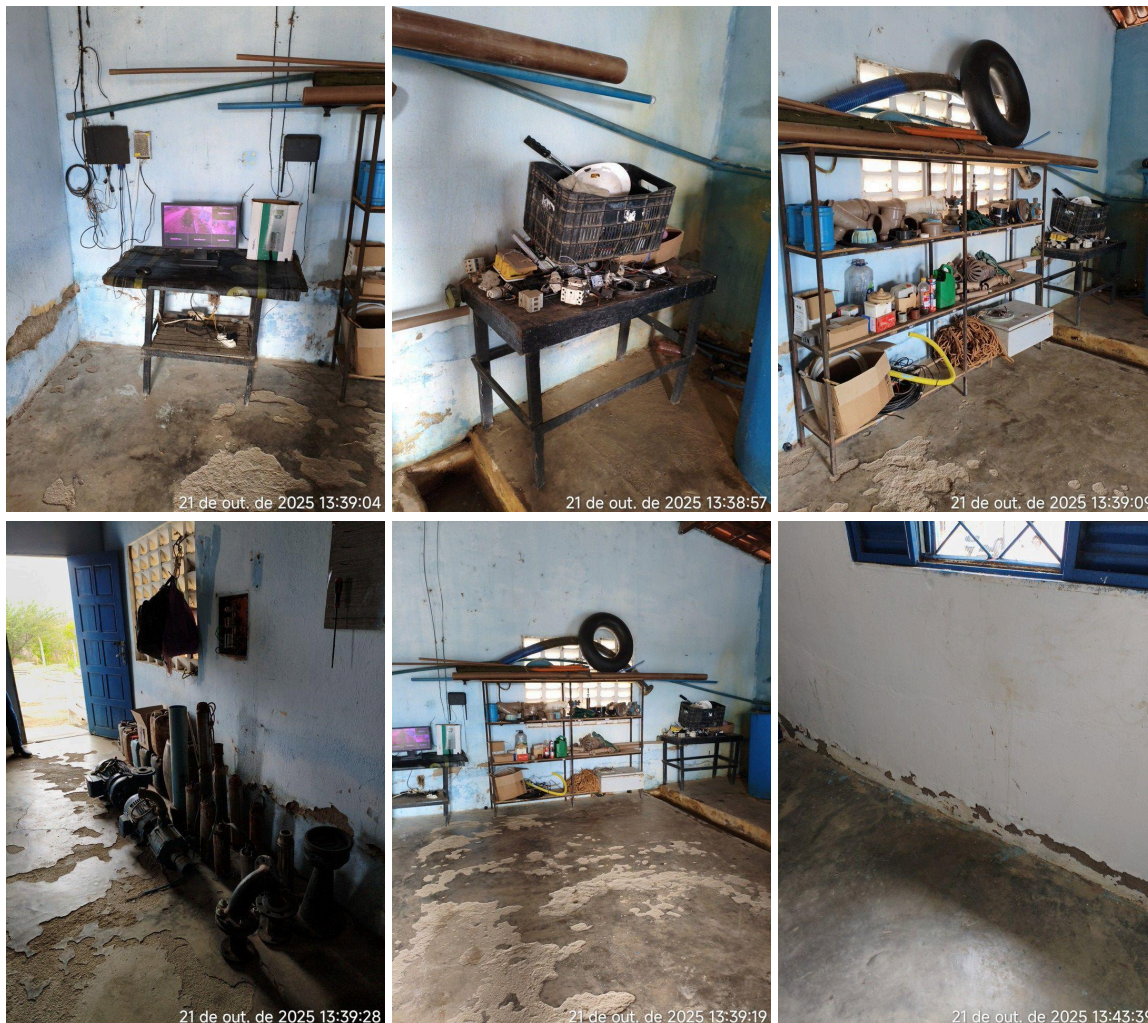
Figura 12 - ETA - Casa de Apoio e Almoxarifado na área da Casa de Química ou Tratamento.
