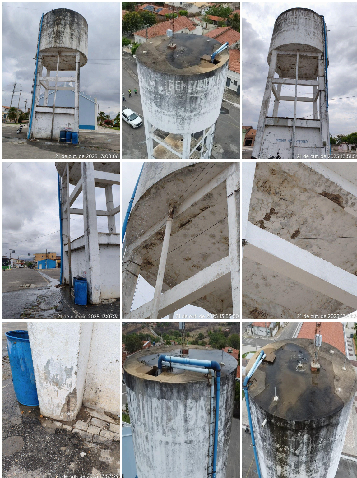
Figura 14 - Reservatório Elevado - Centro.
