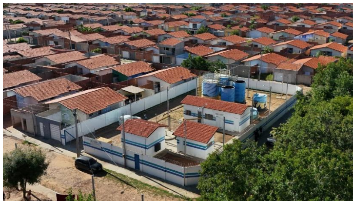
Figura 4 - ETE São Bento II
