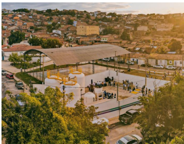
Figura 5 - ETE Pantanal após reativação
