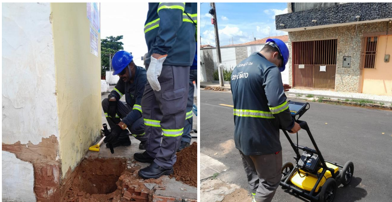
Figura 11 - Equipe do VCG em campo e uso de georradar para localização dos ramais de água
