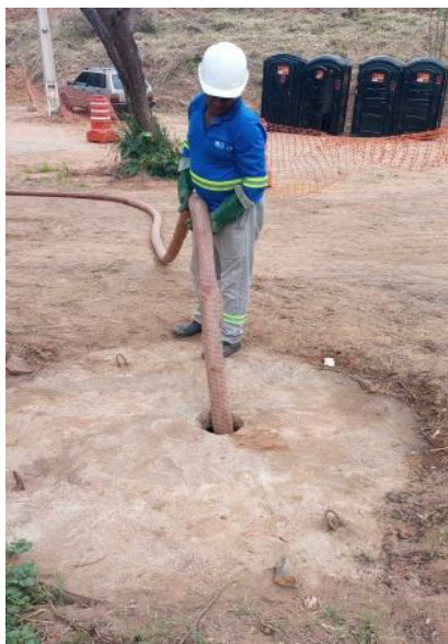
Figura 8 - Execução esgotamento de efluentes – Festival Expocrato 2025
