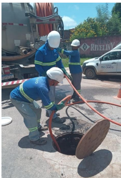
Figura 7 - Execução de trecho com hidrojateamento
