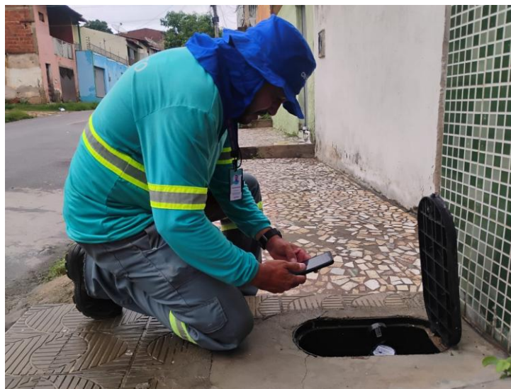
Figura 10 - Execução de leitura de hidrômetro
