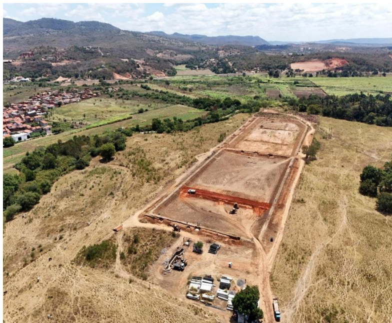
Figura 6 – Limpeza da área da ETE Granjeiro
