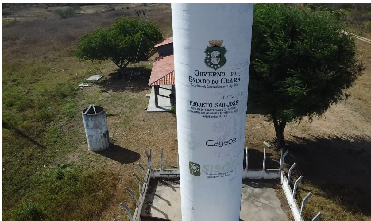
Figura 4 – Reservatório elevado de 25 m 3
